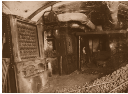
Historisches Foto (undatiert) des alten Heizhauses im Keller des NHM
