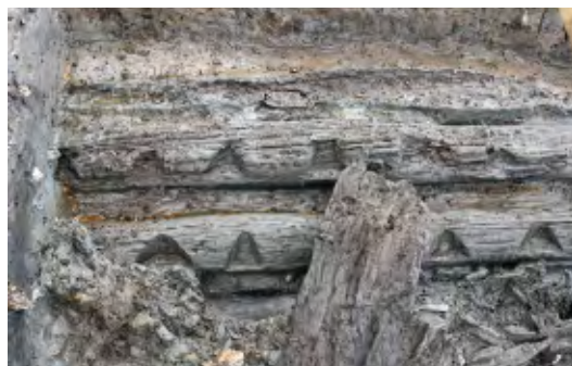
Detail der Holzkonstruktion mit trapezförmigen Einkerbungen
