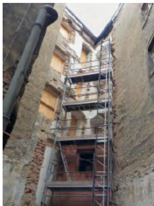
Abrissarbeiten ehemalige Sanitäranlagen
