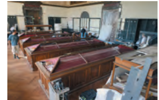
Arbeiten im Saal 5
