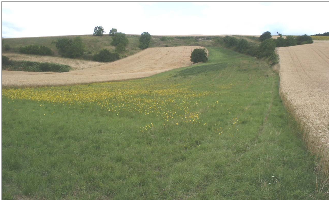
Abb. 6: Massenbewegung Ost Merkersdorf; Rutschungen in „eisenschüssigen Tonen und Sanden“ (Eggenburg – Ottwang der Waschbergzone); Abrisskante / Geländestufe verläuft etwa West–Ost.
