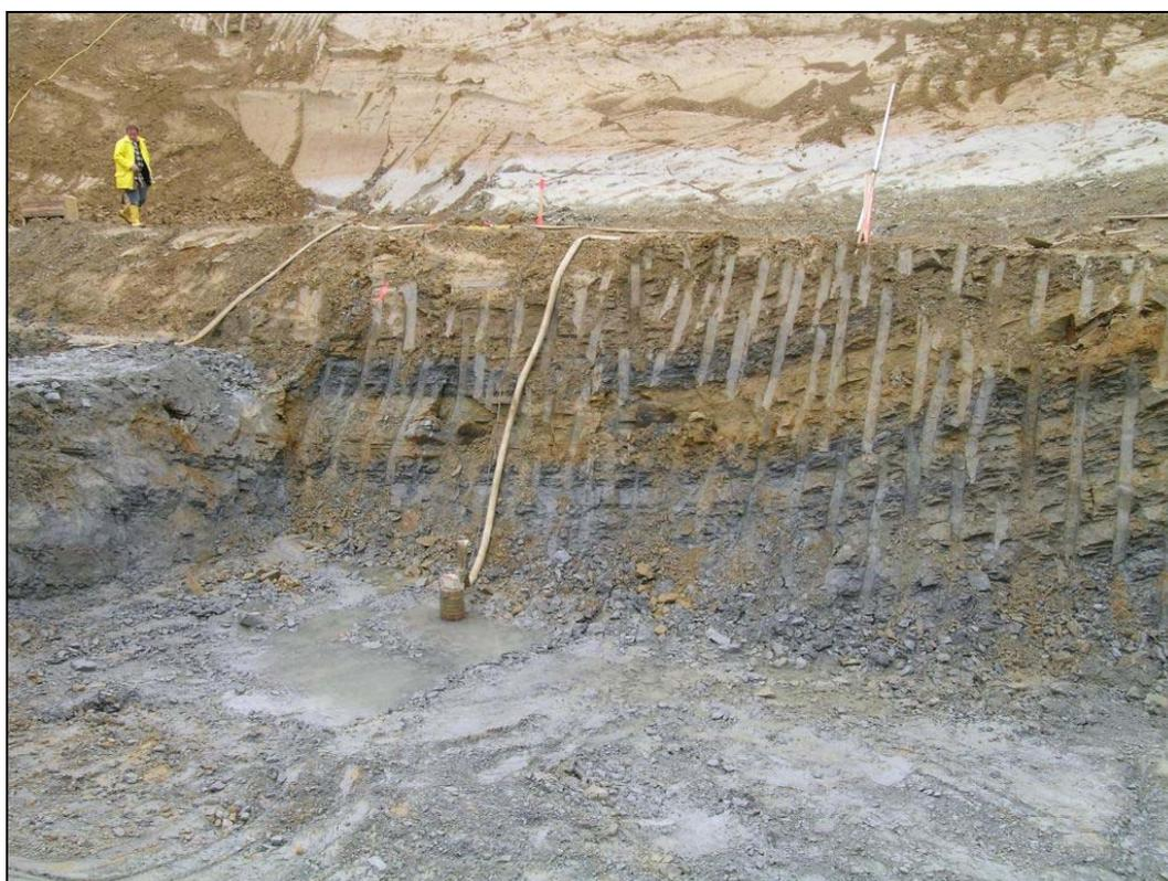
Abb. 3.1.7: Im unteren Abschnitt der Baugrube: dunkelgraue-braune Schluffsteine, Tonsteine und Sandsteine (Oncophora-Schichten, Ottnangium) (Foto: 04/05/2005)
