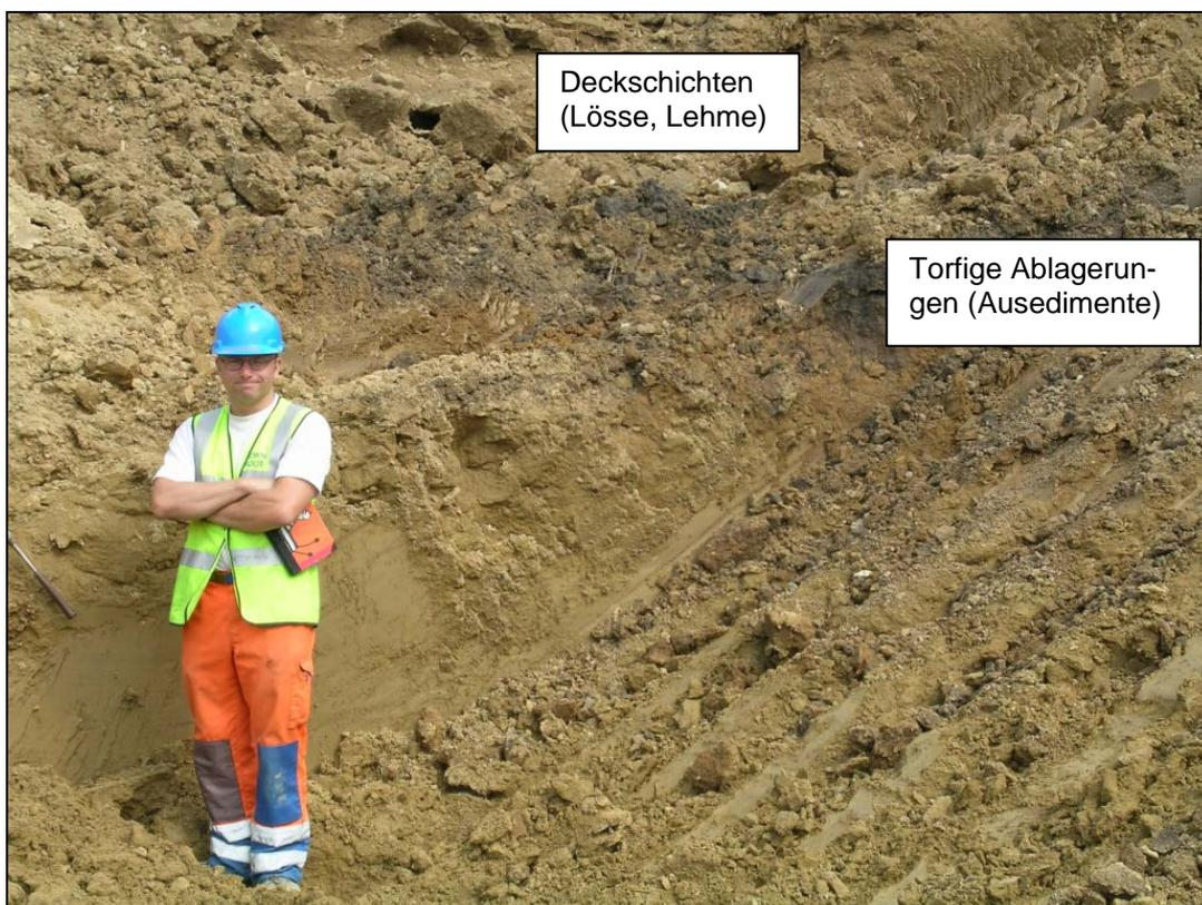
Abb. 3.1.12: Torfige Sedimente innerhalb der Deckschichten, Baugrube SW Maria Jeutendorf (Foto: 21/07/2005)
