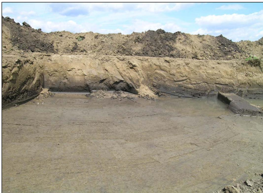
Abb. 3.1.23: Im archäologischen Grabungsbereich: hellbraune schluffig, sandige Deckschichten und dunkelbraune Tone („torfige“ Auablagerungen) (Foto: 21/05/2005)
