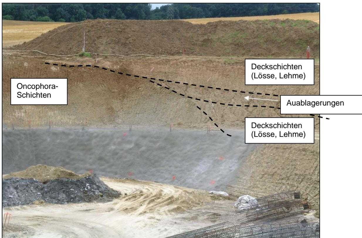
Abb. 3.1.11: Geologischer Aufbau der Baugrube SW Maria Jeutendorf (Foto: 21/07/2005)
