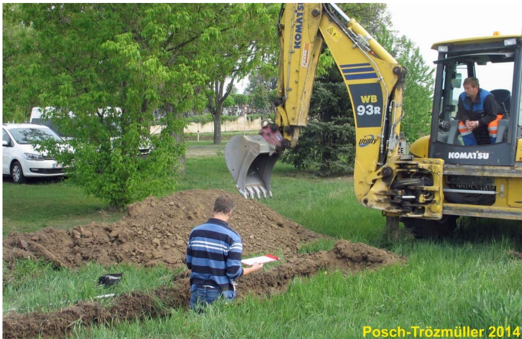
Abb. 2.1.63.: Lage von Schurf 1 im Norden der Trasse, Blickrichtung N.
