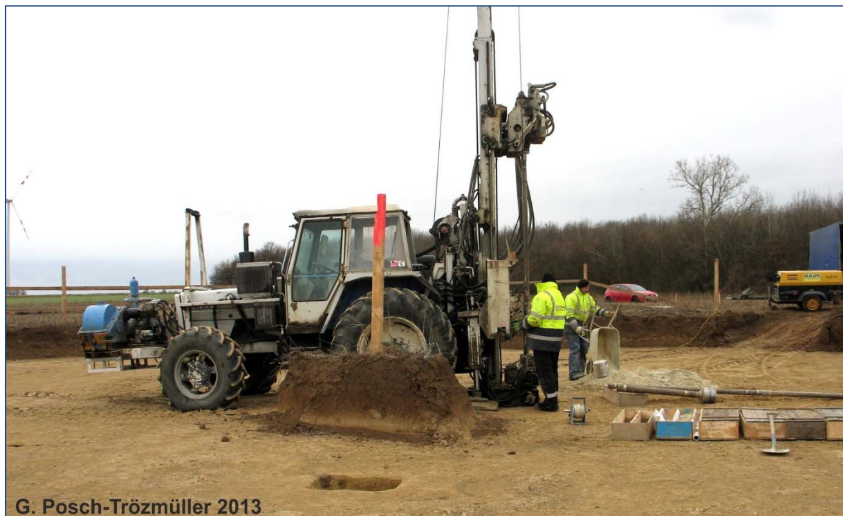
Abb. 2.4.4.: Bohrung SD III KB 1: Vor Einrichtung des Bohrplatzes wurden 80 cm des Untergrundes ausgehoben.
