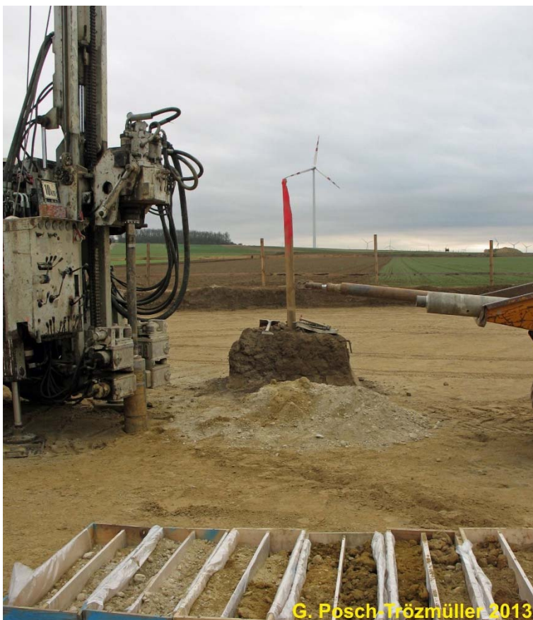
Abb. 2.4.13.: Bohrung SD III KB 3: 0,6 m wurden vor Einrichtung der Bohrstelle abgetragen.
