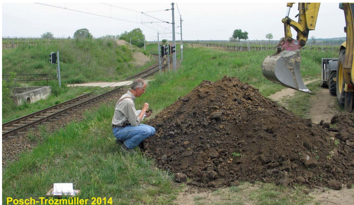
Abb. 2.1.75.: Lage von Schurf 6 wenige Meter neben der Bahn.
