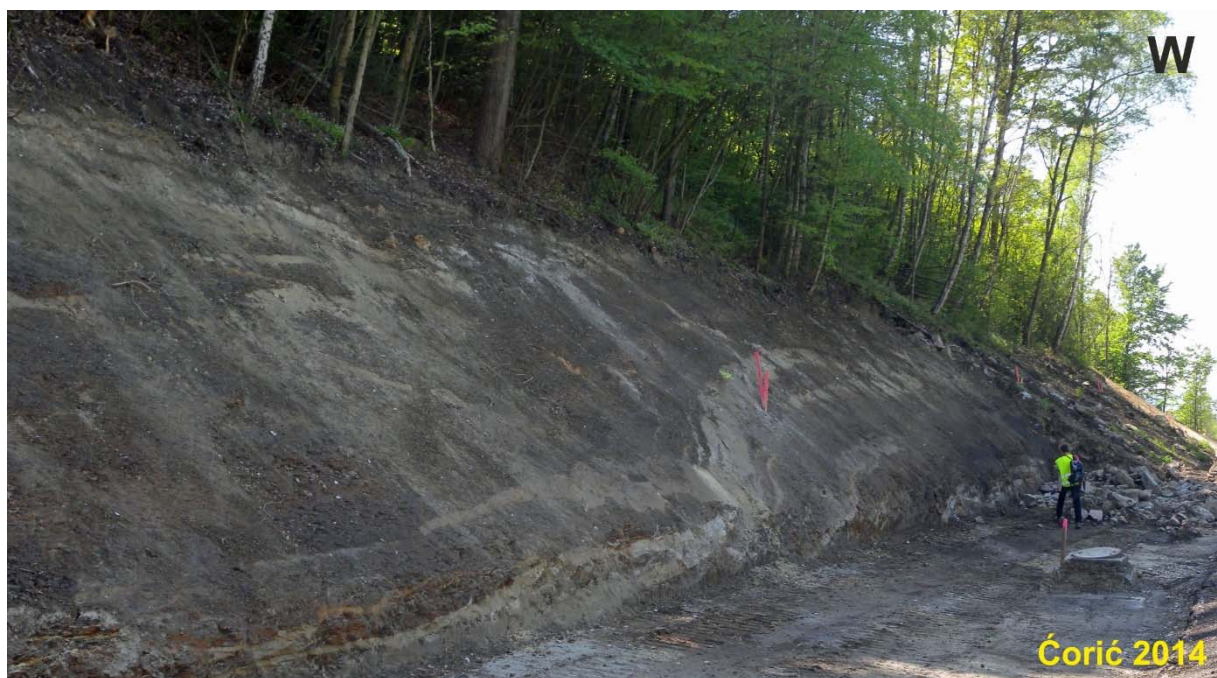
Abb. 2.1.10.: Sandlagen in den Schluffen und Tonen der Pielach-Fm.; rechts im Bild ist eine Hangsicherung zu sehen (unaufgeschlossen), unmittelbar davor liegt GPS 531.
