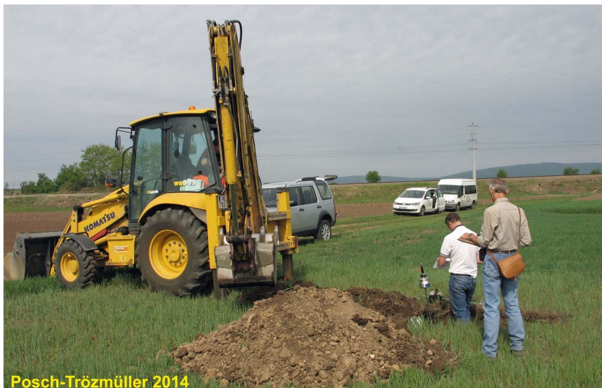
Abb. 2.1.68.: Lage von Schurf 3 nahe dem Bahndamm, Blickrichtung ca. N.
