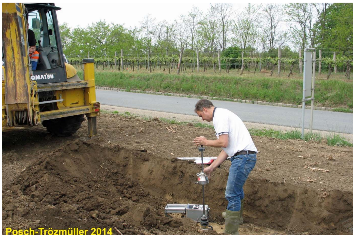
Abb. 2.1.70.: Lage von Schurf 4 neben der Straße Unterretzbach – Kleinhöflein.
