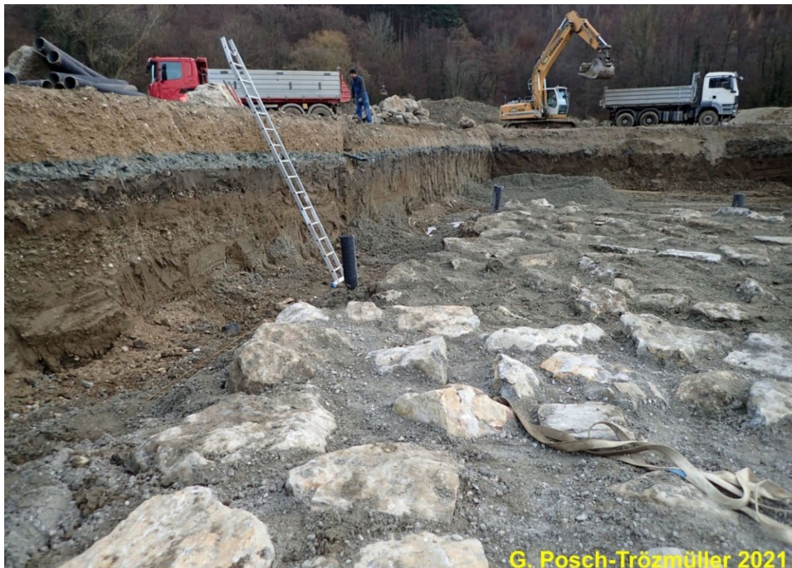
Abb. 125: Östliche Seite des Tosbeckens und Aufbau des Talbodens mit einer Überlagerung aus Anschüttung (hellbraune und graue Ablagerungen oberhalb der dunkelbraunen Schluffe).
