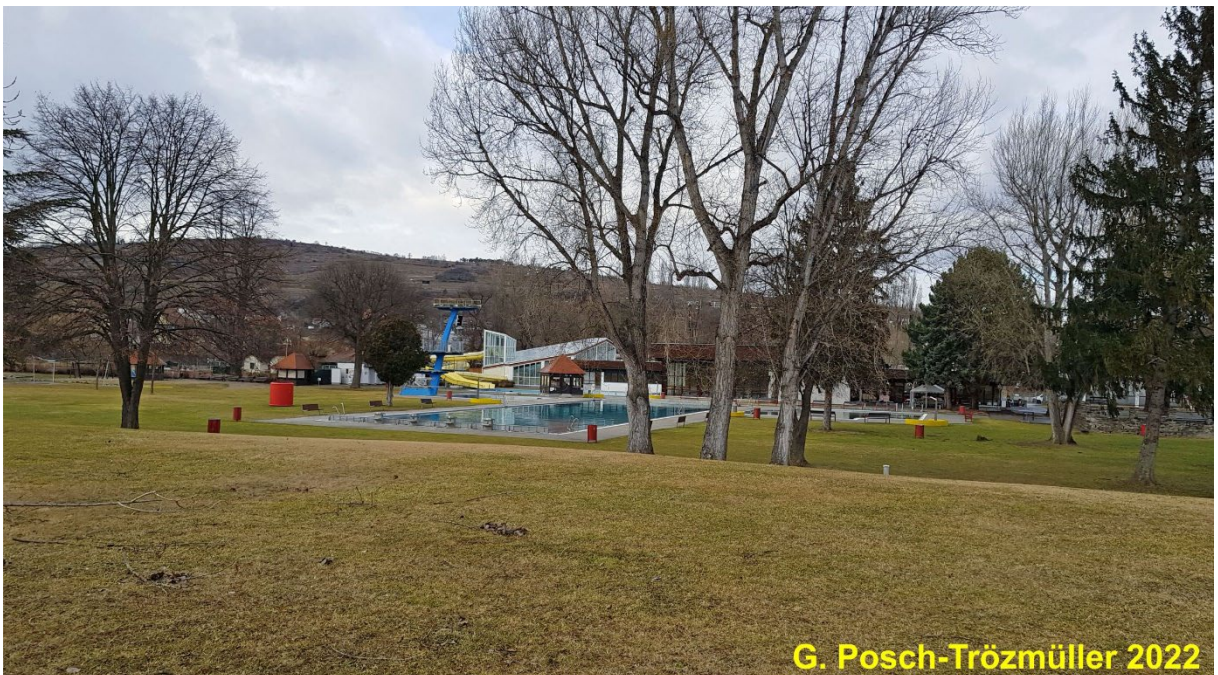
Abb. 22: Blick in die Badearena von der Donau-Promenade aus. Die Kernbohrungen wurden in der rechten Bildhälfte durchgeführt.
