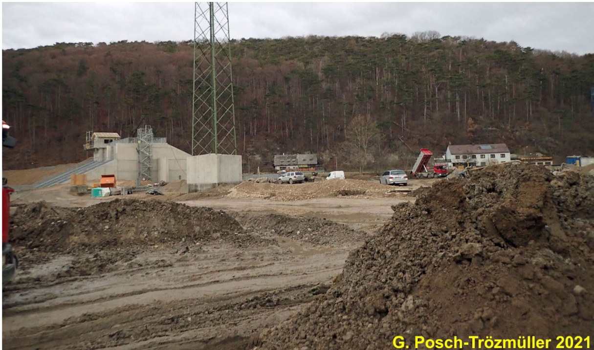
Abb. 130: Blick Richtung N von Schurf 2 aus, links im Bild ist das Auslaufbauwerk zu sehen.
