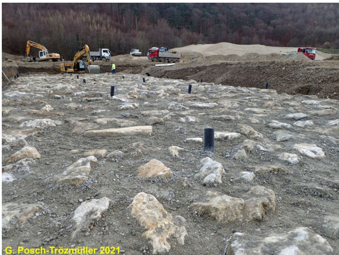
Abb. 126: Blick aus dem Tosbecken Richtung S.
