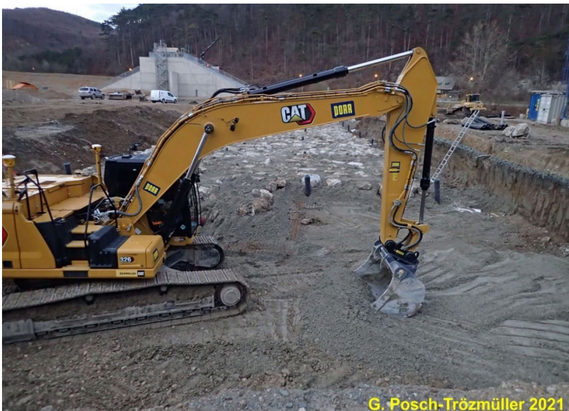
Abb. 124: Blick von S nach N in das Tosbecken.
