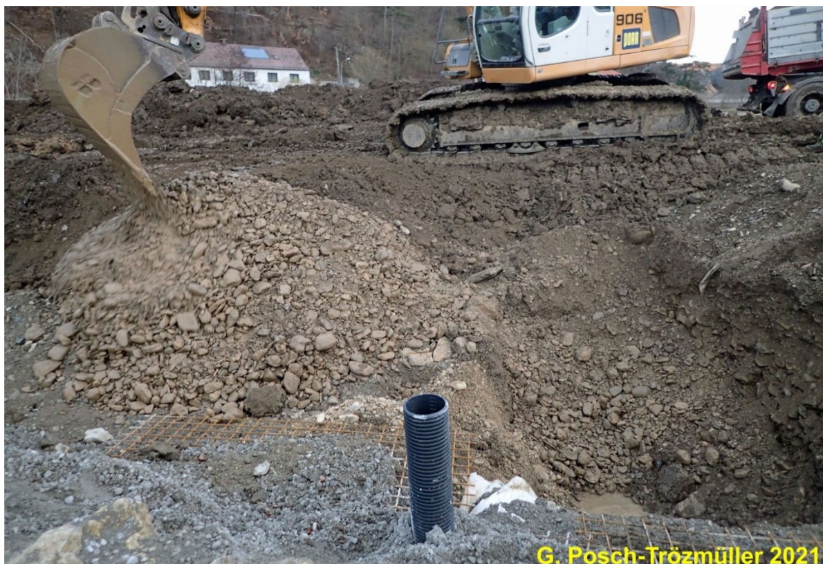
Abb. 128: Baggerschurf am unteren Rand des Tosbeckens: Kiessande der Talfüllung.
