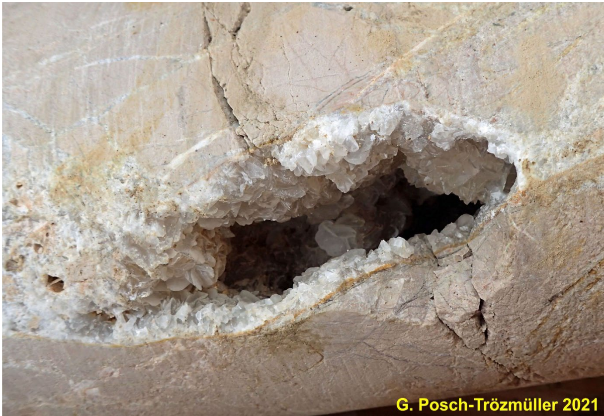
Abb. 118: Detail von KB 21/22: 9 m Tiefe: mit Calcitkristallen ausgekleideter Lösungshohlraum.
