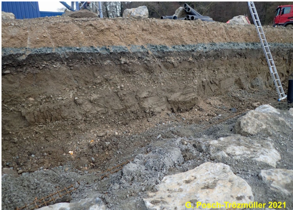
Abb. 127: Untergrundaufbau im Bereich des Schurfes: kiesigere und schluffigere, geschichtete Alluvionen. Bei der grauen Lage, sowie dem hellbraunen Kies darüber handelt es sich um Anschüttungen.
