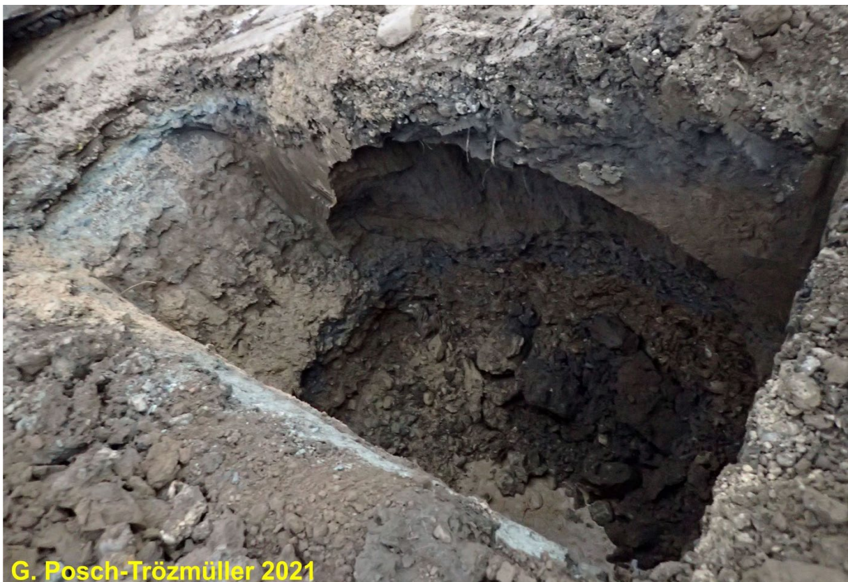
Abb. 133: Schurf 2: Schluffe und Kiessande der Talfüllung der Triesting, Wasser am Grunde des Schurfs.
