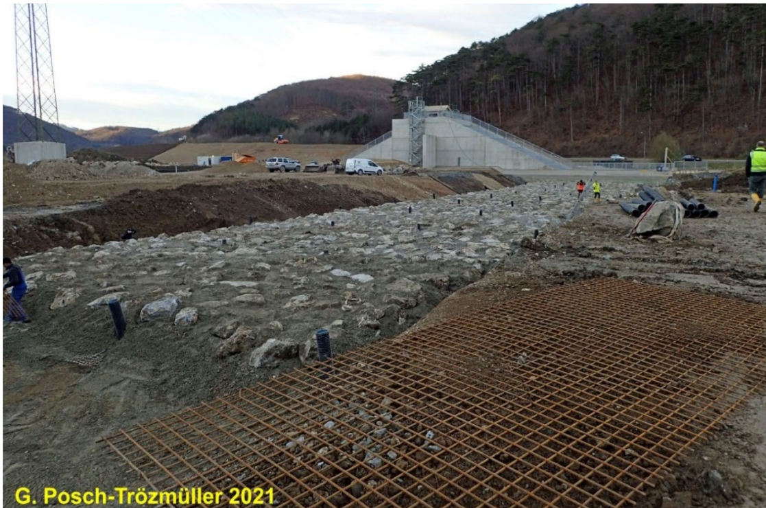
Abb. 123: Blick Richtung NW, im Vordergrund ist das Tosbecken zu sehen, das Bauwerk im Hintergrund ist das Auslaufbauwerk.
