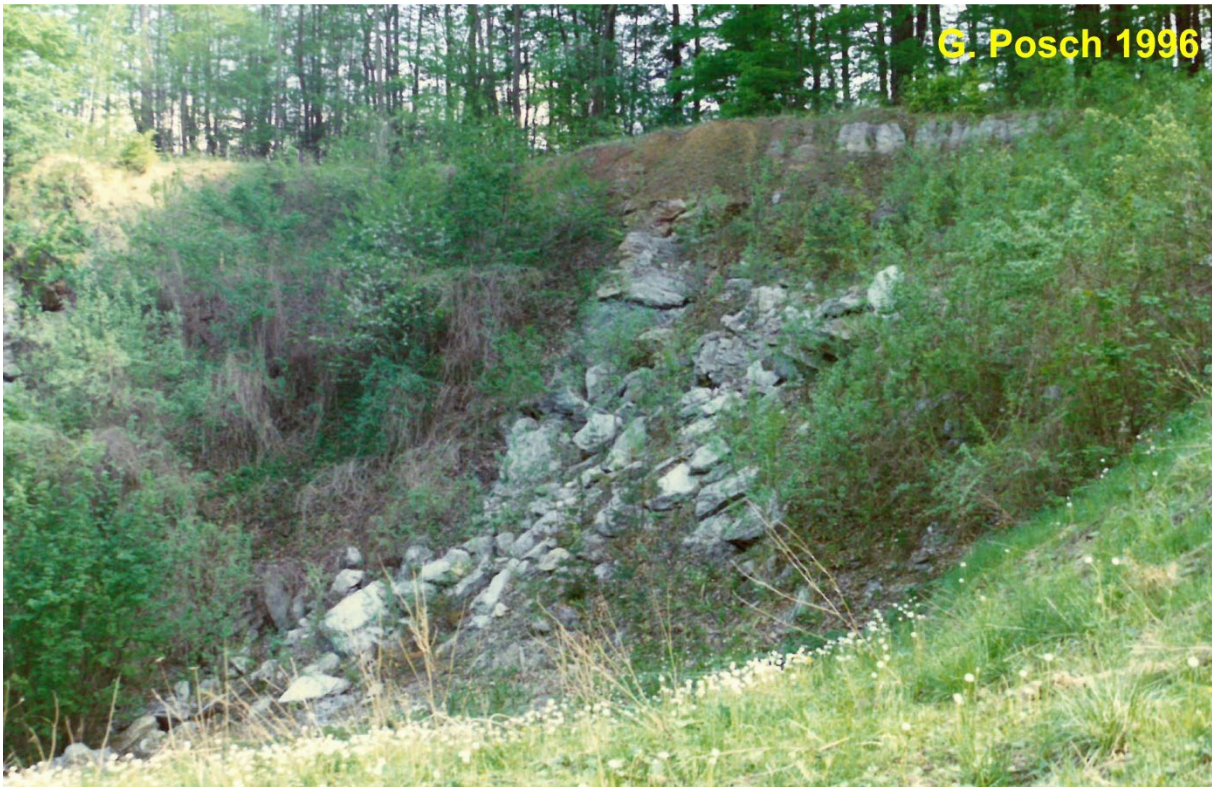
Abb. 2/220: Ehemaliger Gipsbergbau Füllenberg (058/034B), die Abbildung schließt rechts an Abb. 2/219 an.
