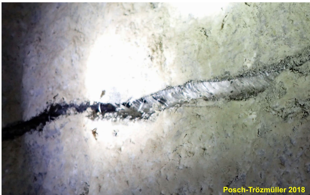
Abb. 2/189: Offene Kluft im Gips, teilweise bereits durch Fasergips verheilt auf Sohle 7.
