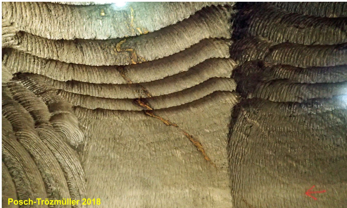
Abb. 2/184: Rotbraune Tonlage im Gips, welche eine Kluft bzw. Bewegungsfläche nachzeichnet auf Sohle 7.
