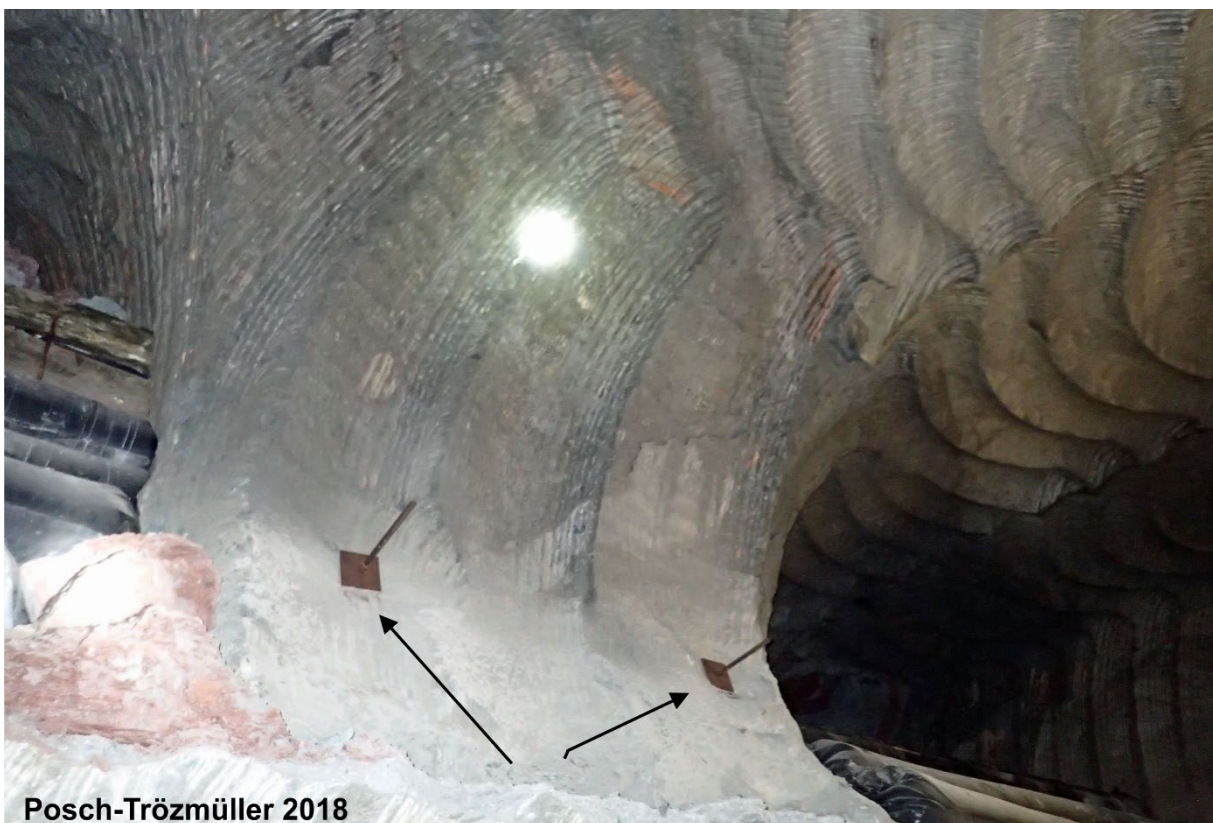
Abb. 2/187: Sicherungsmaßnahmen an einem versagensgefährdeten Pfeiler auf Sohle 7, um Abplatzungen zu verhindern.
