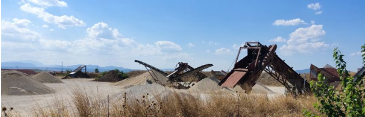
Abb. 2/152: Blick in den N-Abbaubereich (Foto: H. Reitner, 2022).
