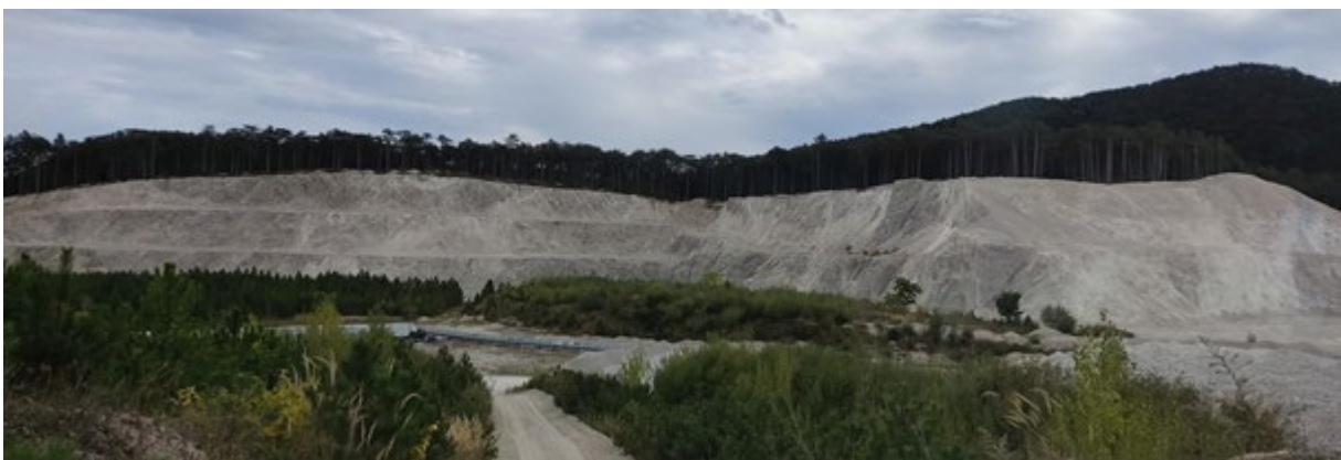
Abb. 2/110: Blick vom W Abbaubereich in Richtung E (Foto: H. Reitner, 2022).
