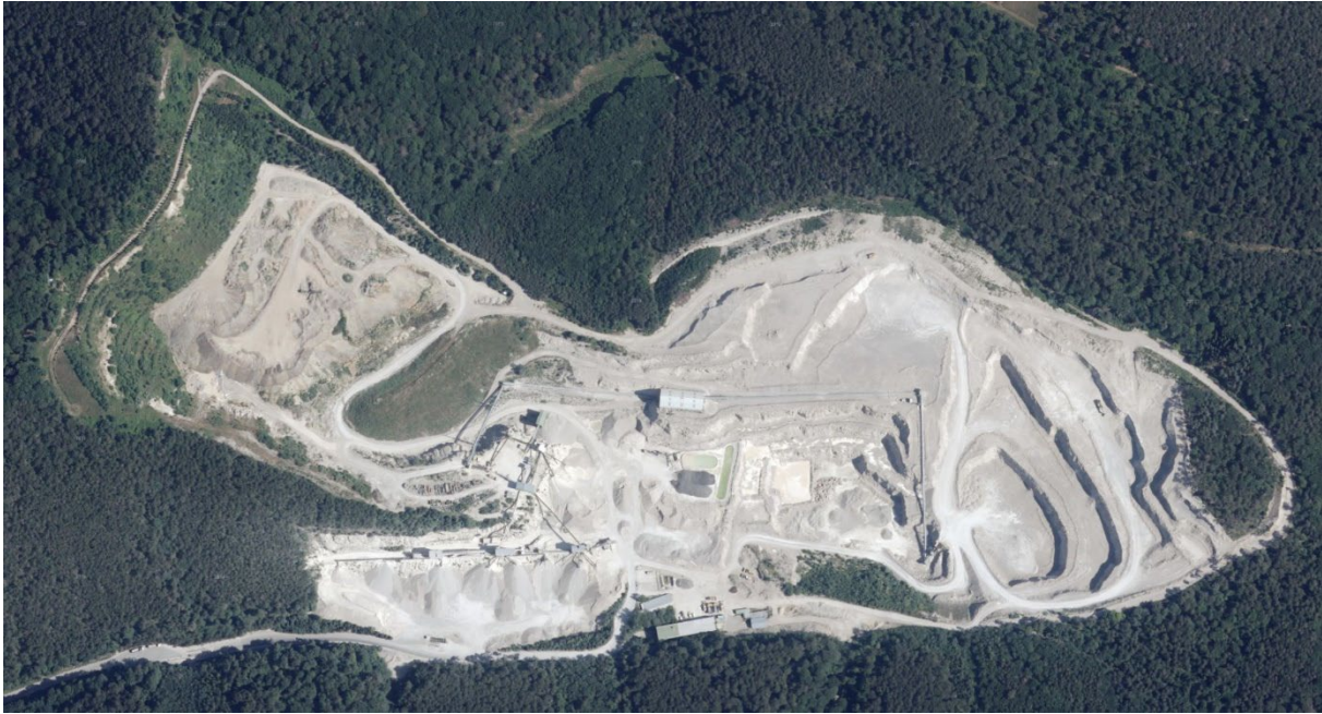
Abb. 2/31: Lage des Steinbruchs Gaaden auf einem Orthofoto (Quelle: www.basemap.at ).
