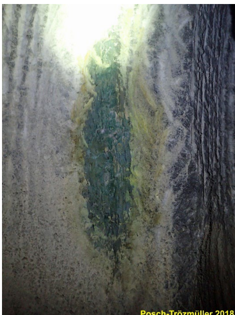
Abb. 2/199: Grünlich-gelber Belag (?organisch) an der Stollenwand der Sohle 7.
