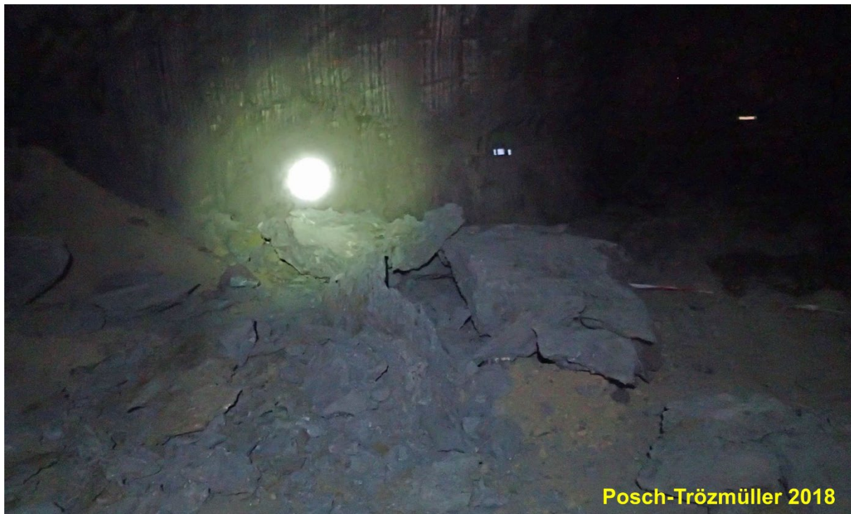
Abb. 2/188: Verbruch auf Sohle 7.
