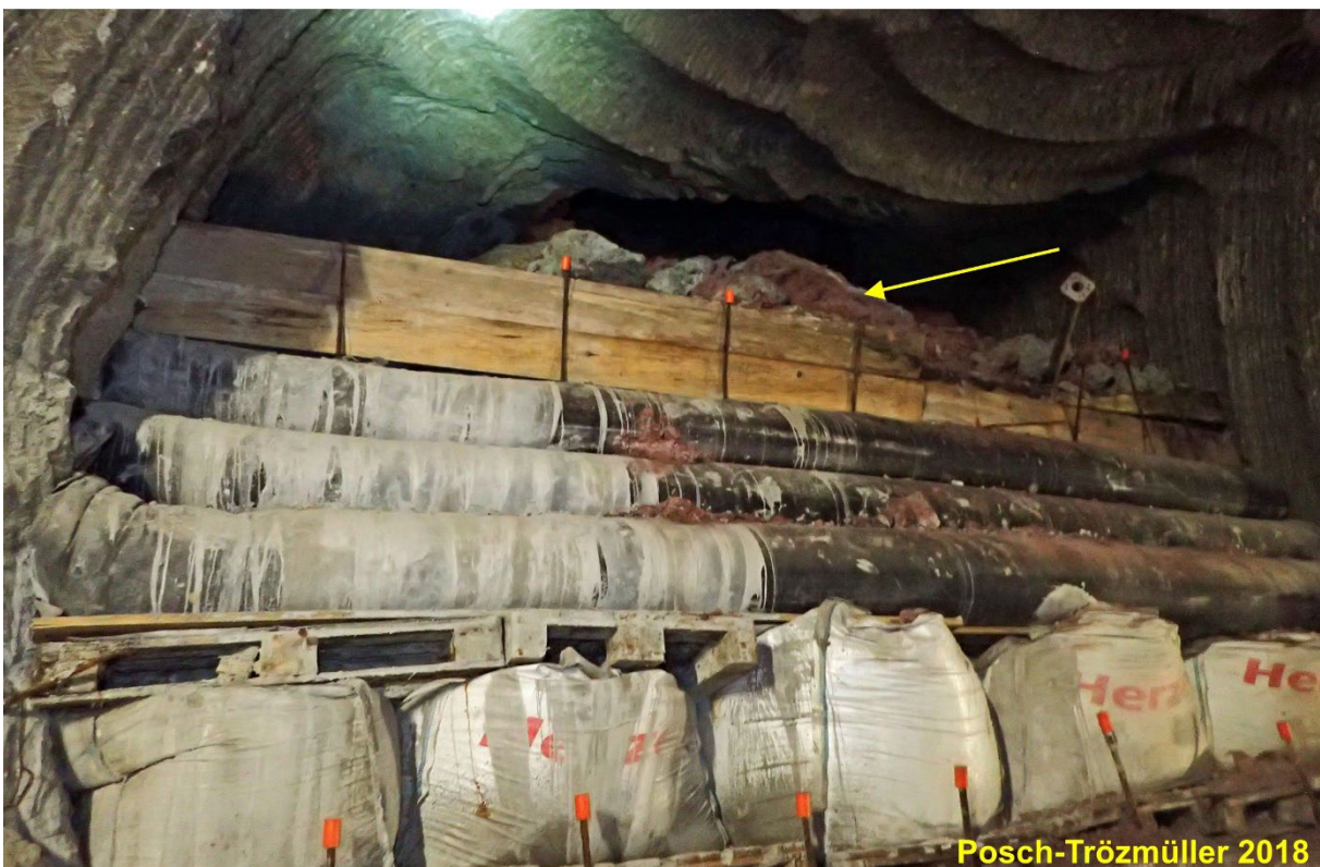
Abb. 2/183: Verbruch in Werfen-Fm. (gelber Pfeil) und Verfüllung eines Stollens auf Sohle 7: Die dicken Schläuche und Schwergewichtssäcke sind mit Realit gefüllt und dienen als „Dämme“ für die Verfüllung, welche über Schläuche dahinter flüssig eingebracht wird und in weiterer Folge abbindet.
