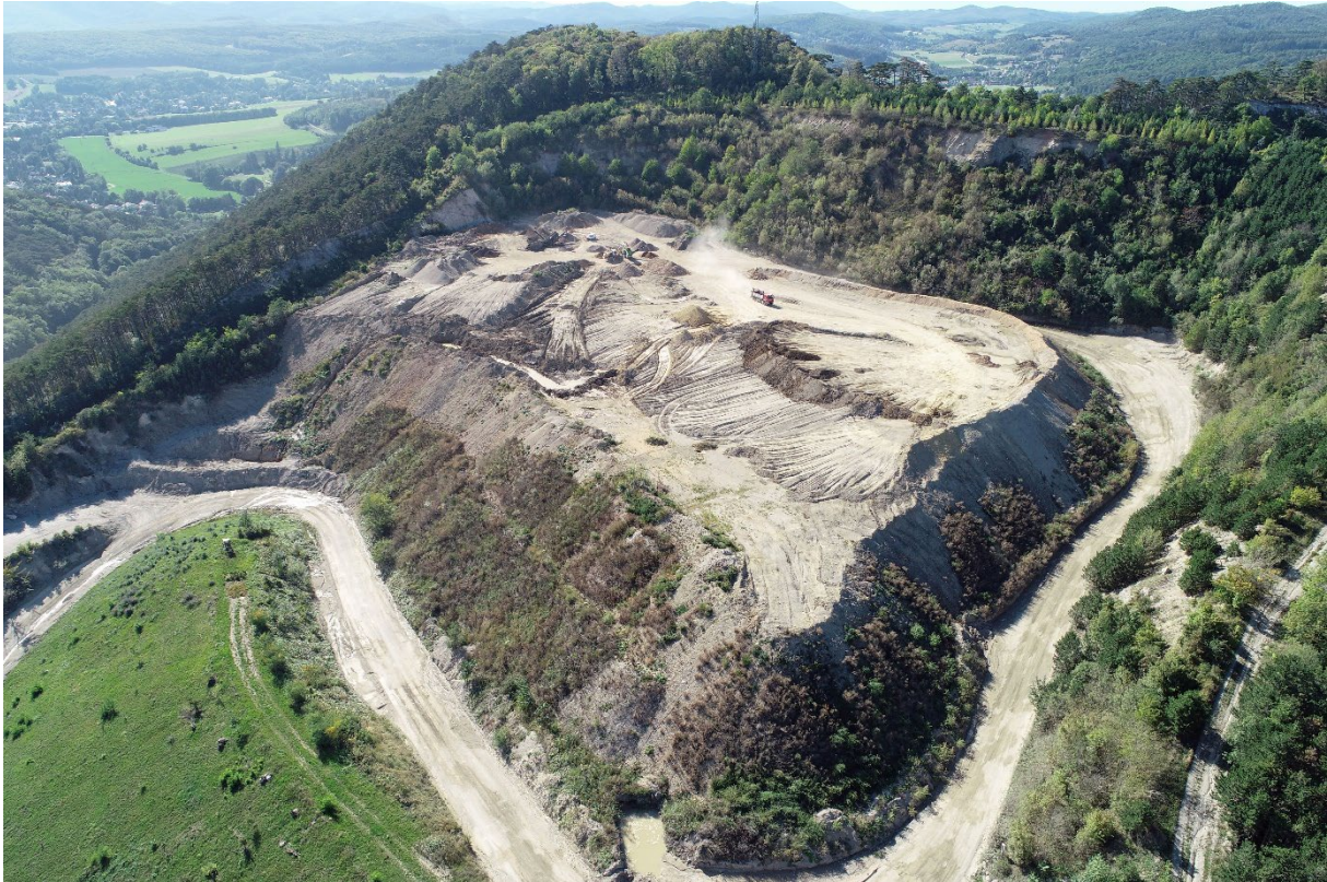
Abb. 2/49: Luftbildaufnahme der Bodenaushubdeponie im westlichen Teil des Steinbruchs (Drohnenaufnahme: Ch. Begusch, TPA, 2022).
