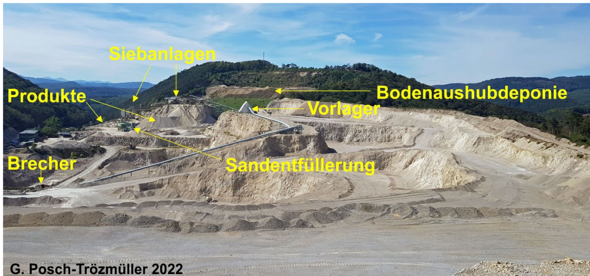
Abb. 2/35: Überblicksaufnahme vom aktuellen Abbaubereich Richtung W mit Beschriftung der wichtigsten Betriebsanlagen.
