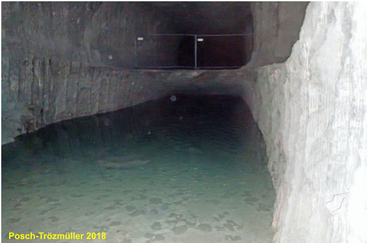
Abb. 2/190: Gefluteter Stollen – Blick Richtung Sohle 8.
