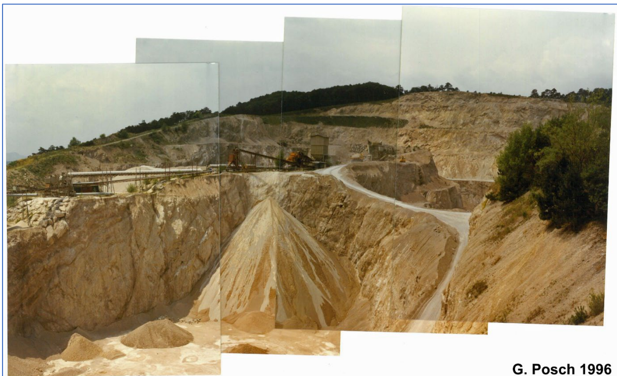
Abb. 2/32: Aufnahme des Dolomitsteinbruchs Gaaden vom 27.06.1996, Blickrichtung ca. West.
