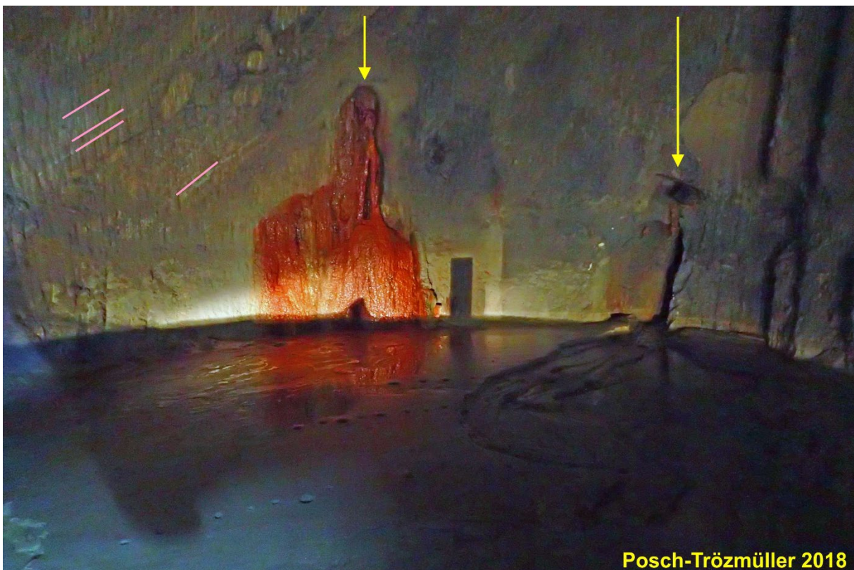
Abb. 2/192: Wasserbecken auf Sohle 5: Aus 2 Bohrlöchern (gelbe Pfeile), welche 1,5 m voneinander entfernt liegen, tritt Wasser unterschiedlicher chemischer Zusammensetzung aus, unter dem linken Bohrloch bildeten sich knallrote Ausfällungen, das rechte Bohrloch zeigte diese nicht annähernd in dem Ausmaß. Das rechte Bohrloch wurde erodiert, sodass ein kleiner „Canyon“ entstand.
