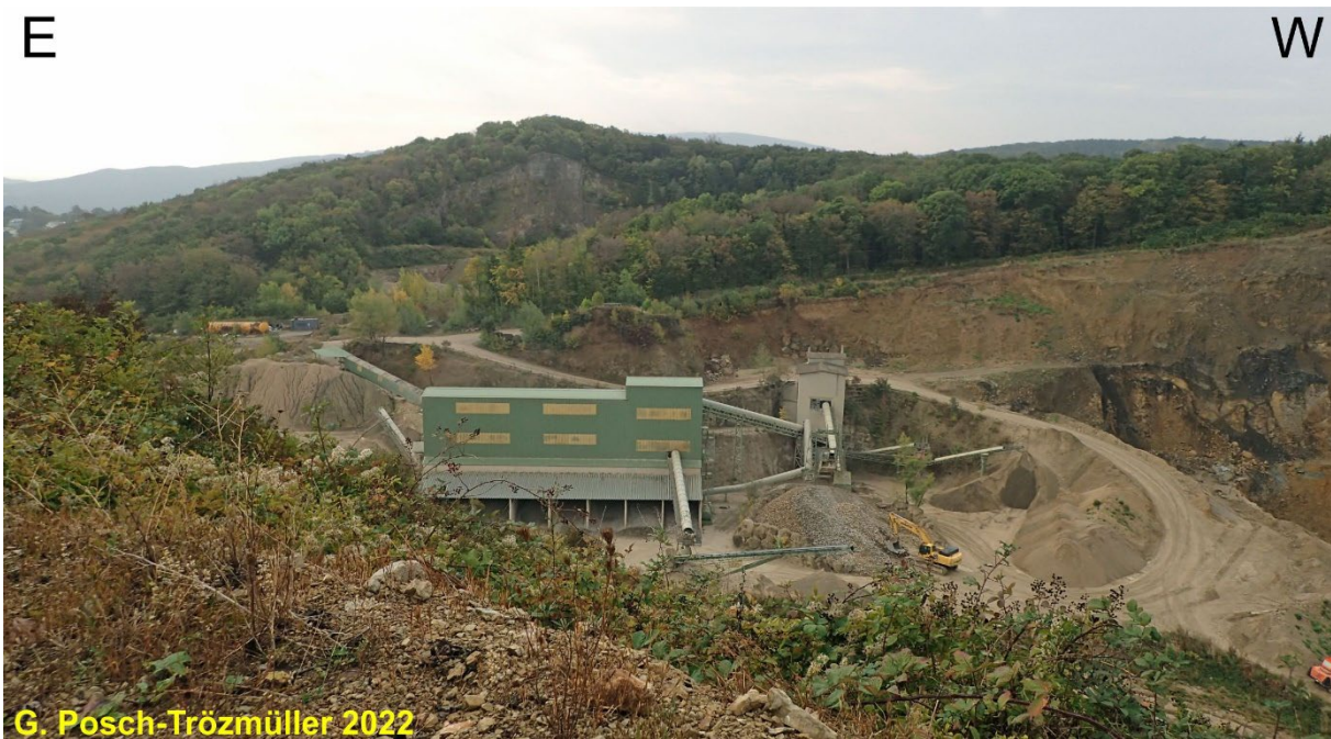
Abb. 2/57: Blick vom nördlichen Rand des Steinbruchs Richtung S. Im Vordergrund sind die Aufbereitungsanlagen zu sehen, die unterschiedlichen Körnungen sind automatisch je nach Bedarf zu bis zu 40 verschiedenen Korngemischen kombinierbar. Im Hintergrund ist eine Wand des Freunschlag-Bruchs (058/004A) zu sehen.
