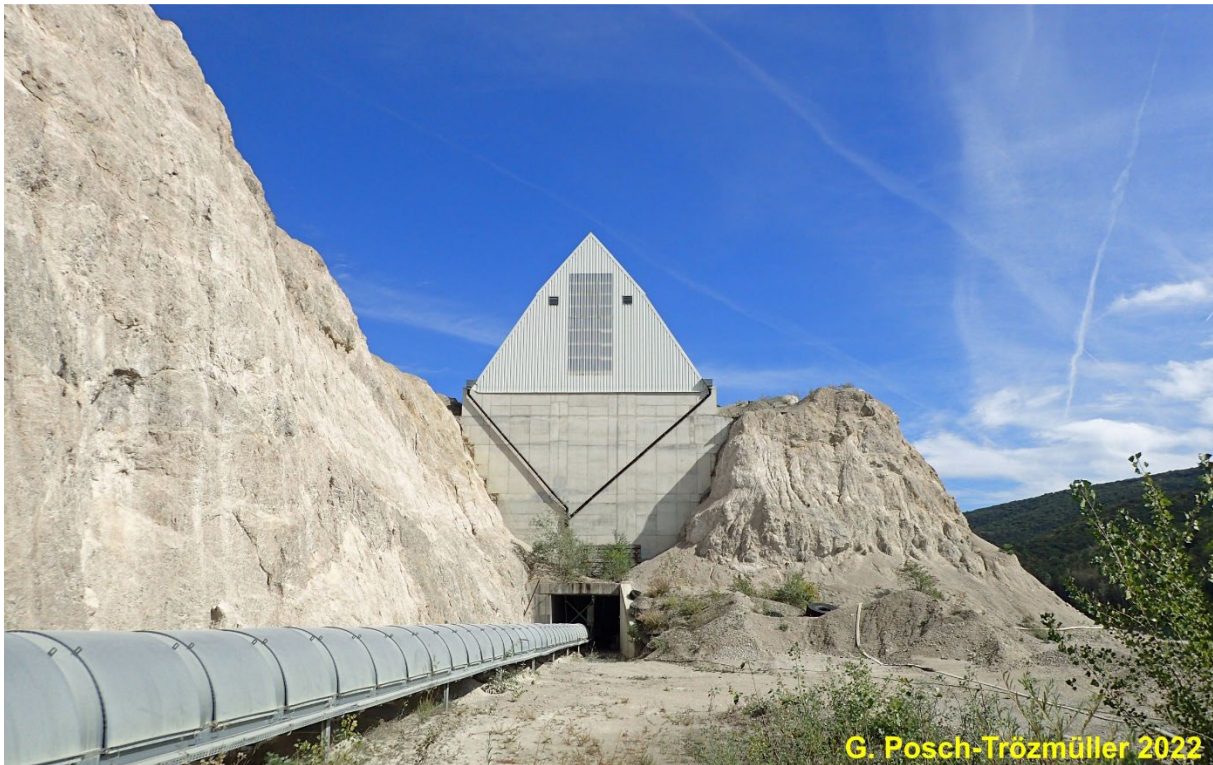
Abb. 2/41: Abtransport des Materials aus dem Zwischenlager (Gebäude).
