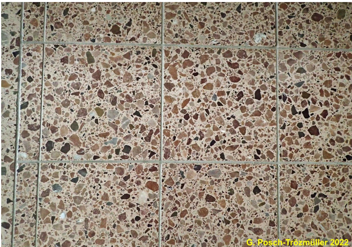
Abb. 2/62: Anwendungsbeispiel aus dem Steinbruch Kleiner Sattel: Bodenplatten im Betriebsgebäude, die aus gewaschenem 0/32-Korngemisch erzeugt wurden.
