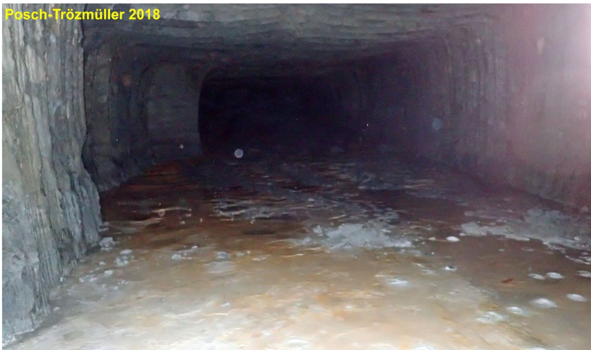
Abb. 2/194: „Sumpf“ auf Sohle 5: Auf der Wasseroberfläche sind Gipsbeläge ähnlich wie auf Salzseen zu sehen, teils weiß, teils stark rostrot gefärbt. Die Fläche war leider nicht betretbar, sofortiges Einsinken wäre die Folge.
