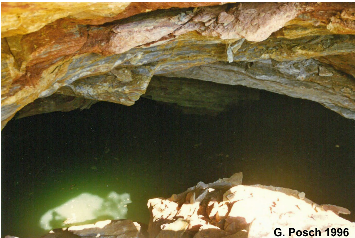
Abb. 2/221: Blick in den verbrochenen, wassergefüllten Stollen des ehemaligen Gipsbergbaues Füllenberg (058/034B).
