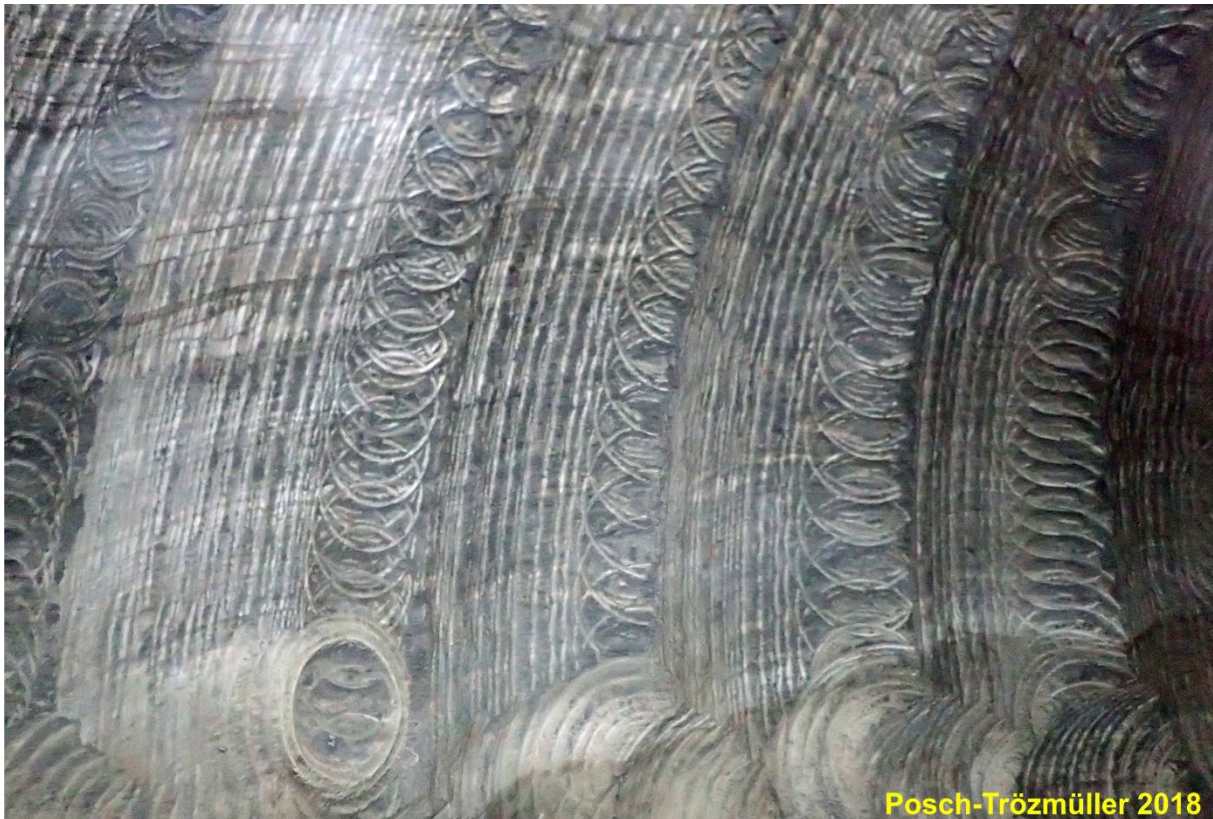
Abb. 2/191: Stollenwand auf Sohle 5, welche die Abbaumethode (Teilschnittmaschine) widerspiegelt.
