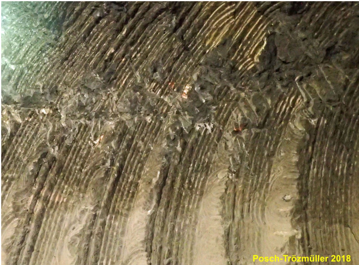
Abb. 2/186: Störung im Bereich der Firste auf Sohle 7.
