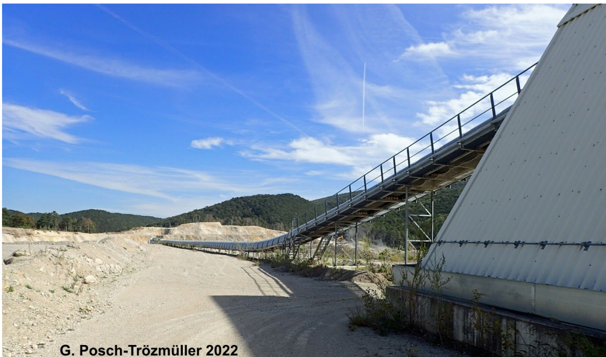
Abb. 2/40: Bandanlage, welche vom Brecher zum Zwischenlager (Gebäude rechts) führt.
