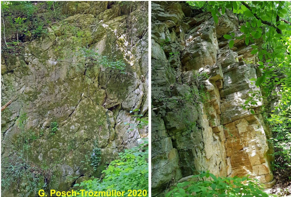
Abb. 2/80: Sehr glatte, wenn auch bewachsene Kluft-/Störungsfläche (links) und scharf begrenzte Kluftflächen (rechts) im ehemaligen Abbau 058/237 in Laab im Walde.
