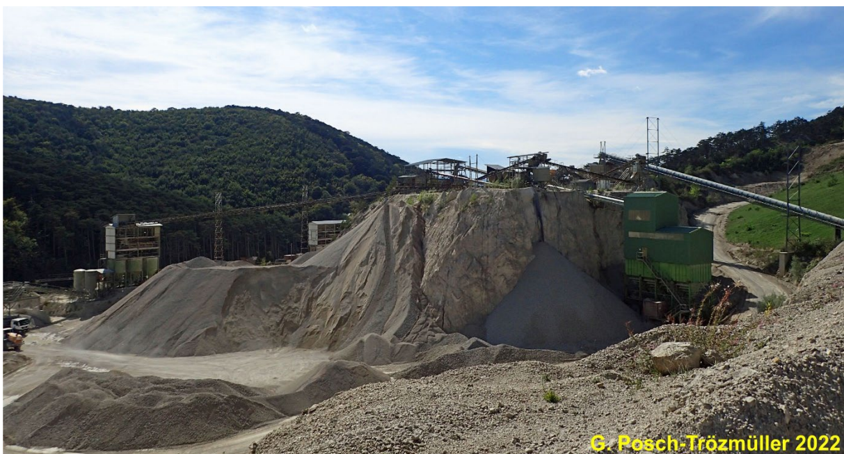
Abb. 2/42: Weitere Aufbereitung und Produkt-Haufen, Blick vom Zwischenlager etwa Richtung SW.
