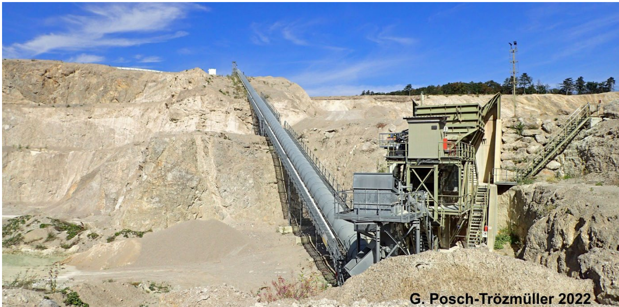
Abb. 2/39: Blick Richtung N auf den (Vor-)Brecher, welcher auf der tiefsten Sohle steht, von wo aus das Material per Bandanlage hinauf zum Zwischenlager transportiert wird.
