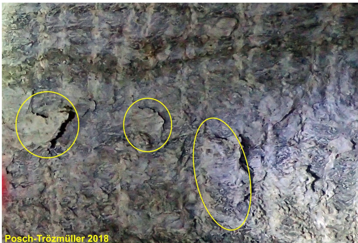
Abb. 2/196: Detail der Gips-Abplatzungen an der Lokalität P01/13 auf Sohle 7 des Gipsbergbaues Preinsfeld.
