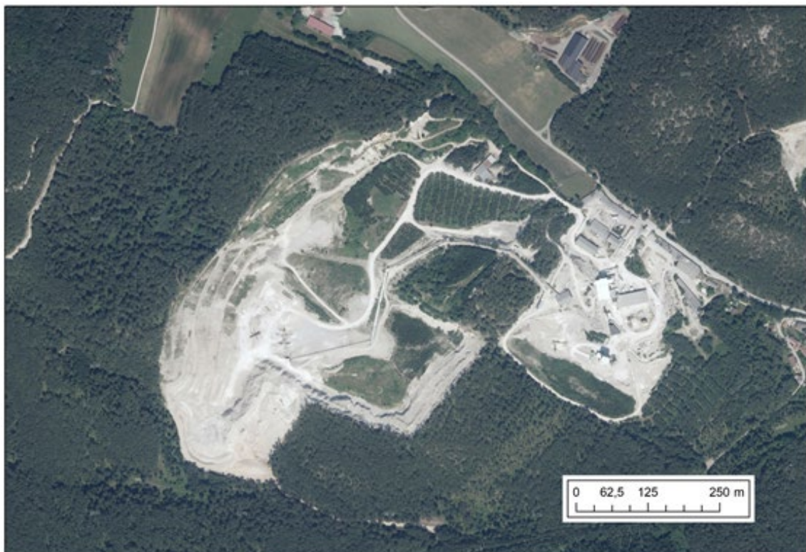
Abb. 2/102: Lage des Steinbruchs Berndorf-Steinhof (075/110) auf einem Orthofoto (Quelle: www.basemap.at ).
