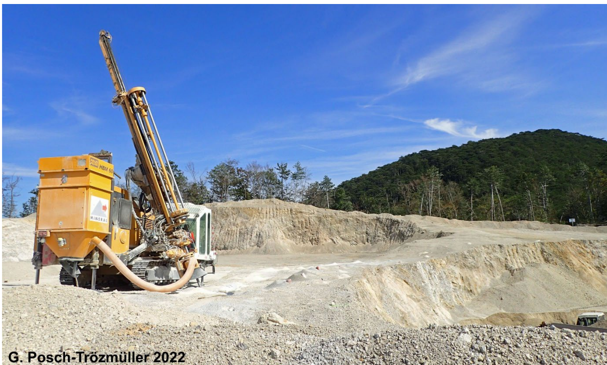
Abb. 2/38: Aktueller Abbaubereich - Bohren als Vorbereitung für die nächste Sprengung.
