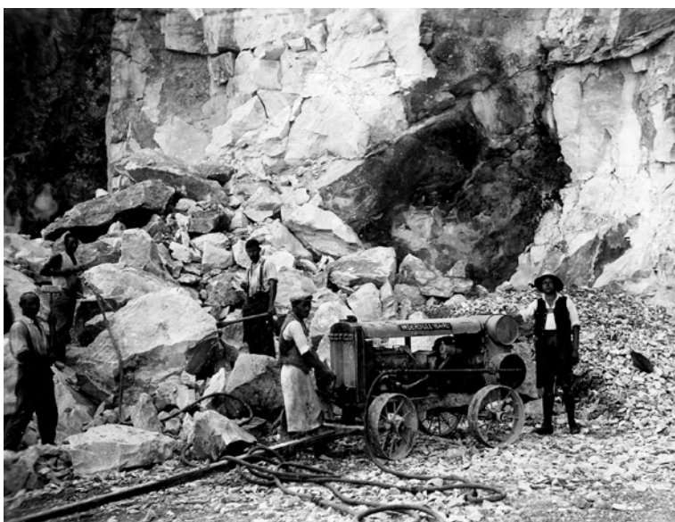
Abb. 4.-34: Historische Aufnahme Mannersdorf Vetter (im Areal des heutigen Zementbruchgeländes); Quelle: Lagerstättenarchiv/Steinbruchkartei Geologische Bundesanstalt.
