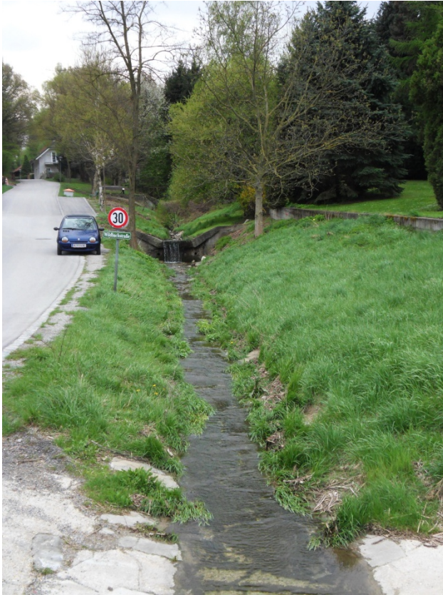
Abb. 8.-8: Gerinne Wildungsmauer knapp vor Mündung in die Donau; der Straßennamen „Wildbachstraße“ verweist auf stark wechselnde Abflussmengen, Foto: H. Pirkl, 2011.
