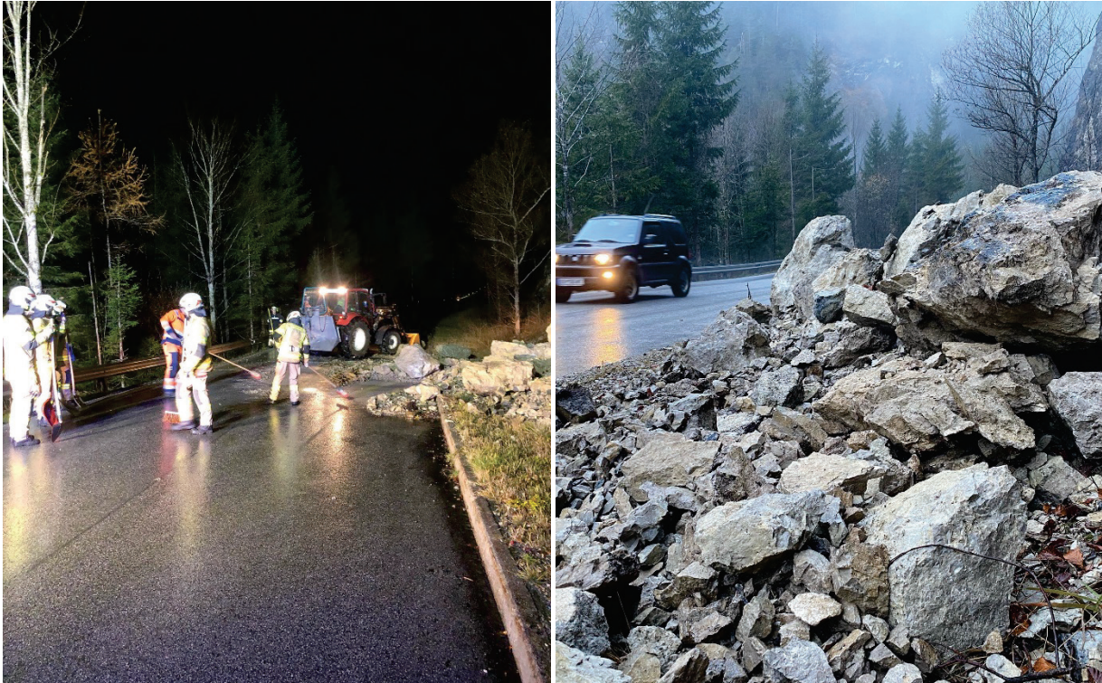
Abb. 14: Sturzmaterial vom Abend des 25. November 2022 auf und am Rand der Aschauerstraße unweit des Straßenkilometers 6,8 im Raum Burgstall im Gemeindegebiet von Brandenberg (Bundesland Tirol) (© Fotos: Freiwillige Feuerwehr Aschau/Brandenberg; Quelle: Facebook-Seite der Freiwilligen Feuerwehr Aschau/Brandenberg) [12].
