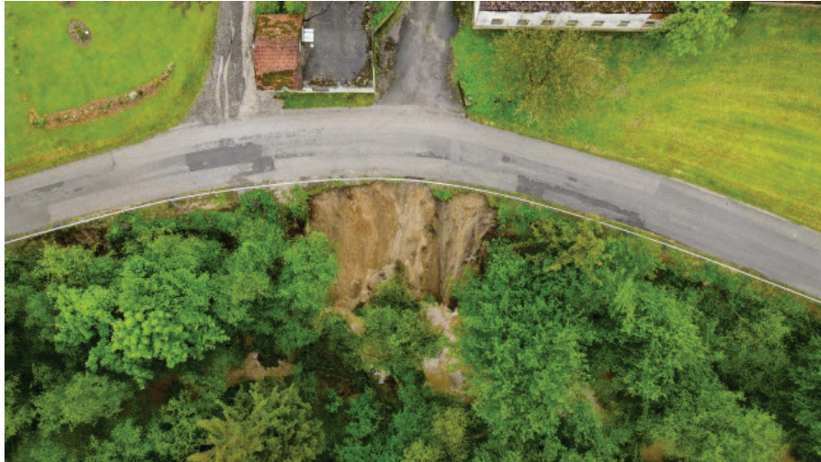
Abb. 15: Hangrutschung am 13. Mai 2022 an der Gilgenberger Straße (L 1001) auf Höhe des Straßenkilometers 2,66 im Gemeindegebiet von Schwand (Bundesland Oberösterreich) (© Foto: Daniel Scharinger/Pressefoto Daniel Scharinger; Quellen: Facebook-Seite von „Pressefoto Daniel Scharinger“ [12] und Webseite von „laumat.at media“ [13]).
