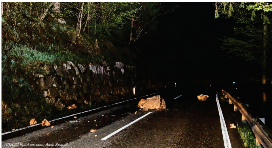
Abb. 9: Sturzblöcke vom 8. Mai 2022 auf der Zellerrain Straße (B 71) bei Straßenkilometer 6,8 westlich von Maierhöfen im Gemeindegebiet von Gaming (Bundesland Niederösterreich) (© Foto: Alois Spandl/FotoLois.com) [1].
