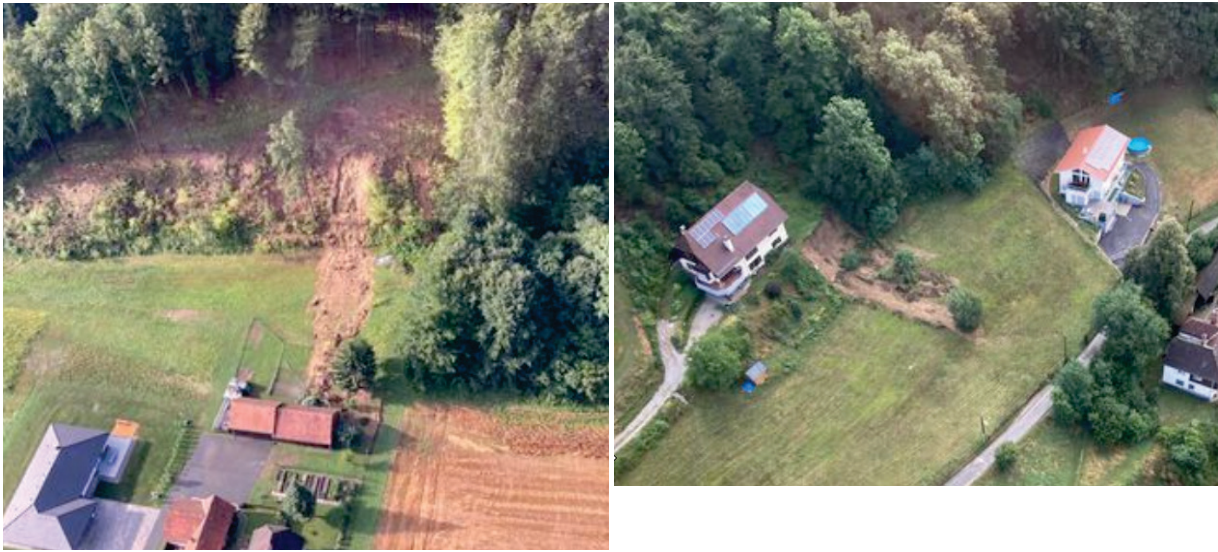
Abb. 51: Hangrutschungen vom 30. Juli 2021 in der Gemeinde Laßnitzhöhe östlich der Landeshauptstadt Graz (Bundesland Steiermark) (linkes Bild) und im Bezirk Mariatrost der Stadtgemeinde Graz (rechtes Bild) (© Fotos: Flugeinsatzstelle (FEST) Graz/Bundesministerium für Inneres, Abteilung II/7 – Flugpolizei; Quelle: „Kleine Zeitung“-online) [84].
