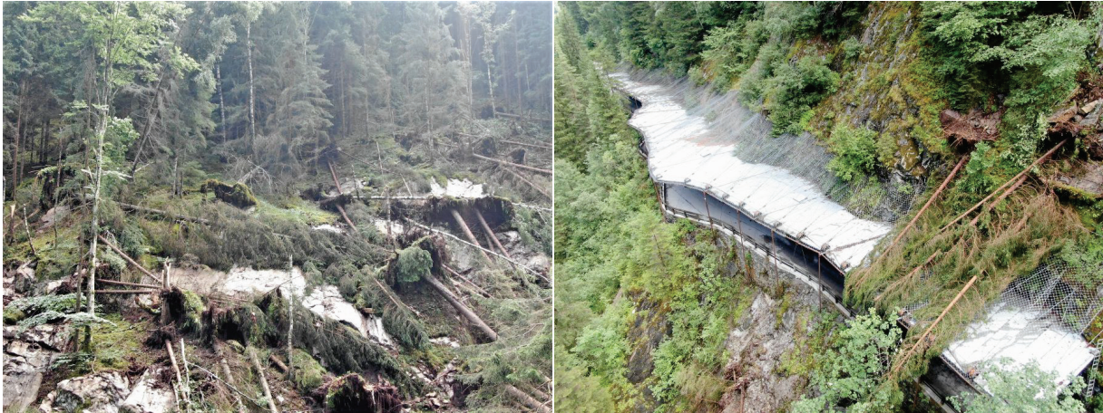
Abb. 53: Entwurzelte Bäume am Hang oberhalb (linkes Bild) und auf (rechtes Bild) der Galerie an der Oppenbergerstraße (L 739) bei Straßenkilometer 2,5 zwischen Rottenmann und Oppenberg im Gemeindegebiet von Rottenmann (Bundesland Steiermark) nach dem schweren Unwetter am Abend des 31. Juli 2021 (© Fotos: Holler/Fachabteilung Straßenerhaltungsdienst (STED) des Landes Steiermark; Quelle: Webseite des Landes Steiermark) [91].
