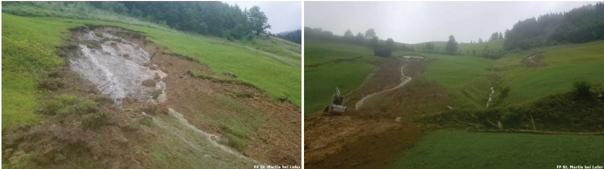
Abb. 40: Abrissbereich einer Hangmure (linkes Bild) und weitere Hangmuren (rechtes Bild) vom 18. Juli 2021 im Ortsteil Hirschbichl in der Gemeinde Sankt Martin bei Lofer (Bundesland Salzburg) (© Fotos: Freiwillige Feuerwehr Sankt Martin bei Lofer; Quelle: Webseite der Freiwilligen Feuerwehr Sankt Martin bei Lofer) [68].
