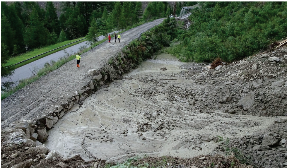
Abb. 32: Das infolge mehrerer Murenabgänge am 19. und 20. Juli 2021 größtenteils gefüllte Auffangbecken an der Ötztalstraße (B 186) zwischen der Klammgalerie und der Leckgalerie im Gemeindegebiet von Sölden (Bundesland Tirol) (© Foto: Land Tirol; Quelle: Webseite des Landes Tirol) [48].
