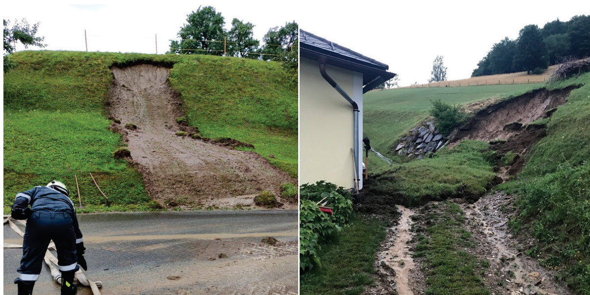
Abb. 47: Hangmure vom 18. Juli 2021 im Raum Nussendorf in der Gemeinde Artstetten-Pöbring (Bundesland Niederösterreich) (linkes Bild; © Foto: Freiwillige Feuerwehr Nussendorf; Quelle: Webseite des Bezirksfeuerwehrkommandos Melk [80]) und Hangrutschung vom 18. Juli 2021 bei einem Haus in der Gemeinde Textingtal (Bundesland Niederösterreich) (rechtes Bild; © Foto: Freiwillige Feuerwehr Sankt Gotthard; Quelle: Webseite des Bezirksfeuerwehrkommandos Melk [80]).
