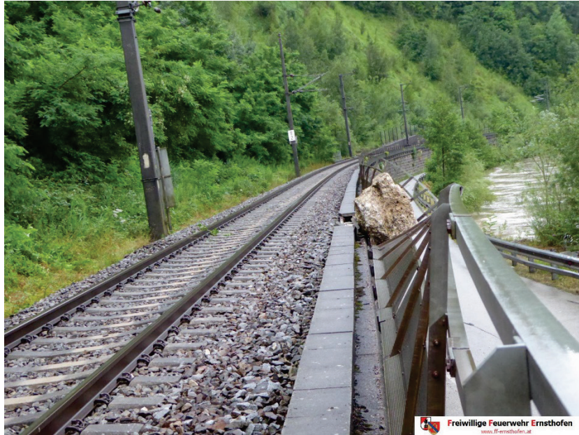
Abb. 43: Sturzblock vom 18. Juli 2021 unmittelbar neben dem Gleisbett der Rudolfsbahnstrecke bei Eisenbahnkilometer 9,15 auf der Loderleite im Gemeindegebiet von Ernsthofen (Bundesland Niederösterreich) (© Foto: Freiwillige Feuerwehr Erntshofen; Quelle: Webseite der Freiwilligen Feuerwehr Erntshofen) [73].
