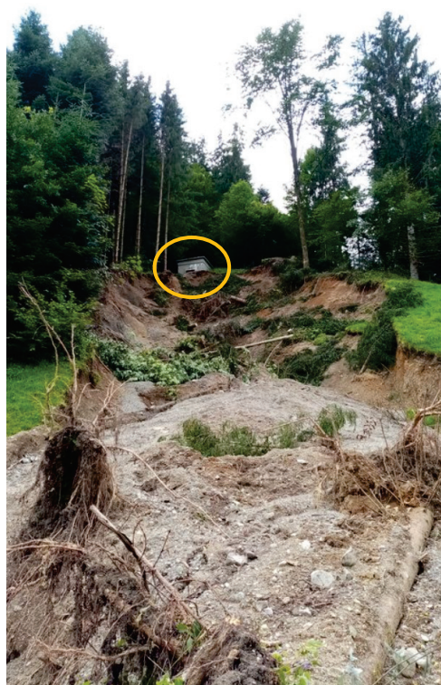
Abb. 16: Oberer Bereich des Hangrutschungsareals im Ortsteil Pinnerdorf in der Stadtgemeinde Wörgl (Bundesland Tirol) vom 22. Juli 2021 mit Blick auf den Hochbehälter Pinnerdorf (gelber Kreis) (© Foto: Veronika Spielbichler/„Vero online“; Quelle: Webseite von „Vero online“ – Internetportal für Regionalnachrichten aus der Region Wörgl) [20].
