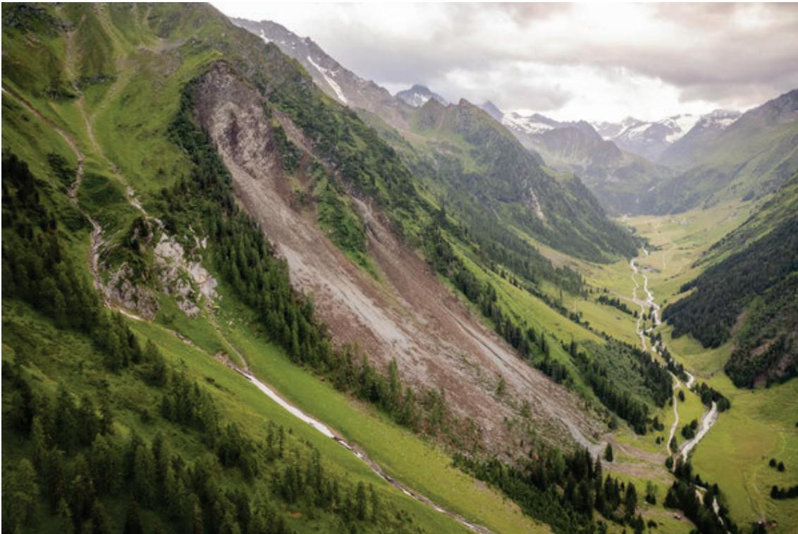
Abb. 23: Areal der großflächigen Hangbewegung mit Hangrutschungs-, Muren-, Blocksturz- und Steinschlagaktivität am und nach dem 18. Juli 2021 auf der orografisch rechten Talseite des Oberbergtales unterhalb der Malgrube (Stubai Alpen) im Gemeindegebiet von Neustift im Stubaital (Bundesland Tirol) mit Blick talwärts (© Foto: Lukas Pfurtscheller/Pfurtscheller Fotografie; Quelle: Webseite der Freiwilligen Feuerwehr Neustift im Stubaital) [28].
