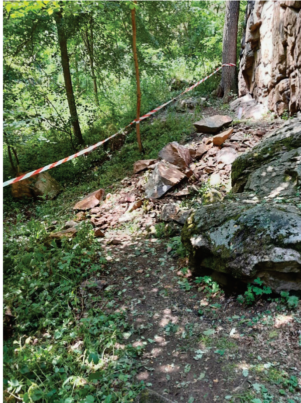
Abb. 30: Sturzblöcke des Felssturzes vom 21. Juni 2021 im Taffatal in der Gemeinde Horn (Bundesland Niederösterreich) (© Foto: Siegfried Gruber/Österreichischer Alpenverein, Sektion Horn; Quelle: Webseite des Österreichischen Alpenvereins, Sektion Horn) [40], [41].
