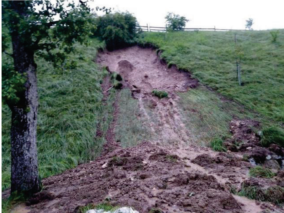
Abb. 16: Hangmure vom 5. Juni 2021 an der talseitigen Böschung der Steinfeldstraße im Gemeindegebiet von Pettenbach (Bundesland Oberösterreich) (© Freiwillige Feuerwehr Steinfeld; Quelle: Webseite der Freiwilligen Feuerwehr Steinfeld) [22].
