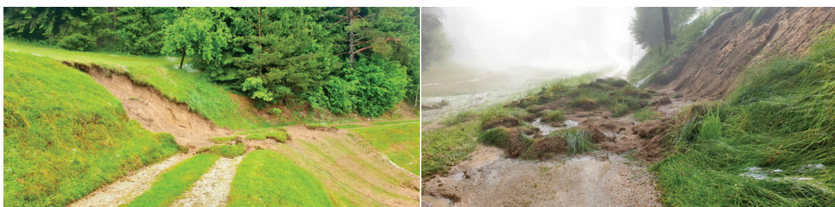
Abb. 29: Zwei Böschungsrutschungen vom 11. Juni 2021 im Gemeindegebiet von Pierbach (Bundesland Oberösterreich) (© Fotos: Freiwillige Feuerwehr Pierbach; Quelle: „Bezirksrundschau“-online) [39].
