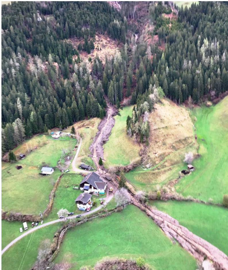
Abb. 10: Der Mühlabach am Penzelberg und das betroffene landwirtschaftliche Anwesen in der Gemeinde Winklern (Bundesland Kärnten) am 2. Mai 2021 nach dem Abgang einer Hangrutschung am Penzelberger Güterweg und dem anschließenden Murstoß (© Foto: Stützpunkt-Feuerwehr Winklern; Quelle: Facebook-Seite der Stützpunkt-Feuerwehr Winklern) [5].
