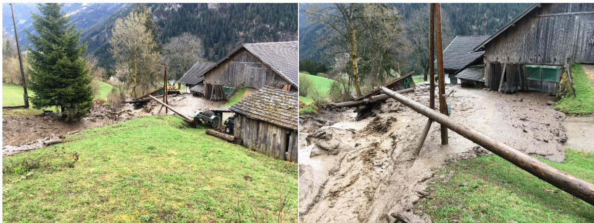
Abb. 8: Die Vermurung des Mühlbaches am Penzelberg und das schwer beschädigte Wirtschaftsgebäude in der Gemeinde Winklern (Bundesland Kärnten) am 2. Mai 2021 infolge einer Hangrutschung am oberhalb von diesem gelegenen Penzelberger Güterweg (© Fotos: Stützpunkt-Feuerwehr Winklern; Quelle: Facebook-Seite der Stützpunkt-Feuerwehr Winklern) [5].
