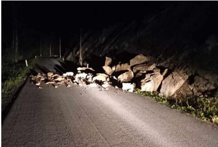
Abb. 37: Sturzblöcke auf der L 6169 bei Straßenkilometer 9,7 im Zogelsgraben im Gemeindegebiet von Ybbsitz (Bundesland Niederösterreich) in der Nacht auf den 23. Mai 2021 (© Foto: Polizeiinspektion Waidhofen an der Ybbs bzw. Landespolizeidirektion Niederösterreich; Quelle: „Niederösterreichische Nachrichten“-online) [24].
