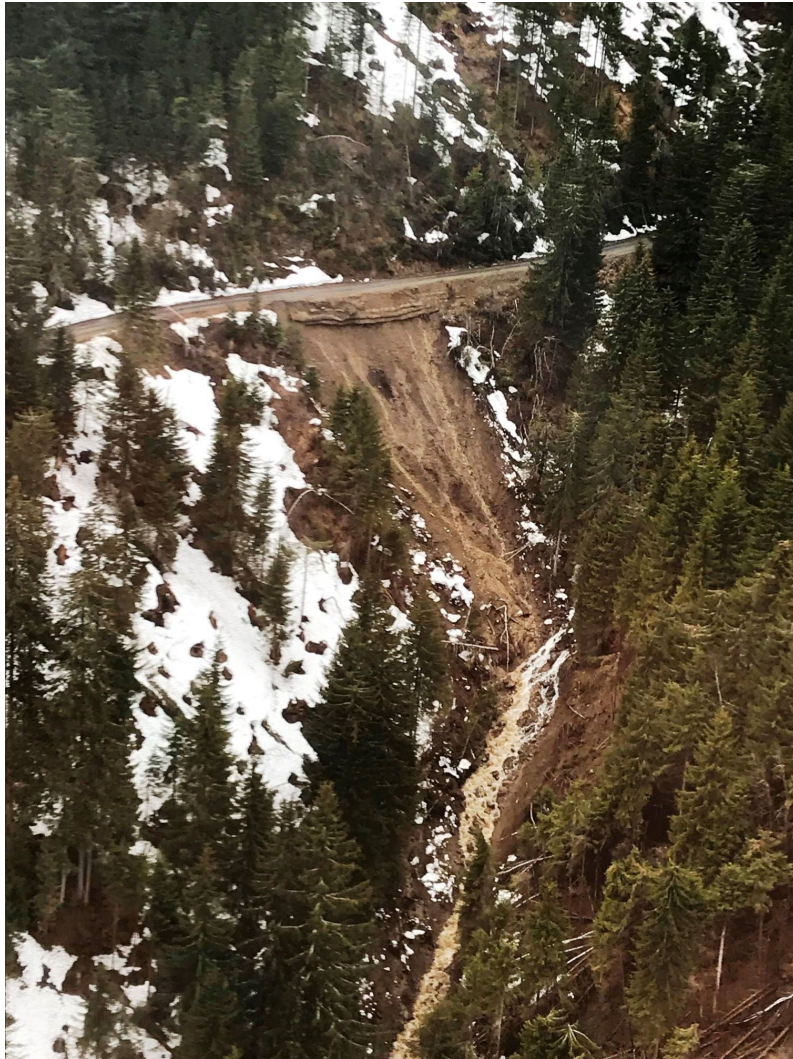
Abb. 11: Orografisch rechter Einhang des Mühlbaches am Penzelberg unterhalb des Penzelberger Güterweges in der Gemeinde Winklern (Bundesland Kärnten) am 2. Mai 2021 mit dem Areal der Hangrutschung (© Foto: Stützpunkt-Feuerwehr Winklern; Quelle: Facebook-Seite der Stützpunkt-Feuerwehr Winklern) [5].
