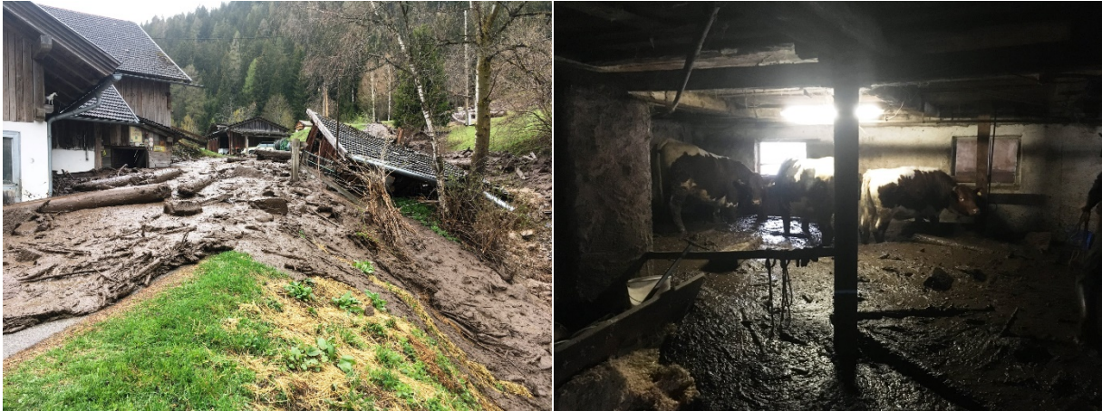
Abb. 9: Schwer beschädigtes Wirtschaftsgebäude (linkes Bild) und noch im Stall in den Schlammmassen stehende Kühe (rechtes Bild) in der Gemeinde Winklern (Bundesland Kärnten) am 2. Mai 2021 infolge einer Hangrutschung am Penzelberger Güterweg (© Fotos: Stützpunkt-Feuerwehr Winklern; Quelle: Facebook-Seite der Stützpunkt-Feuerwehr Winklern) [5].
