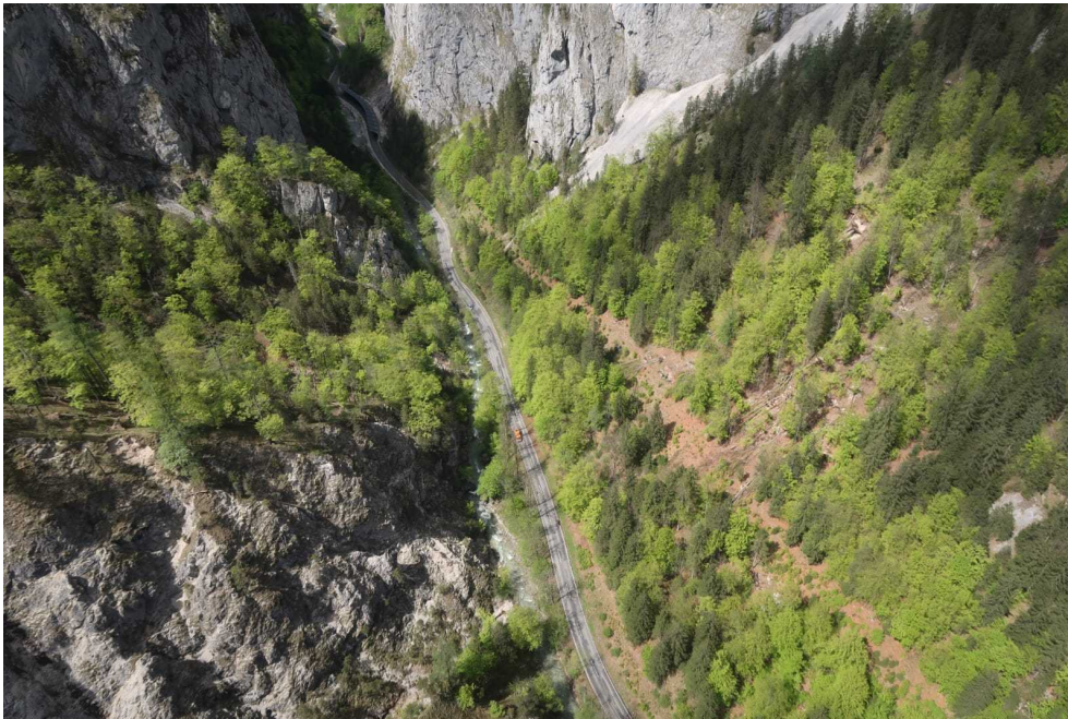
Abb. 33: Das Tal des Radmer Baches im Gemeindegebiet von Radmer (Bundesland Steiermark) mit der Radmerstraße (L 127) und dem Steinschlagareal vom 16. Mai 2021 an dieser bei Straßenkilometer 3,650 (© Foto: Gemeinde Radmer; Quelle: „Kleine Zeitung“-online) [21].
