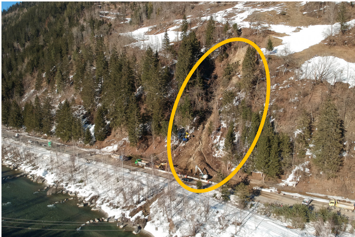
Abb. 16: Hangrutschungsareal (gelbe Umrahmung) vom 1. März 2021 an der Felbertauernstraße (B 108) zwischen den Orten Ainet und Sankt Johann im Walde etwa auf Höhe des Straßenkilometers 9,75 im Gemeindegebiet von Ainet (Bundesland Tirol) (© Foto: Roman Wagner/„dolomitenstadt.at“; Quelle: „dolomitenstadt.at“-online) [15].
