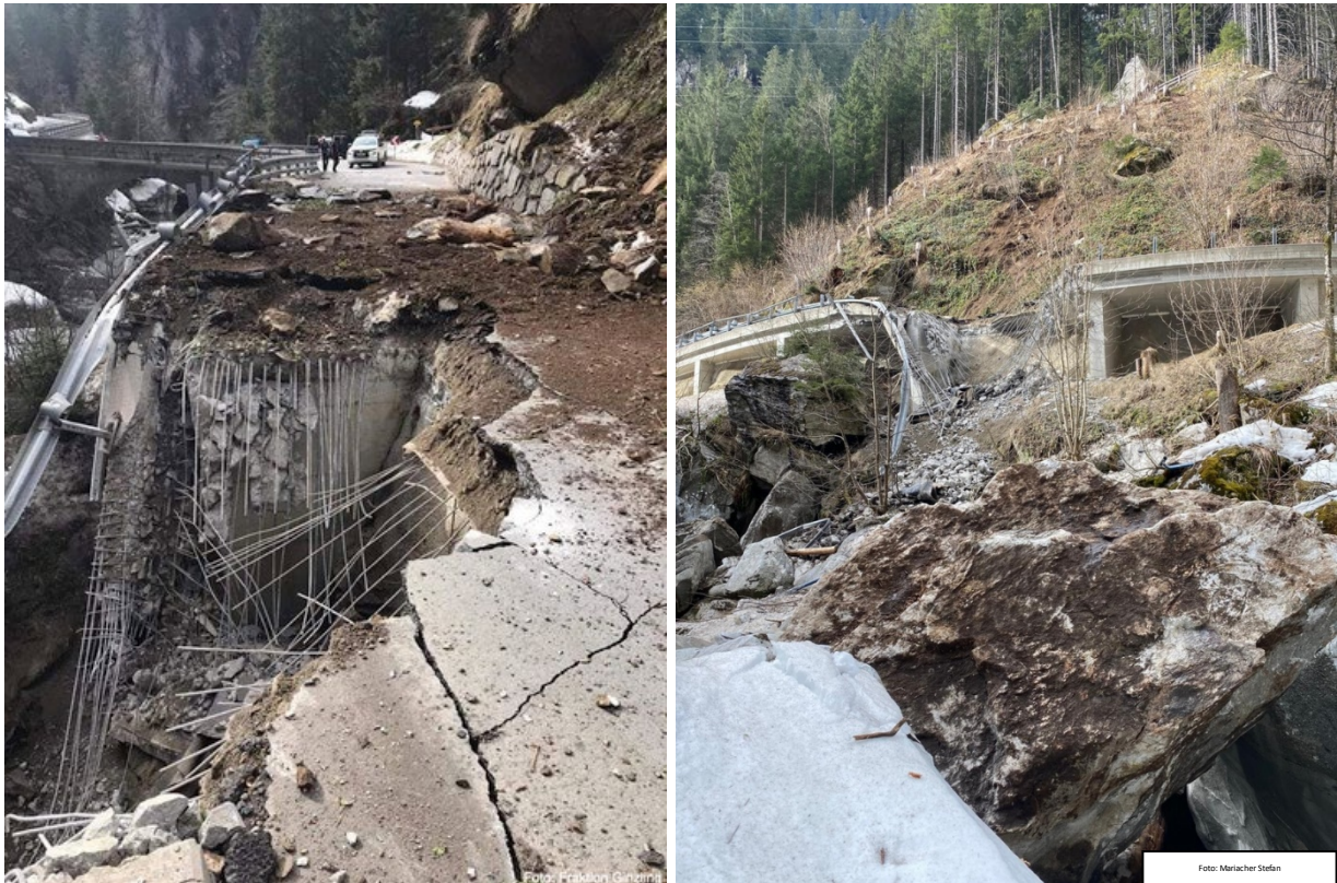
Abb. 9: Die Zillertalstraße (B 169) nach dem Felssturz vom 3. März 2021 auf Höhe des Straßenkilometers 34,96 im Gemeindegebiet von Finkenberg (Bundesland Tirol) mit Blick Richtung Karlstegbrücke (links) und auf einen Teil der Sturzbahn (rechts) (© Fotos: Fraktion Ginzling-Dornauerg (links) und Stefan Mariacher/Freiwillige Feuerwehr Ginzling-Dornauerg; Quelle: Webseite der Freiwilligen Feuerwehr Ginzling-Dornauerg) [7].
