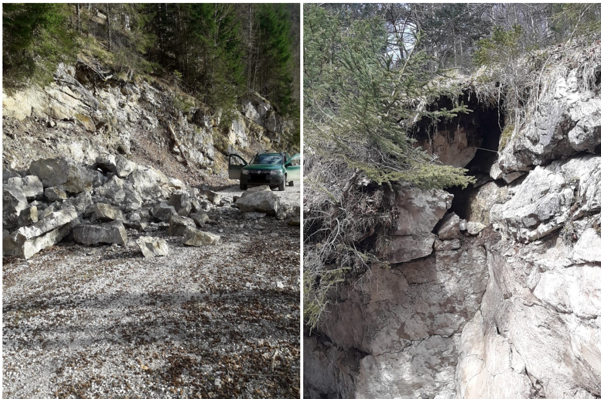
Abb. 32: Felssturzareal vom März 2021 (links) an und Ablösebereich des Felssturzes (rechts) oberhalb der Schaumbergstraße im Gemeindegebiet von Rosenau am Hengstpass (Bundesland Oberösterreich) (© Fotos: Bundesforste/Nationalparkbetrieb Kalkalpen; Quelle: Webseite des Nationalparks Kalkalpen) [32].
