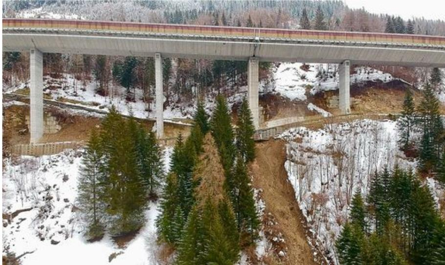
Abb. 29: Hangmure vom 9. Februar 2021 auf der Höhe eines Stützpfeilers der Hangbrücke Pressingberg der Tauernautobahn (A 10) ungefähr bei Straßenkilometer 121,6 südlich von Kramsbrücke im Gemeindegebiet von Krams in Kärnten (Bundesland Kärnten) (© Foto: Willi Pleschberger/Foto Pleschberger; Quelle: „Kleine Zeitung“-online) [40], [45].
