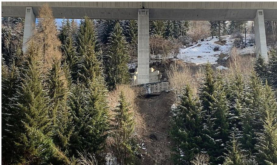
Abb. 30: Stützpfeiler der Hangbrücke Pressingberg der Tauernautobahn (A 10) ungefähr bei Straßenkilometer 121,6 südlich von Kramsbrücke im Gemeindegebiet von Krams in Kärnten (Bundesland Kärnten) nach dem Abgang einer Hangmure am 9. Februar 2021 (© Foto: ASFINAG; Quelle: „Kleine Zeitung“-online) [45].
