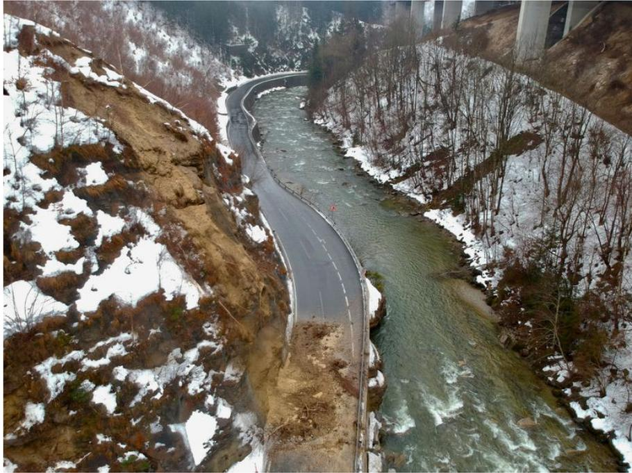
Abb. 34: Hang an der Katschberg Straße (B 99) zirka bei Straßenkilometer 82,2 zwischen Trebesing und der Altersbergbrücke im Gemeindegebiet von Seeboden (Bundesland Kärnten) mit am 9. Februar 2021 abgerutschten Lockergesteinsmassen (© Foto: Willi Pleschberger/Foto Pleschberger; Quelle: „Kleine Zeitung“-online) [45], [52].
