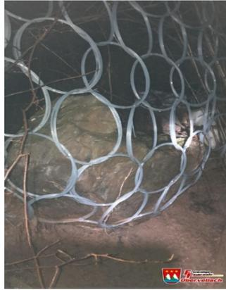
Abb. 45: Sturzblock vom 7. Februar 2021 im Steinschlagschutznetz oberhalb von Semslach in der Gemeinde Obervellach (Bundesland Kärnten) (© Fotos: Freiwillige Feuerwehr Obervellach; Quelle: Webseite der Freiwilligen Feuerwehr Obervellach) [68].
