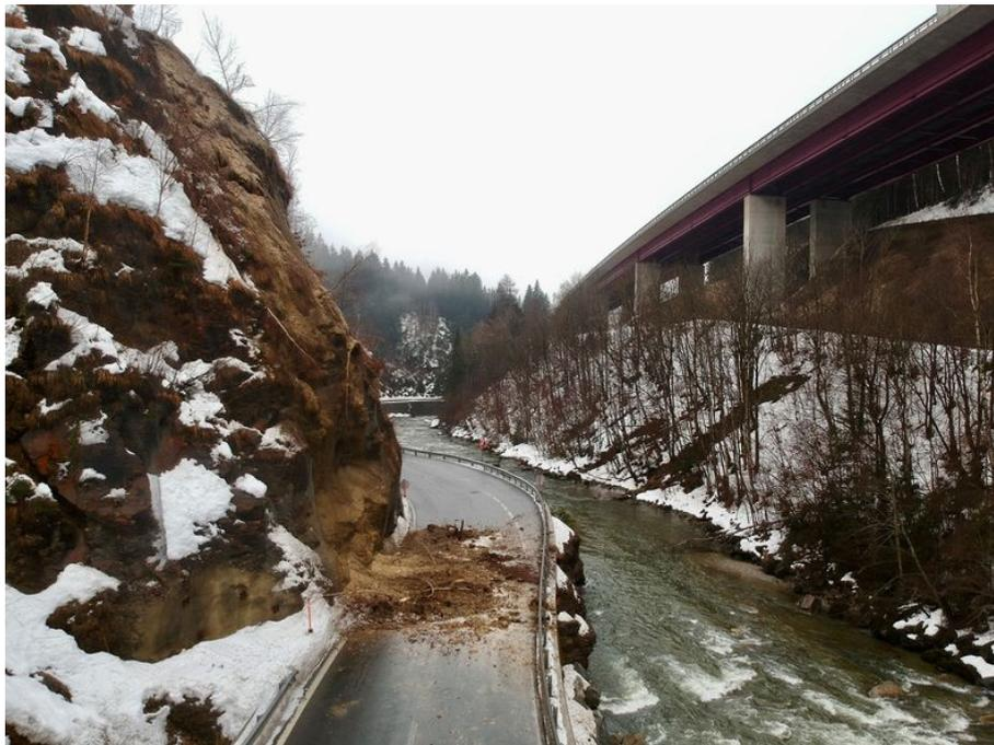
*Abb. 33: Hang an der Katschberg Straße (B 99) zirka bei Straßenkilometer 82,2 zwischen Trebesing und der Altersbergbrücke im Gemeindegebiet von Seeboden (Bundesland Kärnten) mit am 9. Februar 2021 abgerutschten Lockergesteinsmassen (© Foto: Willi Pleschberger/Foto Pleschberger; Quelle: „Kleine Zeitung“-online) [45], [52].*
