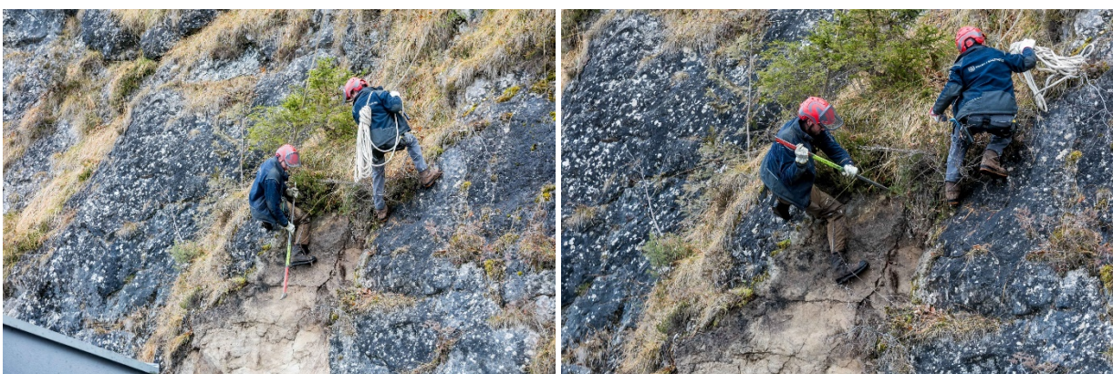
Abb. 9: Bergputzer der Stadt Salzburg bei Sicherungsmaßnahmen im Abbruchbereich des Felssturzes an der Nordflanke des Kapuzinerberges in der Landeshauptstadt Salzburg vom 23. Jänner 2021, unmittelbar angrenzend an das Haus der Stadtgeschichte in der Glockengasse Nr. 8 (© Fotos: Wild + Team Fotoagentur und Stadt Salzburg; Quelle: Webseite der Stadt Salzburg) [1].
