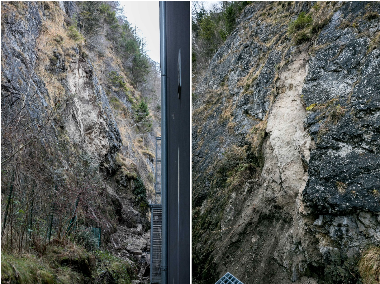
Abb. 8: Felssturzareal an der Nordflanke des Kapuzinerberges in der Landeshauptstadt Salzburg (Bundesland Salzburg) vom 23. Jänner 2021, unmittelbar angrenzend an das Haus der Stadtgeschichte in der Glockengasse Nr. 8 (© Fotos: Wild + Team Fotoagentur und Stadt Salzburg; Quelle: Webseite der Stadt Salzburg) [1].
