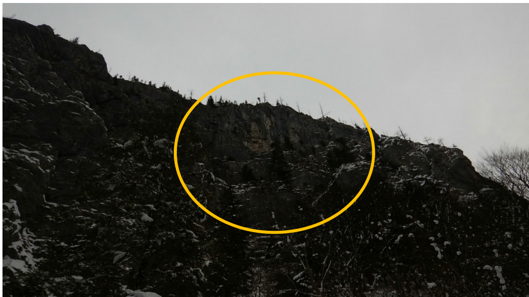
Abb. 23: Felswand an der Radmerstraße (L 127) im Gemeindegebiet von Radmer (Bundesland Steiermark), aus der sich am 20. Jänner 2021 Felsblöcke lösten (gelber Kreis) und auf die Radmerstraße stürzten (© Foto: Marc André Rapp/A 16 – Verkehr und Landeshochbau, Fachabteilung Straßenerhaltungsdienst (STED), Land Steiermark; Quelle: „Kleine Zeitung“-online) [26].
