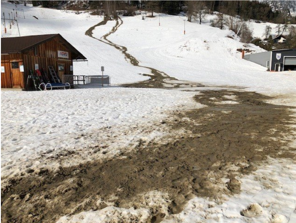
Abb. 28: Schlammströme über die Skipiste am westlichen Ortsrand von Weißenbach bei Liezen in der Stadtgemeinde Liezen (Bundesland Steiermark) infolge einer Hangrutschung am oder vor dem 29. Jänner 2021 oberhalb des Skiliftes (© Foto: Sportgemeinschaft Weißenbach bei Liezen; Quelle: Webseite der Sportgemeinschaft Weißenbach bei Liezen) [40].
