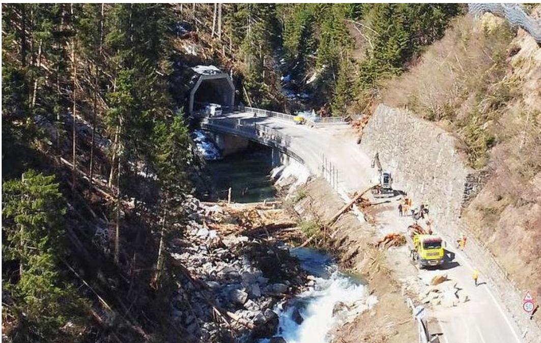
*Abb. 10: Die Schwarzach mit der Sturzhalde des Felssturzes vom 14. April 2020 auf der orografisch rechten Talseite und der dadurch verursachten Seitenerosion an der Böschung der Trasse der Defereggentalstraße (L 25) im Gemeindegebiet von Sankt Veit in Deferegggen (© Foto: Markus Mayr/ORF; Quelle: ORF-online) [3], [4].*
