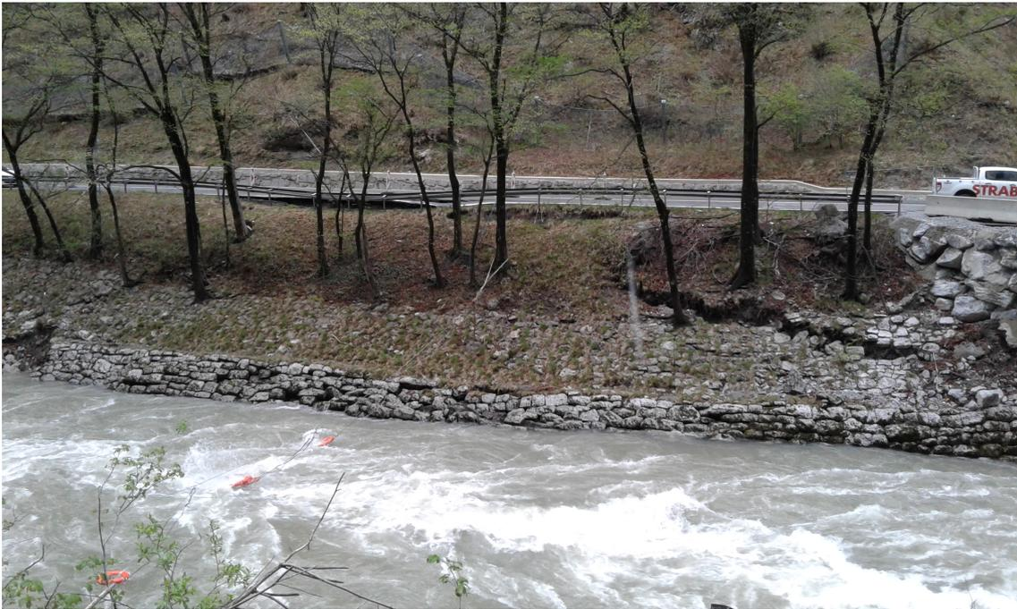
Abb. 21: Rutschung der Böschung der Salzach einschließlich der flusseitigen Fahrbahn der Salzachtal Straße (B 159) bei km 25,4 beim Pass Lueg am 15. April 2020 (© Foto: Kurt Holztrattner/Land Salzburg; Quelle: Webseite des Landes Salzburg) [20].
