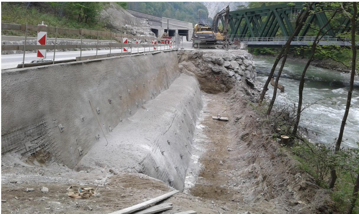
Abb. 24: Abgerutschte Böschung und Fahrbahn der Salzachtal Straße (B 159) bei km 25,4 während der Sanierungsmaßnahmen (© Foto: Kurt Holztrattner/Land Salzburg; Quelle: Webseite des Landes Salzburg) [22].
