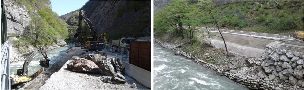
Abb. 23: Neuerrichtete Behelfsrampe (links) und abgerutschte Böschung der Salzachtal Straße (B 159) bei km 25,4 (rechts) während der Sanierungsmaßnahmen im April (© Fotos: Kurt Holztrattner/Land Salzburg; Quelle: Webseite des Landes Salzburg) [21], [22].
