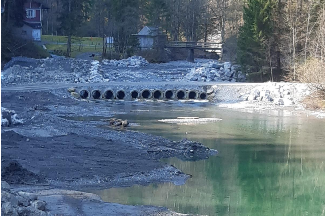
Abb. 21: Die nach den Felsstürzen im Rappenloch am 18. und 20. März 2020 neuerrichtete Furt am oberen Ende des Staufensees (© Foto: Stadt Dornbirn; Quelle: Webseite der Stadt Dornbirn) [23].
