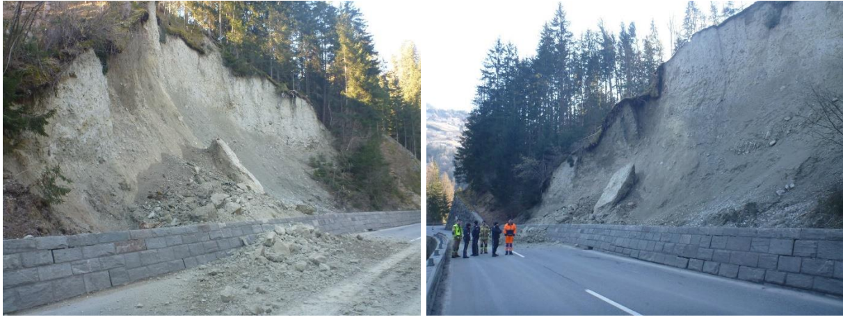
Abb. 25: Felssturzareal vom 7. März 2020 an der Pitztalstraße (L 16) bei km 9,5 im Gemeindegebiet von Wenns (Bundesland Tirol) (© Fotos: Thomas Figl/Land Tirol; Quelle: Webseite des Landes Tirol) [25].
