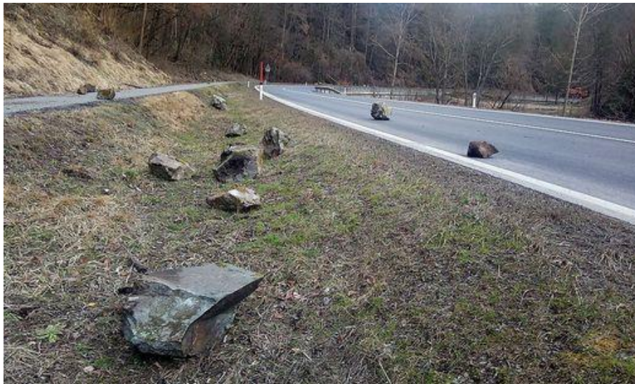
Abb. 32: Sturzblöcke am Radweg und auf der Mariazeller Straße (B 20) bei km 125 im Gemeindegebiet von Thörl (Bundesland Steiermark) nach dem Felssturz am 11. März 2020 (© Foto: STED/Land Steiermark; Quelle: „Kleine Zeitung“-online) [32].
