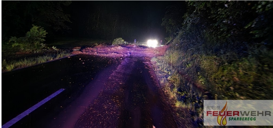
Abb. 30: Hangmure auf die Elsenauerstraße (L 423) etwa bei Straßenkilometer 1,2 im Gemeindegebiet von Pinggau (Bundesland Steiermark) in der Nacht vom 5. auf den 6. Juni 2022 (© Foto: Freiwillige Feuerwehr Sparbereg; Quelle: Webseite der Freiwilligen Feuerwehr Sparbereg) [44].
