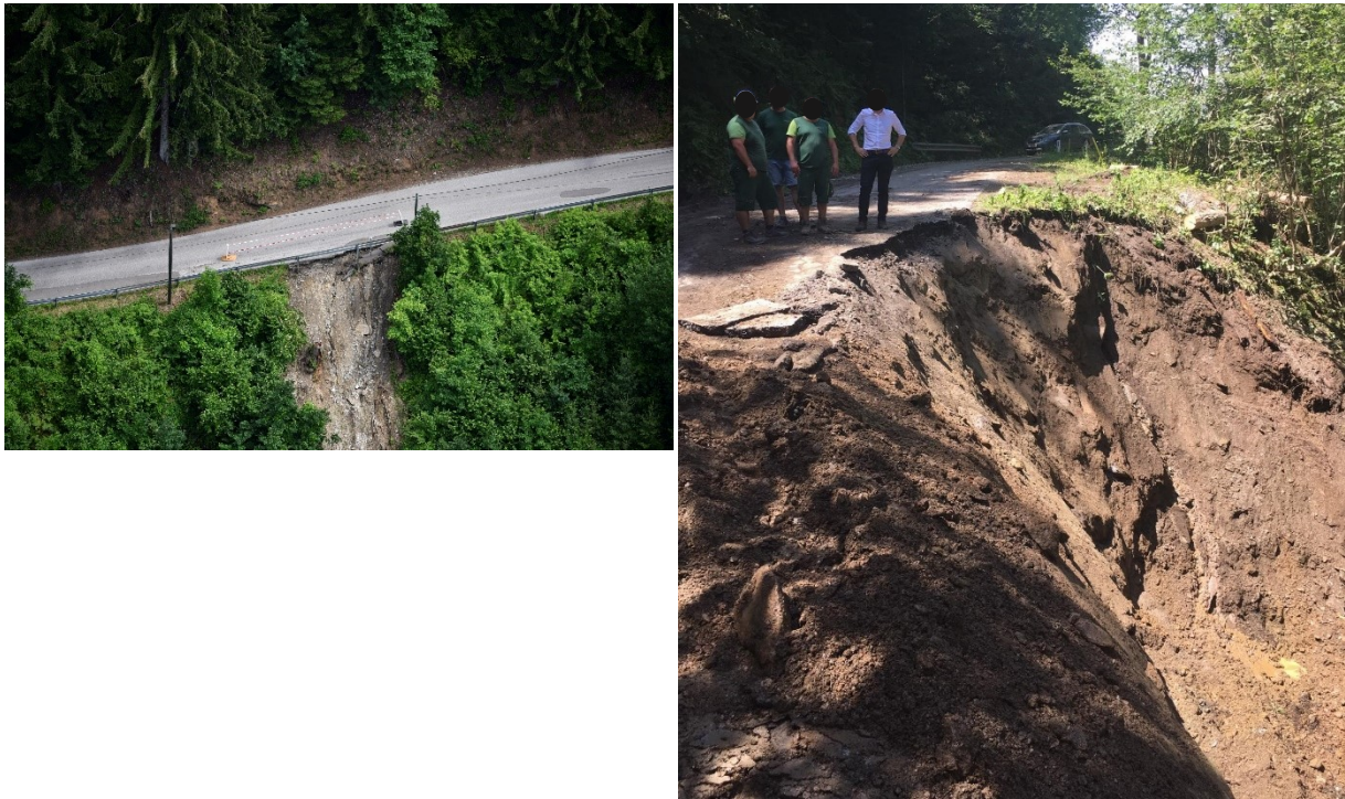
Abb. 62: Talseitige Böschungsrutschungen an einer Straße im Gemeindegebiet von Arriach oder Treffen am Ossischer See (Bundesland Kärnten) (linkes Bild) und an der Buchholzer Straße (L 45a) (rechtes Bild) (© Foto links: Michael Schoberleitner/Österreichisches Bundesheer (BMLV); Quelle: Webseite des Bundesministeriums für Landesverteidigung [1]; © Foto rechts: Büro LR Gruber/Landespressediens (LPD) Kärnten; Quelle: Webseite des Landes Kärnten [91]).
