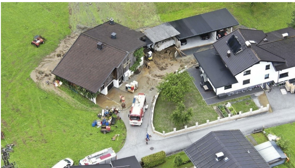
Abb. 12: Das von der Hangmure in den frühen Nachtstunden des 6. Juni 2022 getroffene Wirtschaftsgebäude im Ortsteil Oberfelben auf der westlichen Seite des Felbertales in der Stadtgemeinde Mittersill (Bundesland Salzburg) (© Foto: Landespolizeidirektion für Salzburg; Quelle: „Kronen Zeitung“-online) [21].
