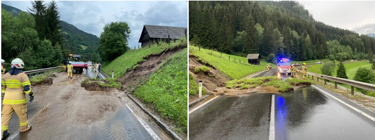
Abb. 51: Hangmure vom Abend des 28. Juni 2022 auf die Turracher Straße (B 95) ca. bei Straßenkilometer 85,28 zwischen Kendlbruck und Ramingstein im Gemeindegebiet von Ramingstein (Bundesland Salzburg) (© Fotos: Freiwillige Feuerwehr Ramingstein; Quelle: Webseite der Freiwilligen Feuerwehr Ramingstein) [71].
