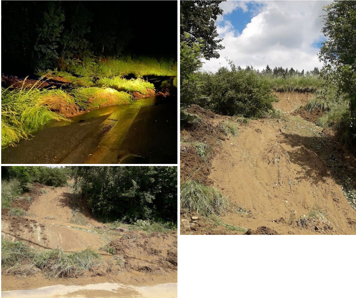
Abb. 32: Eine der Hangmuren kurz nach ihrem Abgang in der Nacht vom 5. auf den 6. Juni 2022 (linkes Bild oben) und bei Tageslicht mit Fließbahn und Ablagerungsbereich (linkes Bild unten) bzw. mit Abrissbereich samt Fließbahn (rechtes Bild) an einer Straßenböschung im Gemeindegebiet von Schöffern (Bundesland Steiermark) (© Fotos: Freiwillige Feuerwehr Schöffern; Quelle: Webseite der Freiwilligen Feuerwehr Schöffern) [45].
