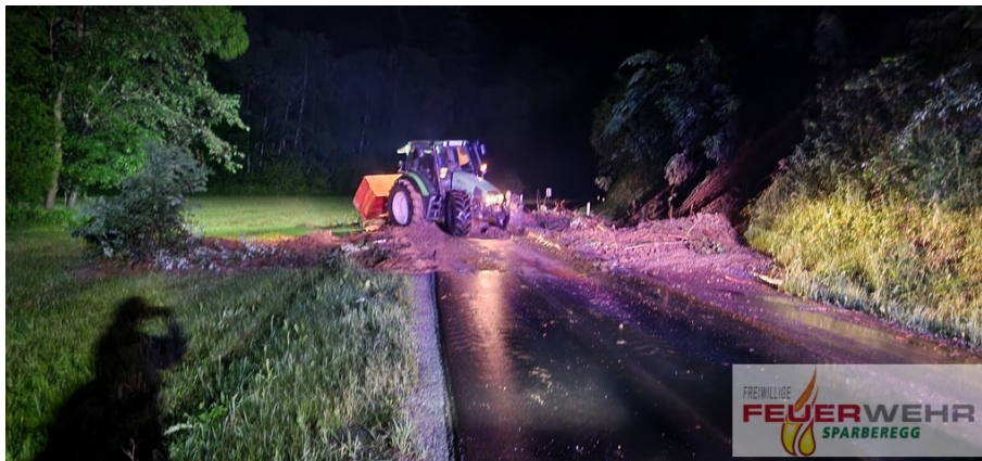
Abb. 31: Hangmure auf die Elsenauerstraße (L 423) etwa bei Straßenkilometer 1,2 im Gemeindegebiet von Pinggau (Bundesland Steiermark) in der Nacht vom 5. auf den 6. Juni 2022 (© Foto: Freiwillige Feuerwehr Sparbereg; Quelle: Webseite der Freiwilligen Feuerwehr Sparbereg) [44].
