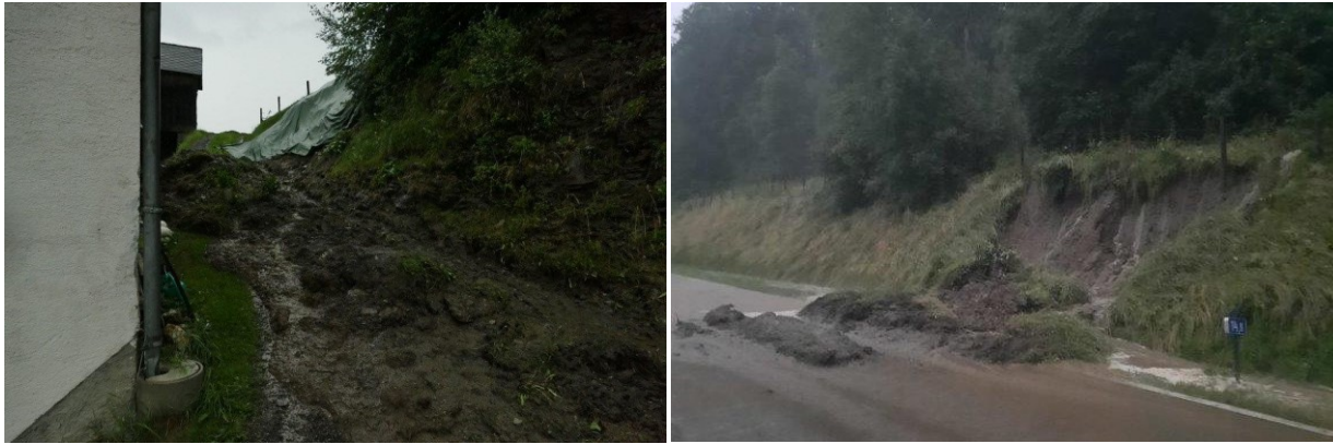
Abb. 65: Hangmure vom 29. Juni 2022 bei einem bäuerlichen Anwesen am Sonnberg in der Gemeinde Stadl-Predlitz (Bundesland Steiermark) (linkes Bild) und bergseitige Böschungsruutschung an der Murauer Straße (B 97) ca. bei Straßenkilometer 14,0 in Falkendorf in der Gemeinde Sankt Georgen am Kreischberg (Bundesland Steiermark) (rechtes Bild) (© Fotos: Walter Horn/Bereichsfeuerwehrverband Murau; Quelle: Webseite des Bereichsfeuerwehrverbandes Murau) [96].
