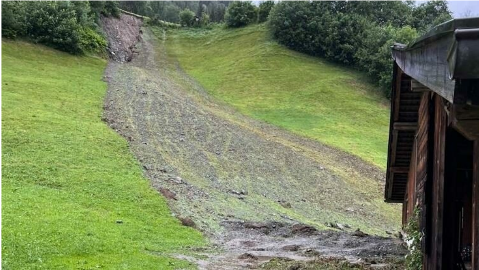
Abb. 11: Hangkante mit Abrissbereich und Fließbahn jener Hangmure im Ortsteil Oberfelben auf der westlichen Seite des Felbertales in der Stadtgemeinde Mittersill (Bundesland Salzburg), die in den frühen Nachtstunden des 6. Juni 2022 zwei Menschen verletzte (© Foto: privat; Quelle: „Kronen Zeitung“-online) [21].
