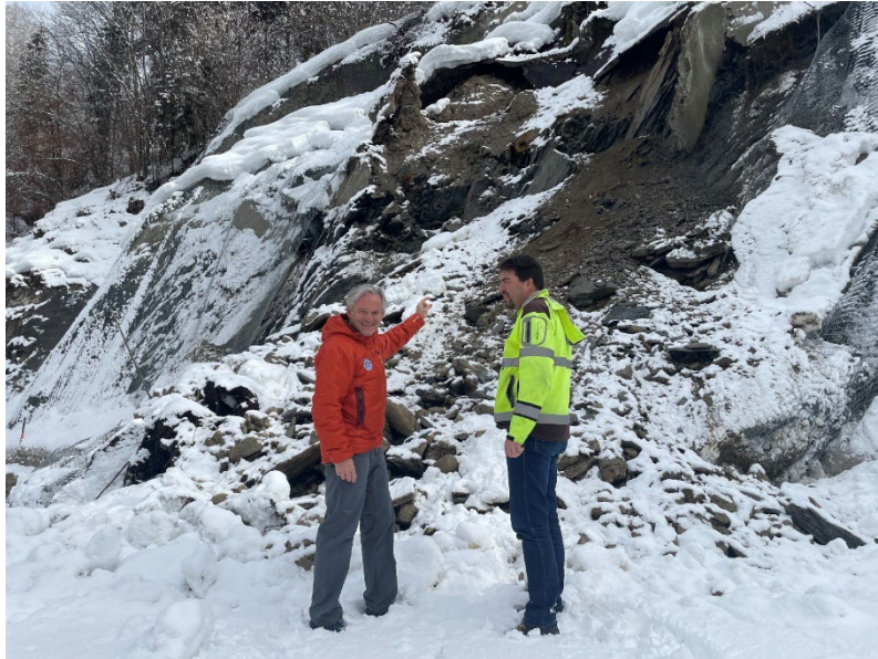
Abb. 24: Böschung mit abgeglittenem Gesteinsmaterial an der Katschbergstraße (B 99) im Raum Sonnhalb zwischen Pöham und Hütttau im Gemeindegebiet von Hütttau (Bundesland Salzburg) am 22. Februar 2022 (© Foto: Land Salzburg/Straßenmeisterei Pongau; Quelle: Webseite des Landes Salzburg) [30].
