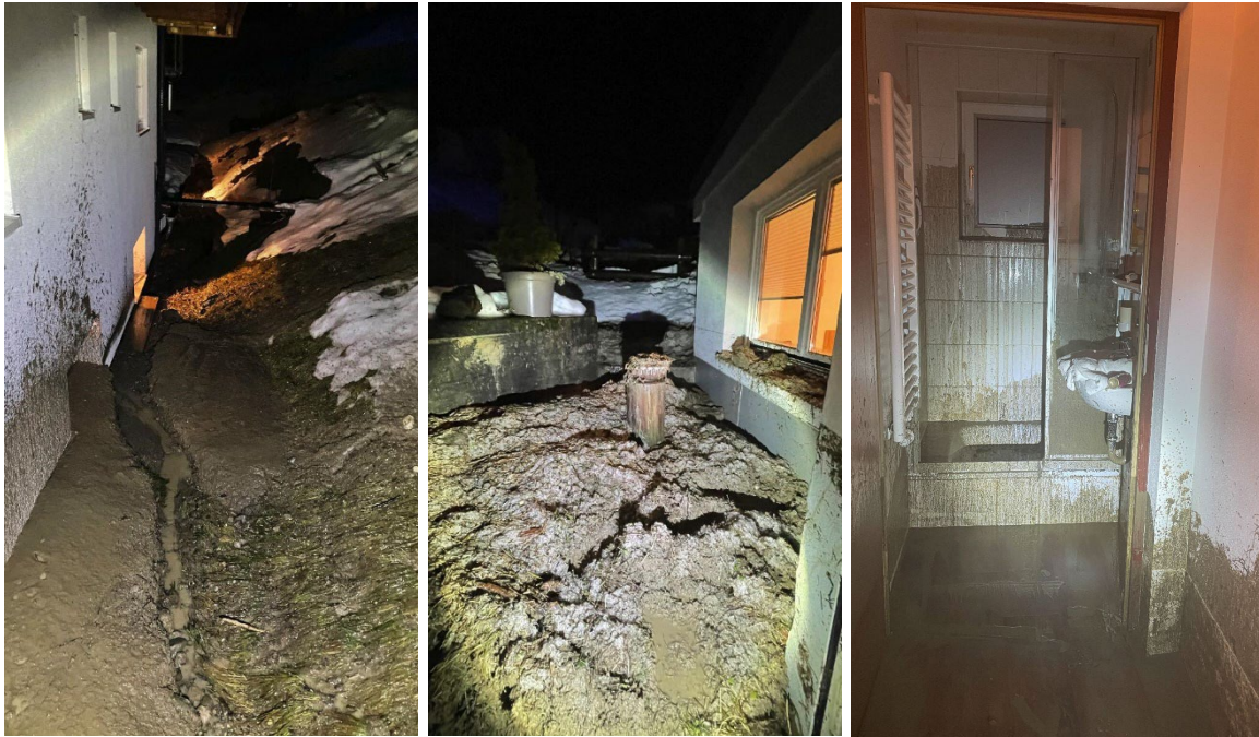
Abb. 7: Das durch die Folgen einer Hangrutschung in der Nacht des 30. Dezember 2021 in Hirschegg im Gemeindegebiet von Mittelberg (Bundesland Vorarlberg) schwer in Mitleidenschaft gezogene Wohngebäude im Bereich „Am Sonnenbühl“ (© Fotos: Freiwillige Feuerwehr Riezlern; Quelle: Webseite der Freiwilligen Feuerwehr Riezlern) [1].
