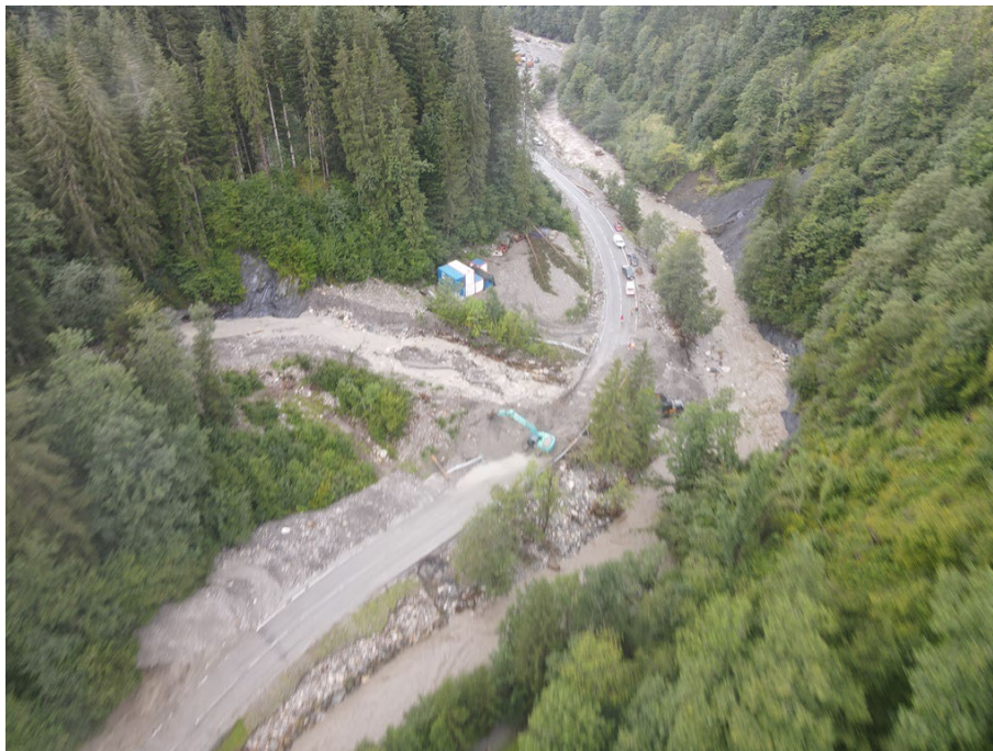
Abb. 27: Die schwer beschädigte Wagrainner Straße (B 163) im Gemeindegebiet von Sankt Johann im Pongau (Bundesland Salzburg) nach dem heftigen Unwetter vom Abend des 16. August 2021 mit dem Murkegel des Saugrabens in die Kleinarlerache (Bildmitte) und Uferanbrüchen auf der orografisch rechten Talseite (rechts im Bild) (© Foto: Gerald Valentin/Land Salzburg; Quelle: Webseite des Landes Salzburg) [14].
