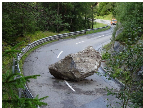
Abb. 16: Sturzblock auf der Kühntaistraße (L 237) nach dem Felssturz in der Nacht auf den 23. August 2021 im Abschnitt zwischen Ochsegarten in der Gemeinde Haiming und Mühlau in der Gemeinde Oetz im Gemeindegebiet von Oetz (Bundesland Tirol) (© Foto: Land Tirol; Quelle: Webseite des Landes Tirol) [18].
