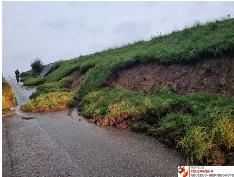
Abb. 25: Böschungsrutschungen am Abend des 16. August 2021 an einer Gemeindestraße im Ortsteil Neuzeug in der Gemeinde Sierning (Bundesland Oberösterreich) (© Foto: Freiwillige Feuerwehr Neuzeug-Sierninghofen; Quelle: Webseite der Freiwilligen Feuerwehr Neuzeug-Sierninghofen) [26].
