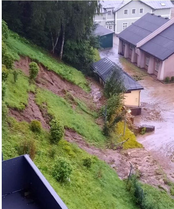
Abb. 30: Hangrutschungen vom 16. August 2021 zwischen der Südtirolersiedlung und der Kroatinkaserne in der Stadtgemeinde Sankt Johann im Pongau (Bundesland Salzburg) (© Foto: Freiwillige Feuerwehr Sankt Johann im Pongau; Quelle: Webseite der Freiwilligen Feuerwehr Sankt Johann im Pongau) [33].
