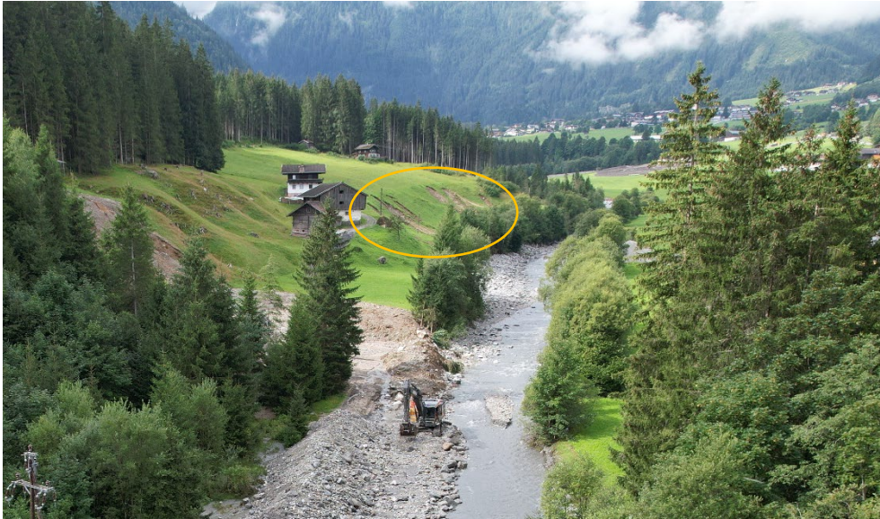
Abb. 15: Hangrutschungen vom Abend des 16. August 2021 am orografisch rechten Einhang der Krimmler Ache im Ortsteil Unterkrimml der Gemeinde Krimml (Bundesland Salzburg) (gelbe Umrahmung) (© Foto: Militärkommando Salzburg/Bundesministerium für Landesverteidigung; Quelle: Webseite des Bundesministeriums für Landesverteidigung) [1].
