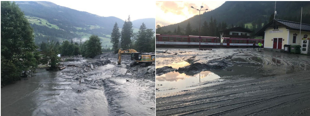
Abb. 10: Die Situation am 15. August 2021 im Bereich Bräuergraben–Krimmler Ache (linkes Bild) und am Bahnhof Krimml (rechtes Bild) in der Gemeinde Wald im Pinzgau (Bundesland Salzburg) nach dem ersten von drei Murenabgängen im Bräuergraben (© Fotos: Gebhard Neumayer/WLV; Quelle: Webseite des Landes Salzburg) [11].
