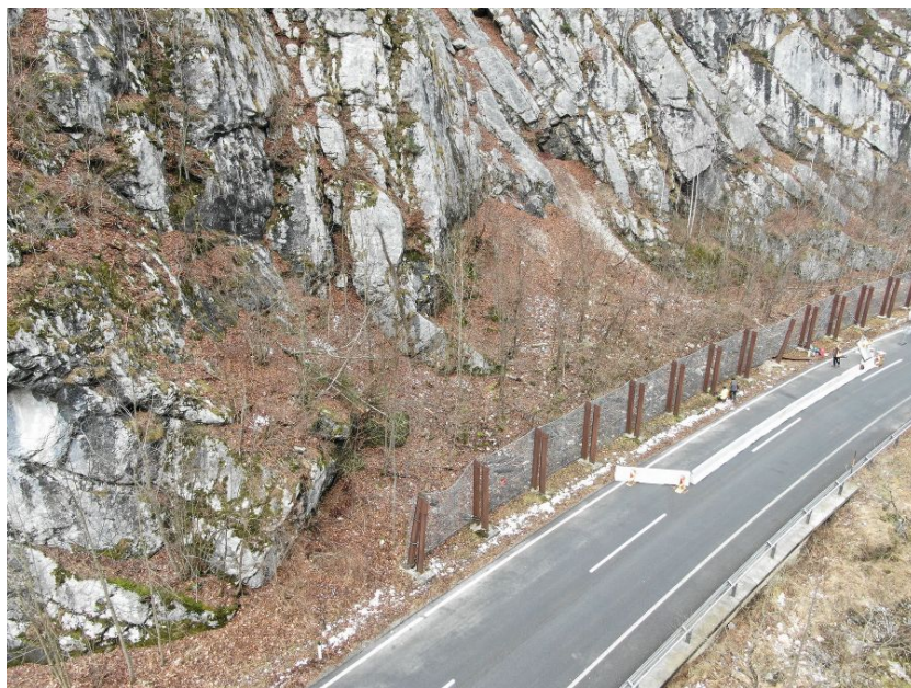
Abb. 39: Beschädigtes Steinschlagschutzbauwerk an der Gesäuse Straße (B 146) etwa auf Höhe des Straßenkilometers 108,4 zwischen Hieflau und Gstatterboden im Gemeindegebiet von Hieflau (Bundesland Steiermark) infolge des Steinschlages vom 7. Dezember 2020 (© Foto: FA 16 Straßenerhaltungsdienst/Land Steiermark; Quelle: Webseite des Landes Steiermark) [41].
