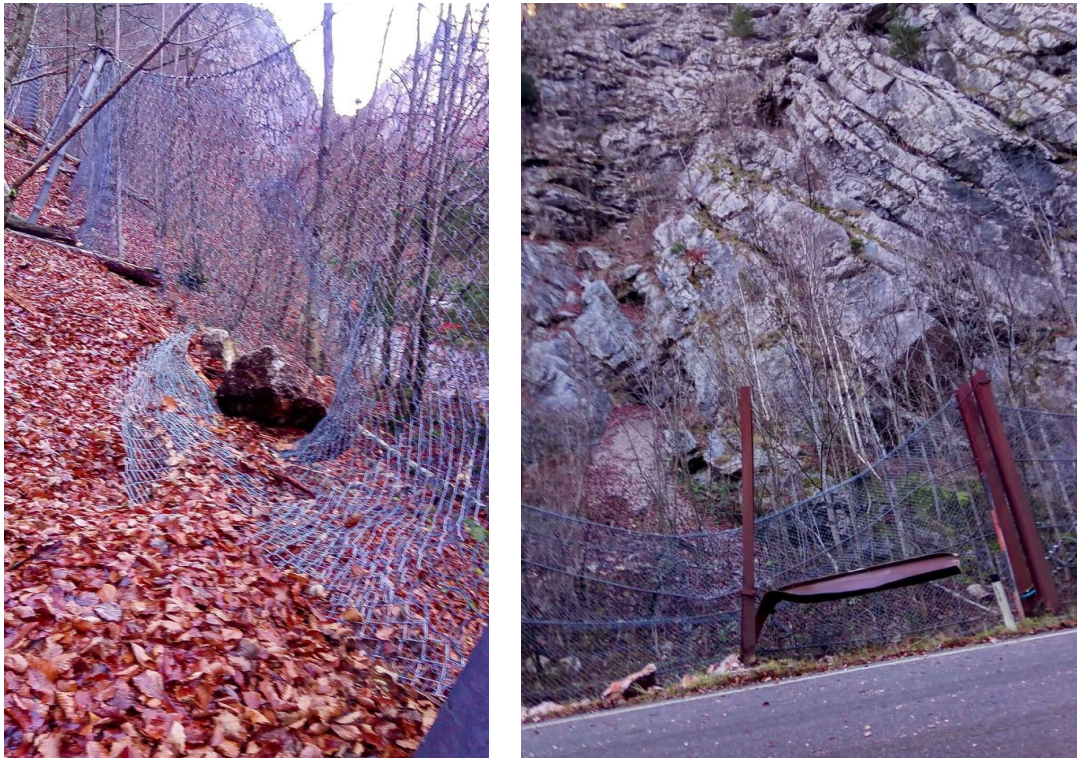
Abb. 38: Steinschlagschutznetz mit abgestürzten und akkumulierten Felsblöcken (links) und durch den Steinschlag am 7. Dezember 2020 beschädigtes Steinschlagschutzbauwerk (rechts) an der Gesäuse Straße (B 146) etwa auf Höhe des Straßenkilometers 108,4 zwischen Hieflau und Gstatterboden im Gemeindegebiet von Hieflau (Bundesland Steiermark) (© Fotos: FA 16 Straßenerhaltungsdienst/Land Steiermark; Quelle: Facebook-Seite des Straßenerhaltungsdienstes STED des Landes Steiermark) [39].
