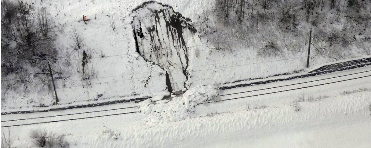
Abb. 28: Böschungsrutschung auf die Gleise der Tauernbahnstrecke auf Höhe Hinteregg–Kreuzbichl in der Gemeinde Bad Hofgastein (Bundesland Salzburg) am 6. Dezember 2020 (© Foto: Wahl/ÖBB; Quelle: ORF-online) [30].
