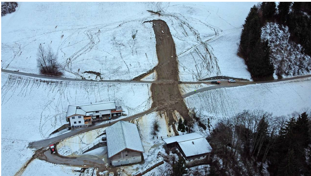
Abb. 22: Hangmure (Bildmitte) und kleinere Hangrutschung an der Straßenböschung (mittig in linker Bildhälfte) auf die Innerbergstraße im Bereich „Maurach“ in der Gemeinde Kolsassberg (Bundesland Tirol) vom 6. Dezember (© Foto: Georg Köchler/„Zoom-Tirol“; Quelle: ORF-online) [17].
