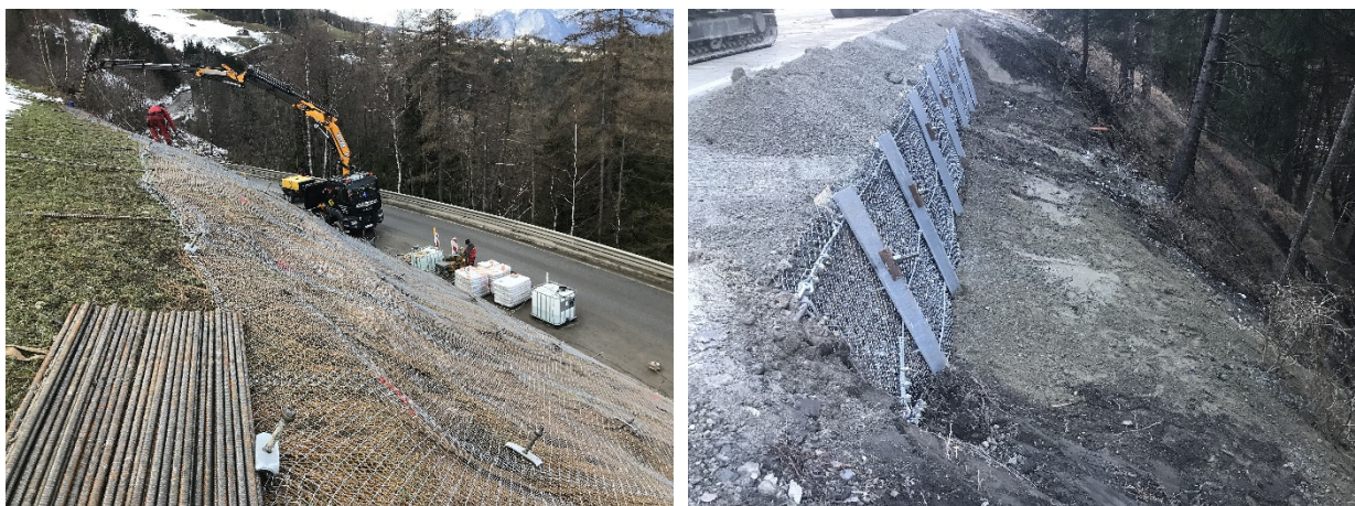
Abb. 17: Berg- (links) und talseitige (rechts) Sanierungsmaßnahmen an der Brenner Straße (B 182) zwischen dem Gasthof Stefansbrücke und Matreiwald in den Gemeindegebieten von Schönberg im Stubaital und Mühlbachl (Bundesland Tirol) nach den Böschungsrutschungen vom 6. Dezember 2020 (© Fotos: Wildauer/BBA Innsbruck; Quelle: Webseite des Landes Tirol) [16].
