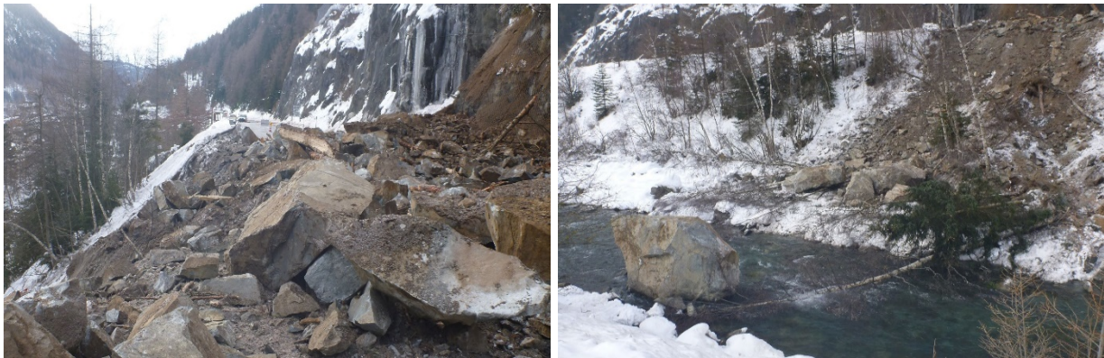
Abb. 12: Sturzblöcke des Felssturzes auf der dadurch zerstörten Asphaltdecke der Ötztalstraße (B 186) auf Höhe des Straßenkilometers 33,960 südlich des Gehöretunnels (links) und in der Ötztaler Ache (rechts) im Gemeindegebiet von Sölden (Bundesland Tirol) vom 17. Dezember 2020 (© Fotos: Land Tirol; Quelle: Webseite des Landes Tirol) [8].
