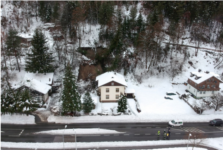
Abb. 24: Abgerutschter Hang hinter einem Wohnhaus an der Pustertaler Straße in der Stadtgemeinde Lienz (Bundesland Tirol) vom 7. Dezember 2020. Am rechten Bildrand ist unmittelbar unterhalb eines Weges die Abrisskante einer initialen Hangrutschung erkennbar (© Foto: Roman Wagner/„Dolomitenstadt“; Quelle: „Dolomitenstadt“-online) [27].
