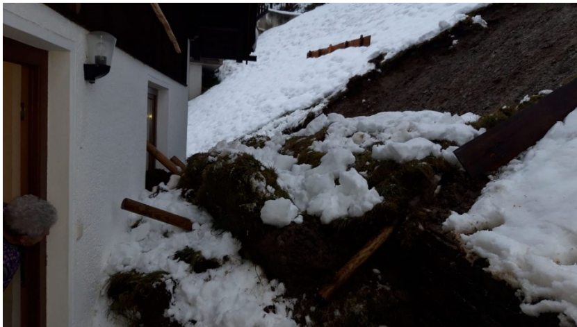
Abb. 19: Teil der durch die Hausmauer aufgehaltenen und abgelenkten Rutschmasse bei einem Gebäude in Mühlthal in der Gemeinde Ellbögen (Bundesland Tirol) am 6. Dezember 2020 (© Foto: Freiwillige Feuerwehr Ellbögen; Quelle: Webseite der Freiwilligen Feuerwehr Ellbögen) [22].
