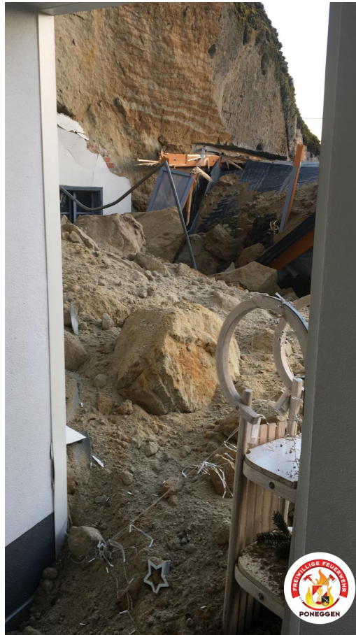
Abb. 9: Sandsteinwand mit einem Teil des Abbruchbereiches und der Sturzmasse des Felssturzes vom 27. Dezember 2020 im Ortsteil Poneggen der Gemeinde Schwertberg (Bundesland Oberösterreich) (© Foto: Freiwillige Feuerwehr Poneggen; Quelle: Webseite der Freiwilligen Feuerwehr Poneggen) [7].
