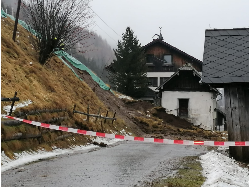
Abb. 37: Hangrutschung vom 6. Dezember 2020 bei einem Anwesen im Ortsteil Fresen der Gemeinde Ranten (Bundesland Steiermark) (© Foto: Freiwillige Feuerwehr Peterdorf; Quelle: Webseite der Freiwilligen Feuerwehr Peterdorf) [38].
