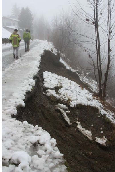
Abb. 23: Böschungsrutschung an der Innerbergstraße auf Höhe des Anwesens Innerbergstraße Nr. 12 in der Gemeinde Kolsassberg (Bundesland Tirol) vom 6. Dezember (© Foto: Andreas Reiter/Freiwillige Feuerwehr Kolsassberg; Quelle: Webseite der Freiwilligen Feuerwehr Kolsassberg) [24].
