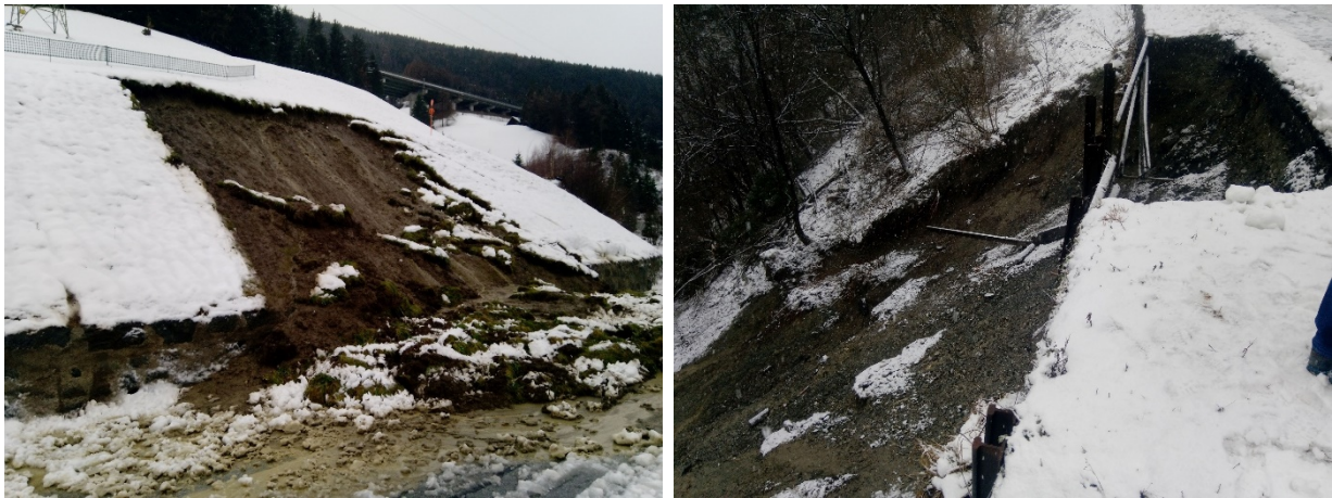
Abb. 16: Berg- (links) und talseitige (rechts) Böschungsrutschungen an der Brennerstraße (B 182) zwischen dem Gasthof Stefansbrücke und Matreiwald in den Gemeindegebieten von Schönberg im Stubaital und Mühlbachl (Bundesland Tirol) vom 6. Dezember 2020 (© Fotos: Roman Außerlechner/Land Tirol; Quelle: Webseite des Landes Tirol) [15].
