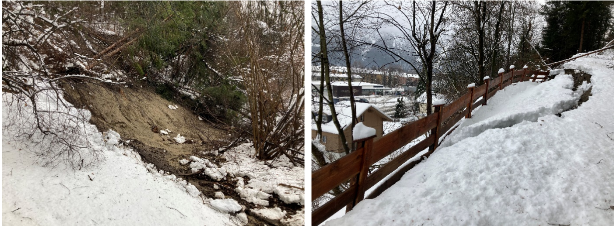
Abb. 26: Abgerutschter, mit Bäumen bestockter Hang hinter einem Wohnhaus an der Pustertaler Straße (links) in der Stadtgemeinde Lienz (Bundesland Tirol) und Abrisskante einer initialen Rutschung im Bereich eines Weges (rechts) am selben Hangareal vom 7. Dezember 2020 (© Fotos: Stadtfeuerwehr Lienz; Quelle: Webseite der Stadtfeuerwehr Lienz) [26].
