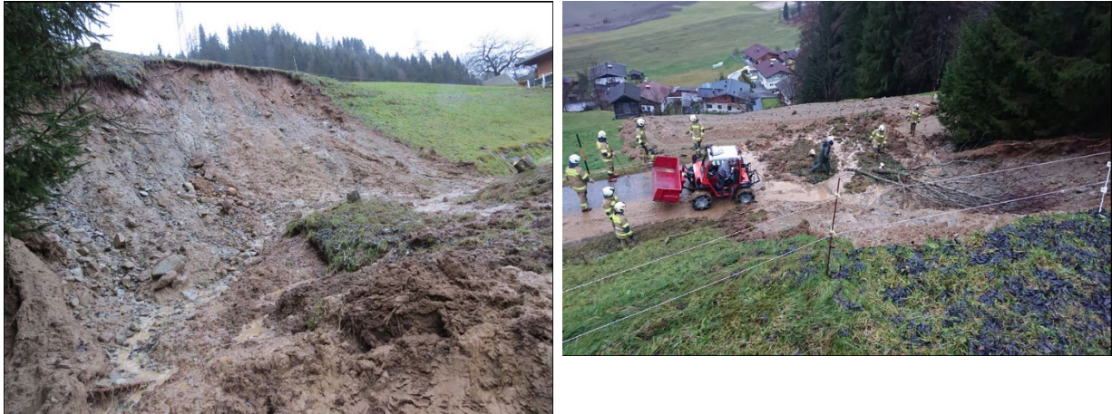
Abb. 30: Abrisskante der Hangmure (links) vom 6. Dezember 2020 und durch diese in Mitleidenschaft gezogener Weg (rechts) im Ortsteil Wenns in der Gemeinde Bramberg am Wildkogel (Bundesland Salzburg) (© Fotos: Freiwillige Feuerwehr Bramberg am Wildkogel; Quelle: Webseite der Freiwilligen Feuerwehr Bramberg am Wildkogel) [34].
