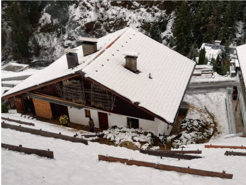
Abb. 18: Hangrutschung bei einem Gebäude in Mühlthal in der Gemeinde Ellbögen (Bundesland Tirol) am 6. Dezember 2020 (© Foto: Freiwillige Feuerwehr Ellbögen; Quelle: Webseite der Freiwilligen Feuerwehr Ellbögen) [22].
