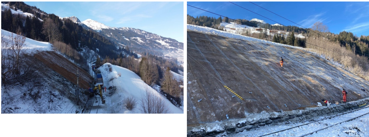
Abb. 29: Areal der Böschungsrutschung an der Tauernbahnstrecke auf Höhe Hinteregg–Kreuzbichl in der Gemeinde Bad Hofgastein (Bundesland Salzburg) vom 6. Dezember 2020 während der Sanierungsmaßnahmen (© Fotos: Krammel/ÖBB; Quelle: Webseite der Österreichischen Bundesbahnen) [32].
