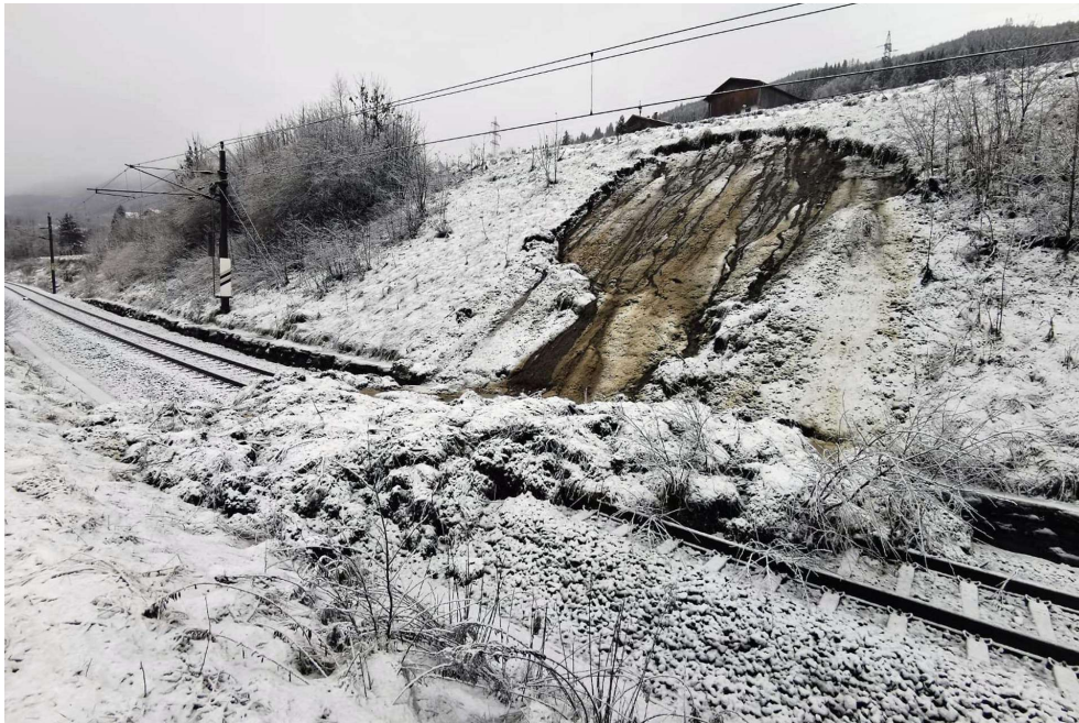
Abb. 27: Berichterstattung zur Hangrutschung auf die Gleise der Tauernbahnstrecke auf Höhe Hinteregg–Kreuzbichl in der Gemeinde Bad Hofgastein (Bundesland Salzburg) am 6. Dezember 2020 (© Foto: Krammel/ÖBB; Quelle: ORF-online) [30].
