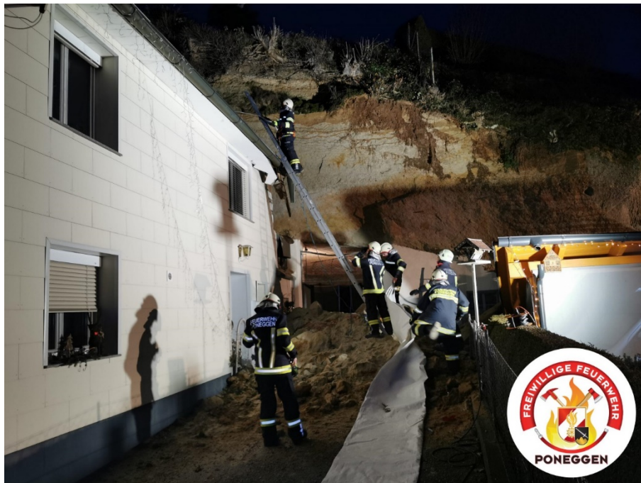
Abb. 8: Sandsteinwand mit dem Abbruchbereich des Felssturzes vom 27. Dezember 2020 und das durch diesen beschädigte Wohngebäude im Ortsteil Poneggen der Gemeinde Schwertberg (Bundesland Oberösterreich) (© Foto: Freiwillige Feuerwehr Poneggen; Quelle: Webseite der Freiwilligen Feuerwehr Poneggen) [7].
