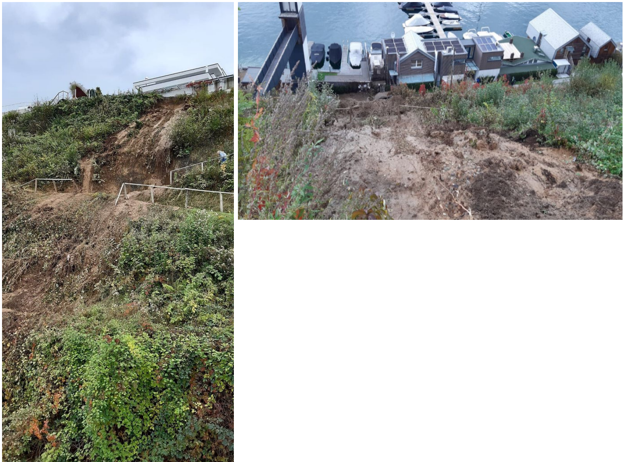
Abb. 22: Die Hangmure am bergseitigen Hang der Wörthersee-Süduferstraße (L 96) etwa auf Höhe des Straßenkilometers 7,6 in Reifnitz im Gemeindegebiet von Maria Wörth (Bundesland Kärnten) am 12. Oktober 2020 (© Fotos: Freiwillige Feuerwehr Reifnitz; Quelle: Webseite der Freiwilligen Feuerwehr Reifnitz) [32].
