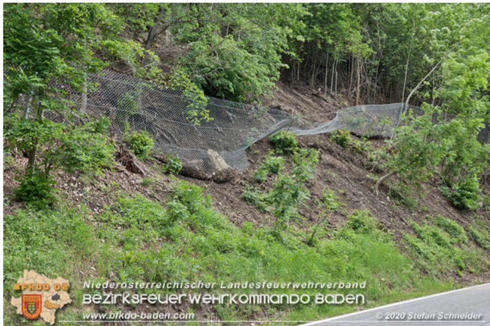
Abb. 26: Steinschlagschutzzaun an der Badener Straße (B 210) nahe Sattelbach in der Gemeinde Heiligenkreuz mit am 23. Mai 2020 aufgefangenen Sturzblöcken (© Foto: Stefan Schneider/Bezirksfeuerwehrkommando Baden; Quelle: Webseite des Bezirksfeuerwehrkommandos Baden) [20].
