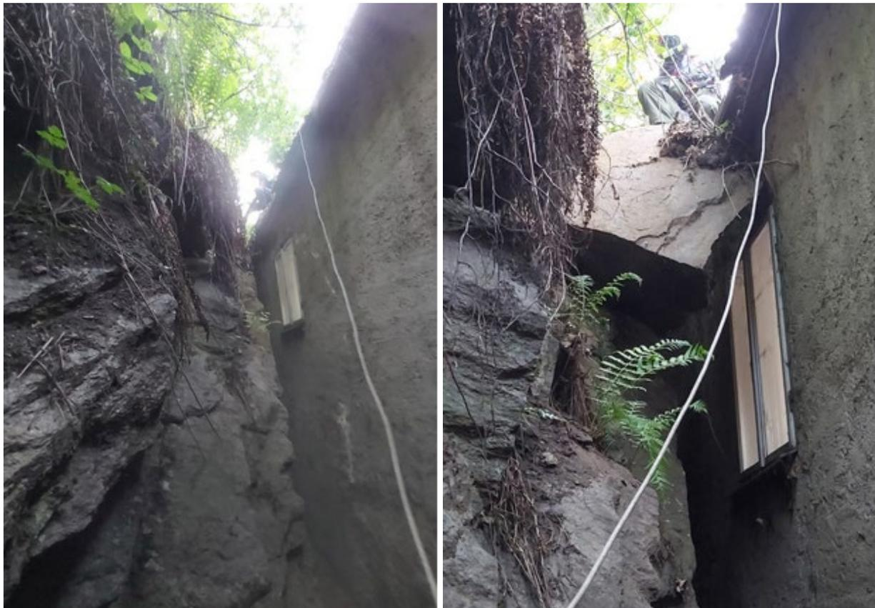
*Abb. 20: Felswand und Hausmauer (links: nach Beseitigung des Blockes) mit dazwischen verkeilt Felsbrocken (rechts) nach dem Blocksturz vom 8. Mai 2020 im Stadtgebiet von Zwettl (Bundesland Niederösterreich) (© Fotos: Freiwillige Feuerwehr Zwettl-Stadt; Quelle: Webseite der Freiwilligen Feuerwehr Zwettl-Stadt) [12].*
