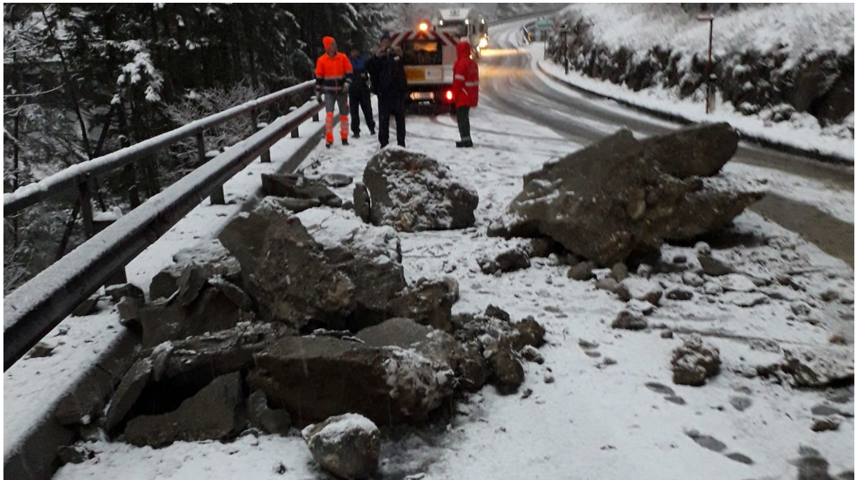
Abb. 10: Sturzblöcke des Felssturzes auf die Eisenstraße (B 115) bei km 96,900 zwischen der Wandaubücke und Lainbach im Gemeindegebiet von Landl (Bundesland Steiermark) am 27. Dezember 2019 (© Foto: Straßenmeisterei Sankt Gallen; Quelle: „Kleine Zeitung“-online) [6].
