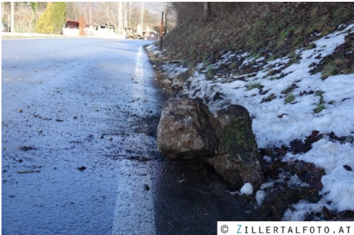
Abb. 17: Sturzblock des Felssturzes auf die Rotholzer Straße (L 218) im Gemeindegebiet von Buch in Tirol am 31. Jänner 2020 (© Foto: M. Sporer; Quelle: Webseite von „Zillertalfoto“) [18].
