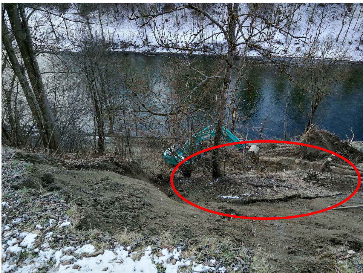
Abb. 21: Bild der Scholle (roter Kreis) vor ihrem Abgleiten Richtung Murauer Straße (B 97) bei km 4,7 in der Gemeinde St. Georgen am Kreischberg (Bundesland Steiermark) während der Aufräumarbeiten (© STED Steiermark; Quelle: Facebook-Seite des Straßenerhaltungsdienstes des Landes Steiermark) [30].
