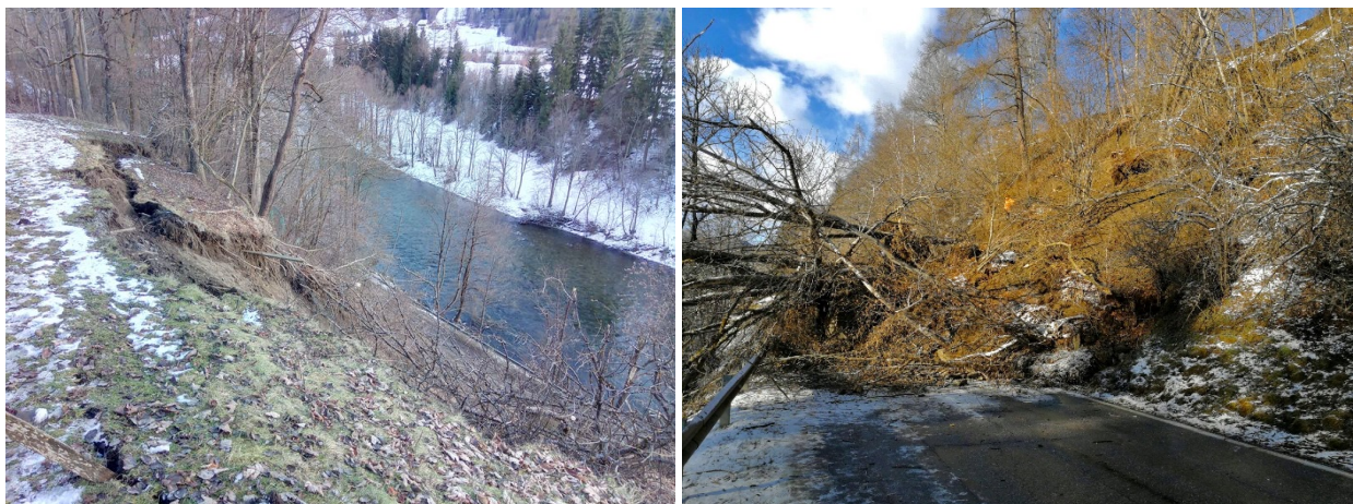
Abb. 18: Hangrutschung auf die Murauer Straße (B 97) bei km 4,7 im Gemeindegebiet von St. Georgen am Kreischberg (Bundesland Steiermark) am 28. Dezember 2019 mit Abrisskante (links) und Rutschmasse (rechts) (© Peter Haselmann/„Kleine Zeitung“; Quelle: „Kleine Zeitung“-online) [1].
