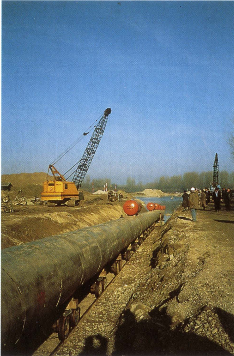
Abb. 108. Bau der TAG II durch die ÖMV Aktiengesellschaft – Vorbereitung der Donauquerung
