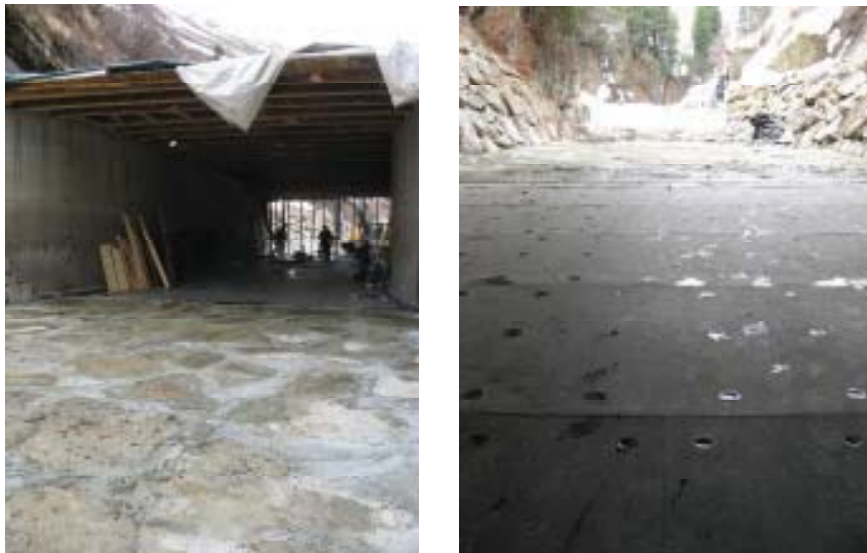
Abbildung 4: links - Blick vom Oberwasser über den neu gestalteten Einlaufbereich des Messgerinnes (glatt verlegte Flussbausteine), sichtbar ist noch die Einhausung der Messstelle; rechts - Blick in Richtung Oberwasser (16.04.2009) über die neu verlegten Gummiplatten des Messgerinnes (Fotos: HD Tirol)
