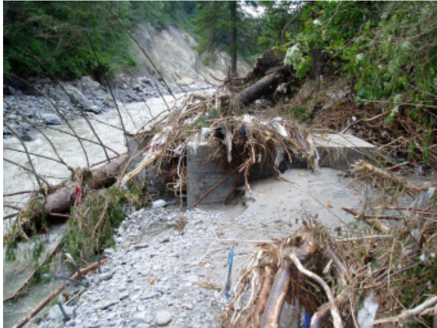
Abbildung 6: Zerstörter Pegel Strengen-Rosanna
