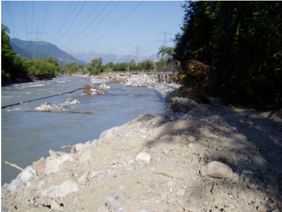
Abbildung 9: Beschädigte Autobahn in Nenzing und freigelegte Gasleitung
