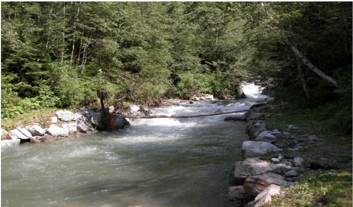
Abb. 11: beschädigter Pegel Habach / Habache – 14. Juli 2005
