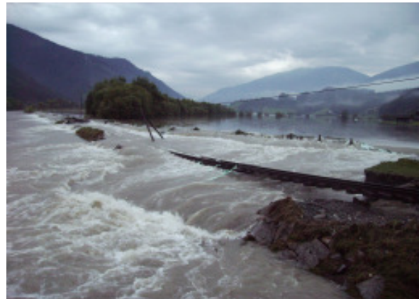
Abb. 14: Dammbürche bei Rettenbach
