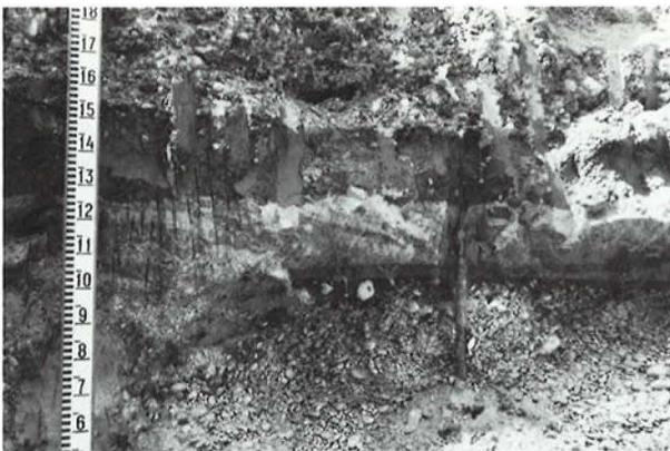
Abb. 26: Schnitt durch den Damm in Höhe der alten Dammkrone.
