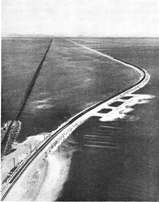
Abb. 14: Eisenbahndamm durch den Great Salt Lake. Fertiggestellter Damm.
