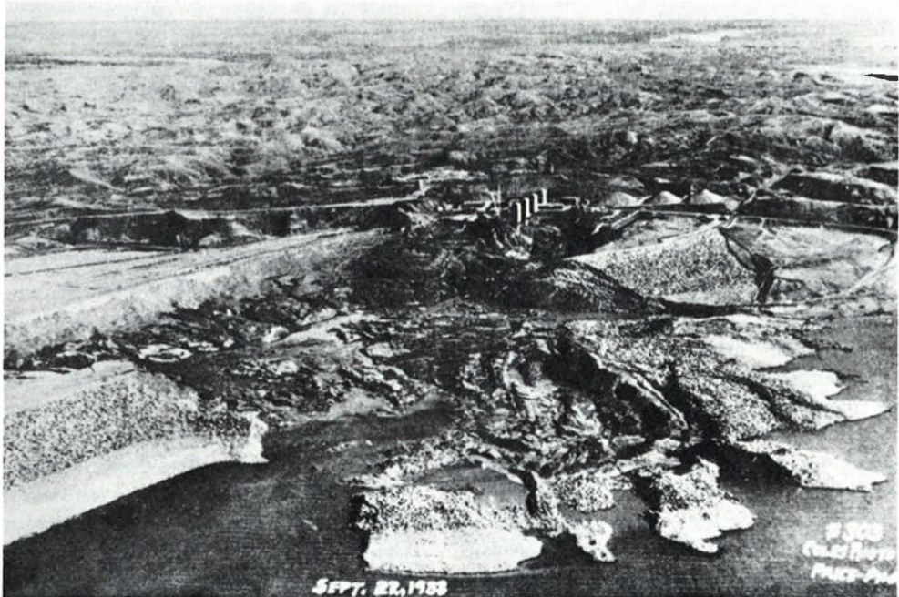
Abb. 8: Fort-Peck-Damm, Schrägansicht der Rutschung.
