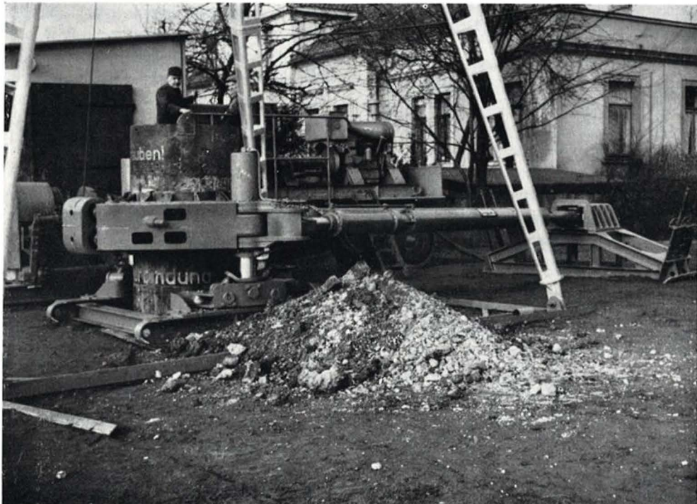
ABB. 1 Bade-Verrohrungsmaschine — Einzelaggregat
