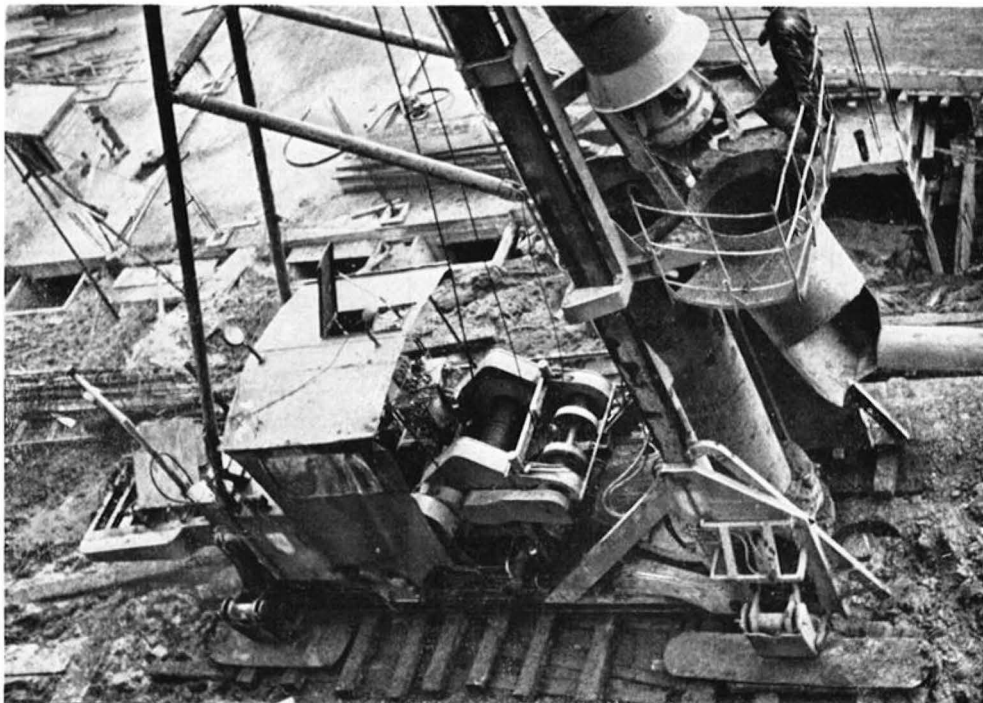
ABB. 2 BENOTO-Bohranlage EDF 55
