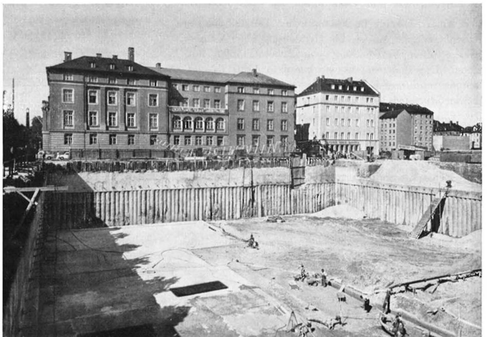
ABB. 10 Baugrube für die Bayerische Gemeindebank in München
