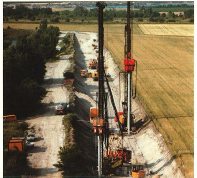
Abb. 11: Schmalwandherstellung im Ostteil der Umschließung
