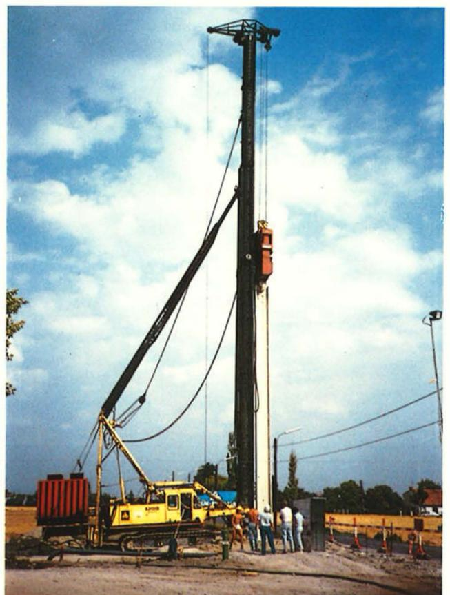
Abb. 8: Rammeinheit zur Herstellung von 25 m tiefen Schmalwänden
