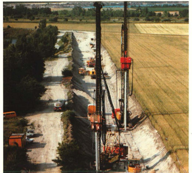
Abb. 11: Schmalwandherstellung im Ostteil der Umschließung Fig. 11: Thin diaphragm wall construction in the eastern part of the enclosure
