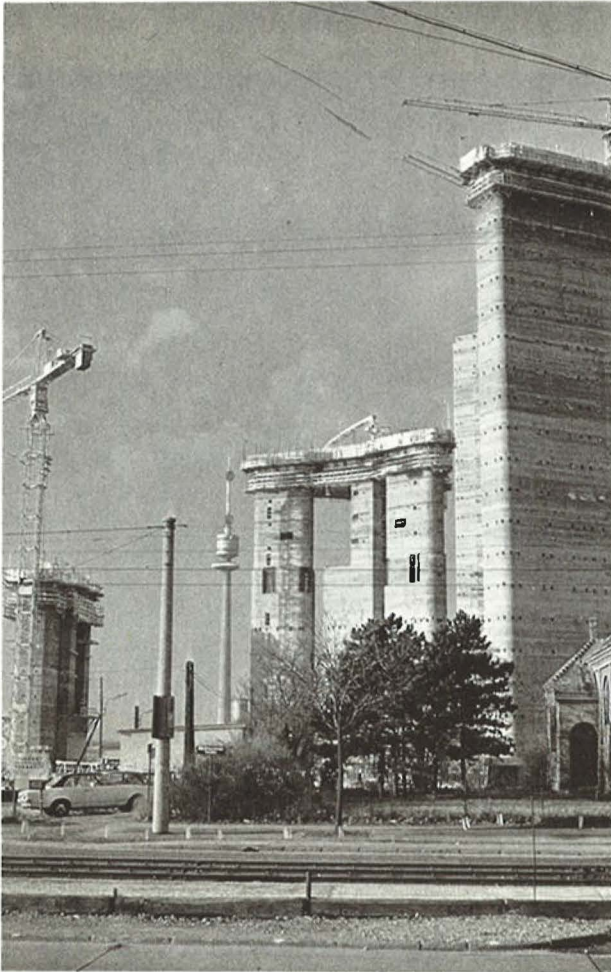
Abb. 21: UNO-City: Stiegenhaustürme im Bau
