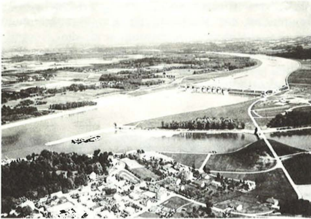
Abb. 13: Donaukraftwerk Wallsee nach Fertigstellung
