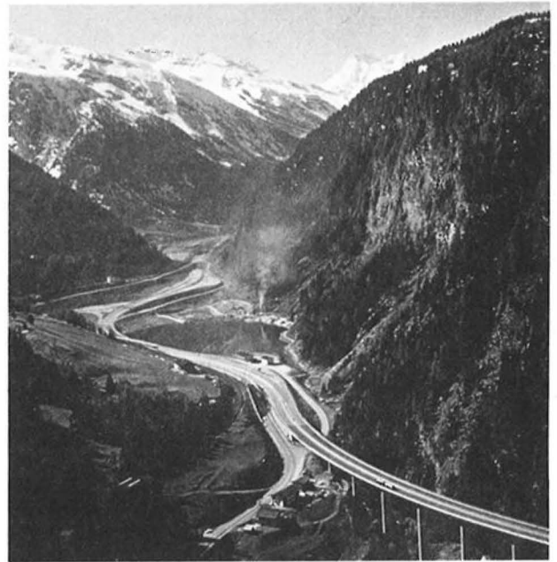
Abb. 26: Brennerautobahn im Bereich Brennersee in Betrieb
