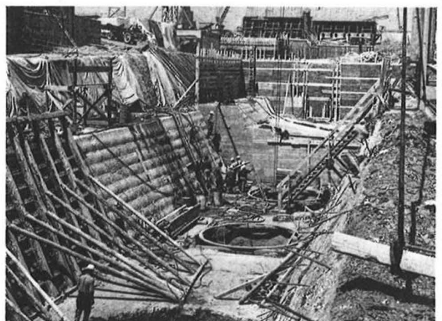
Abb. 12: Donaukraftwerk Wallsee. Baugrube eines Wehrpfeilers
