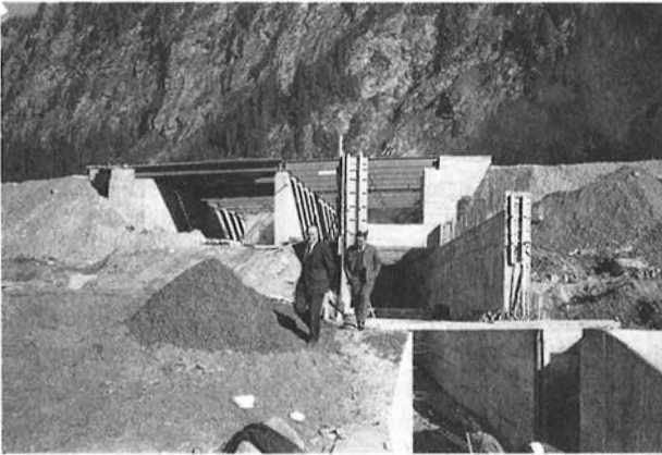
Abb. 24: Autobahnbrücke über einen Wildbach im Bereich des Brennersees
