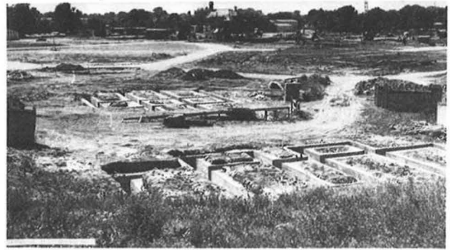
Abb. 19: UNO-City: Leitgräben für die Schlitzwände
