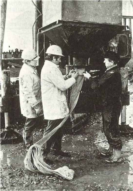
Bild 28: Vliesdrän: Befestigung des Filterschlauches am Fülltrichter (Foto: Chemie Linz A.G.)
