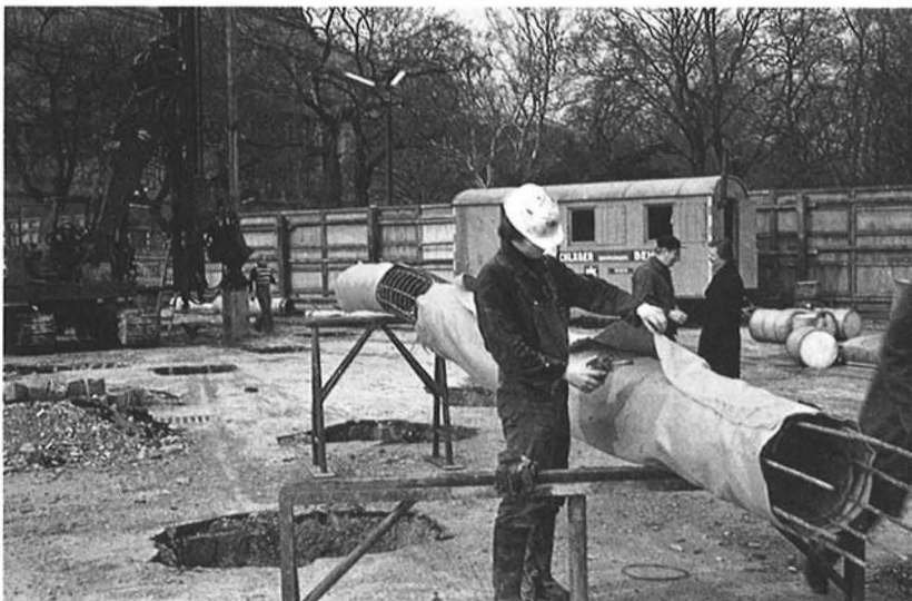
Bild 12: Ummantelung des Bewehrungskorbes eines Bohrpfahles mit Vlies; Verschweißen der Längsüberlappung mit Handschweißgerät
