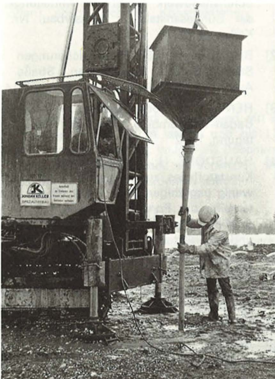
Bild 29: Absenken des mit Dränagesand 2/7 mm gefüllten Vliesdräns in das Bohrloch (Foto: Chemie Linz A.G.)
