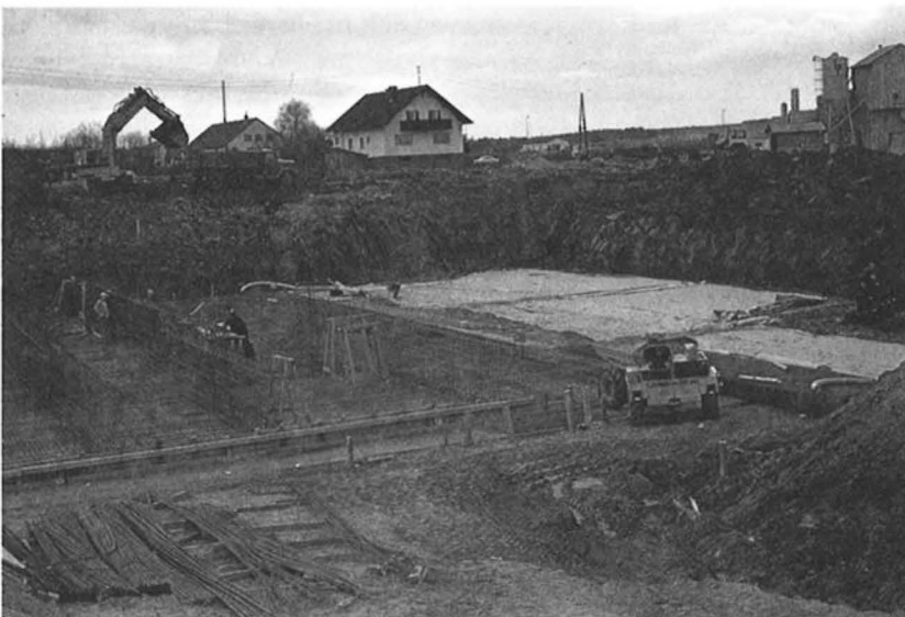
Bild 5: Plattenfundierung eines mehrgeschoßigen Hochbaues auf weichem schluffigem Ton: abschnittsweiser kleinflächiger Baugrubenaushub; Fundierungsohle und Drainagegräben mit Vlies abgedeckt bzw. ausgelegt, darauf sandiger Kies; rasches Betonieren der Sohlplatte
