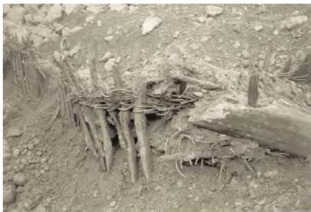
Abb. 10: Flechtzaun-Wuhrdamm errichtet zum Schutz von Bürs um 1800, 1850 vermurt durch die Schesa, gefunden 1994 ca. 30 m unter GOK rechtsufrig der Schesa in Bürs.
