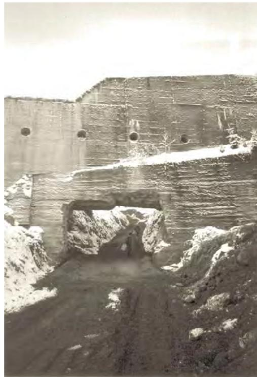
Abb. 13: Durchstoßung des Sperrenbauwerkes Nr. 91 für den Förderbandtunnel.
