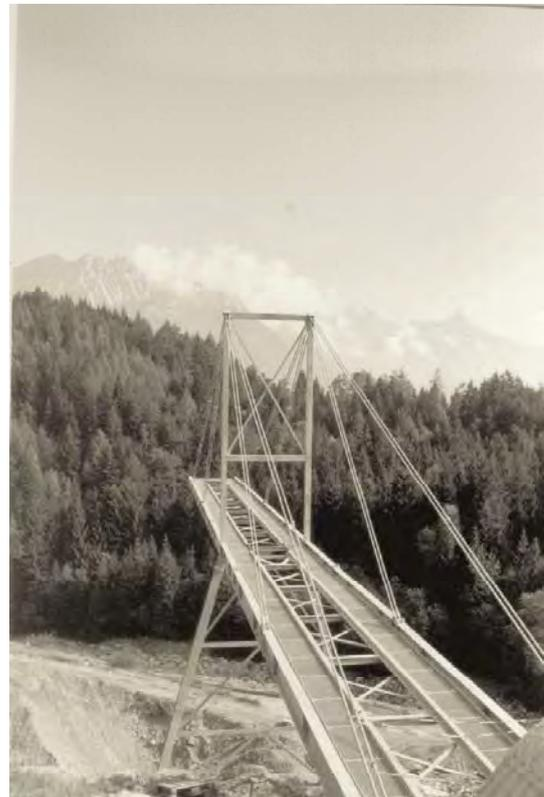
Abb. 11: Förderbandbrücke des Zwischendepots "Mattabübel".
