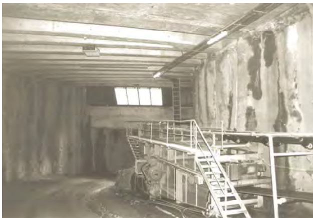
Abb. 12: Übergabestation zwischen den Förderbändern III und IV in der Pfahlwandstrecke des Zwischenbäch-Tunnels.
