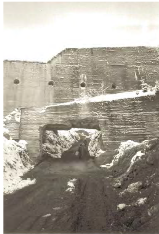
Abb. 13: Durchstoßung des Sperrenbauwerkes Nr. 91 für den Förderbandtunnel.
