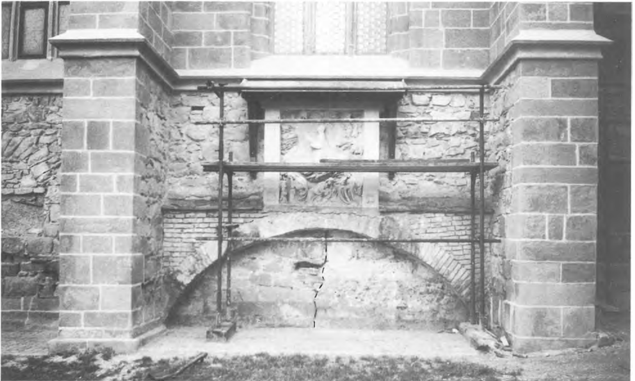
Abb. 2: Fassadenabschnitt 7 mit der Baufuge zwischen früh- und spätgotischer Bausubstanz.
