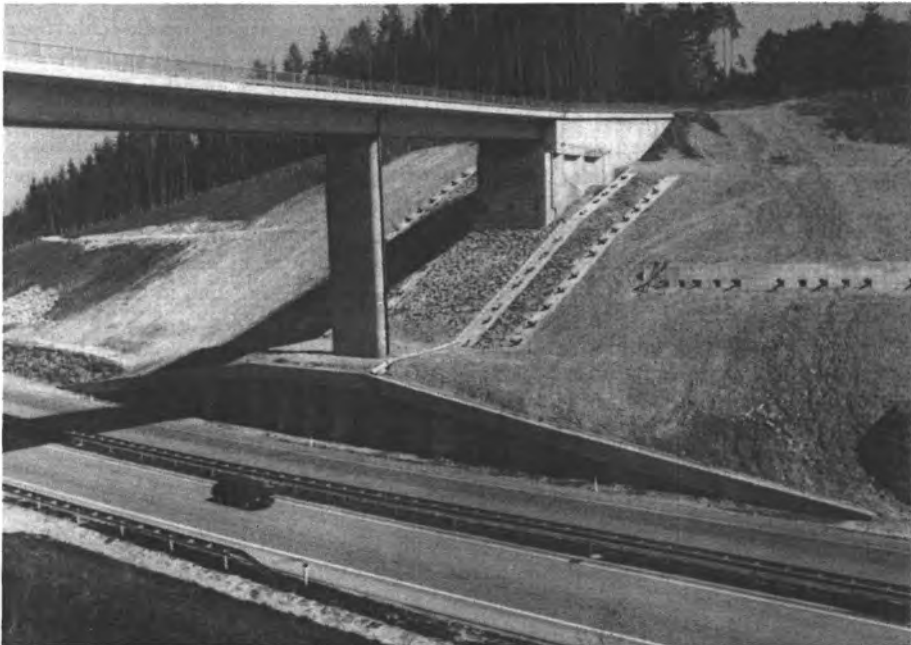
Abb. 23: Endgültige Böschungsherstellung mit allen Sanierungsmaßnahmen im Einschnitt E 16/17 – links.
