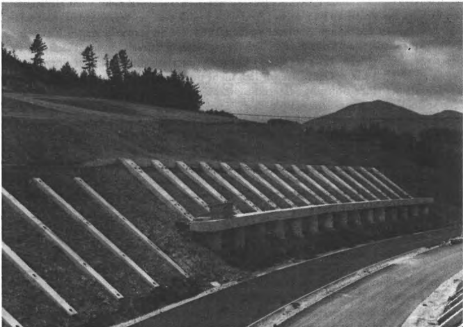
Abb. 10: Fertige Brunnenwand mit Ankerbalken im Einschnitt E 8/9 – links.
