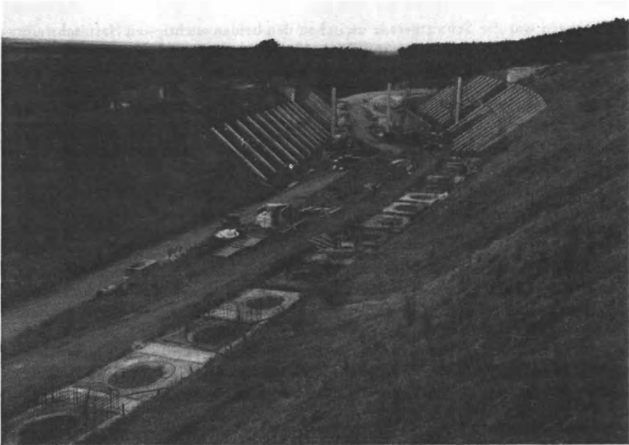
Abb. 9: Herstellung der Brunnenwand im Einschnitt E 8/9 – links (die elliptischen Brunnen reichen von links unten bis rechts oberhalb der Bildmitte).
