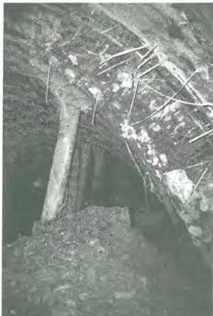
Abb. 10: Pölung in Teilabschnitten der Kalotte zur Verhinderung einer weiteren Zunahme von Firstsenkungen und eines Verbruches.
