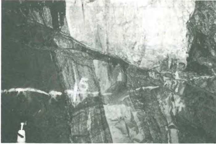
Abb. 21: Sperre Zillergündl – Flach talwärts in Richtung Luftseite ausfallende, sandig bis schluffig verfüllte Kluft am wasserseitigen Ulm auf Stollenstation 5 m des Sondierstollens.
