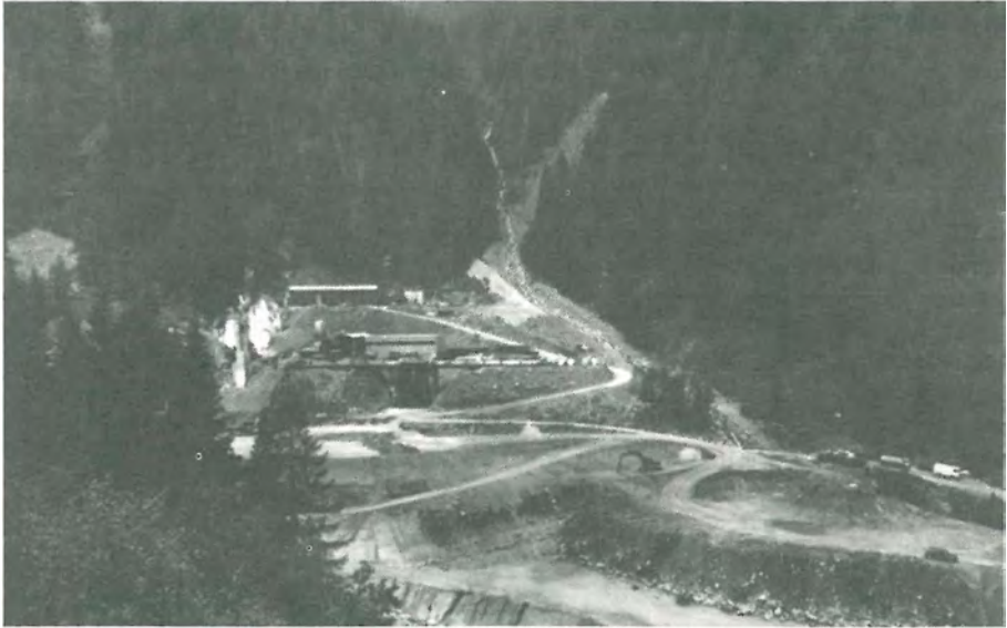
Abb. 5: Stollenanschlag der Draßnitz- und Lamnitzbachbeileitung im oberen Wöllatal.
