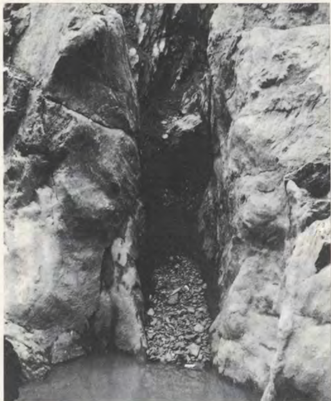
Abb. 7 : Störung 1 im Bachbettbereich, Öffnungsbreite unten etwa 2 m.
