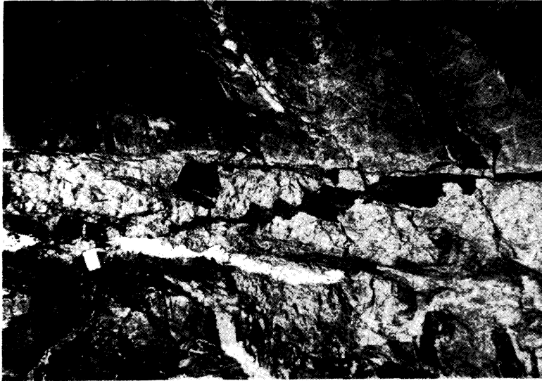
Abb.37: Riesenkluft der Kluftgruppe G mit zwei Hauptbewegungsbahnen und treppenförmiger Absetzung.
