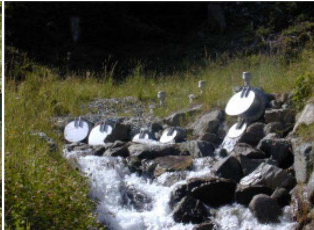
*Abbildung 3: Überlauf des gefassten Quellbereiches*
