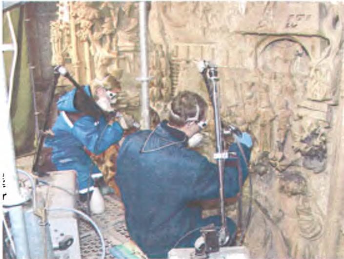
Abb.4: Laserreinigung eines gotischen Reliefs (Auer Kalksandstein) durch RestauratorInnen der Fa. E. Pummer
