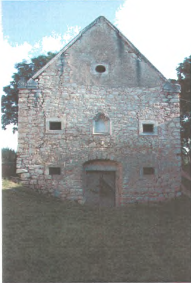
Abb. 8: Vollständig aus Zogelsdorfer Kalksandstein errichtetes Presshaus aus dem 18. Jahrhundert in Zogelsdorf.
