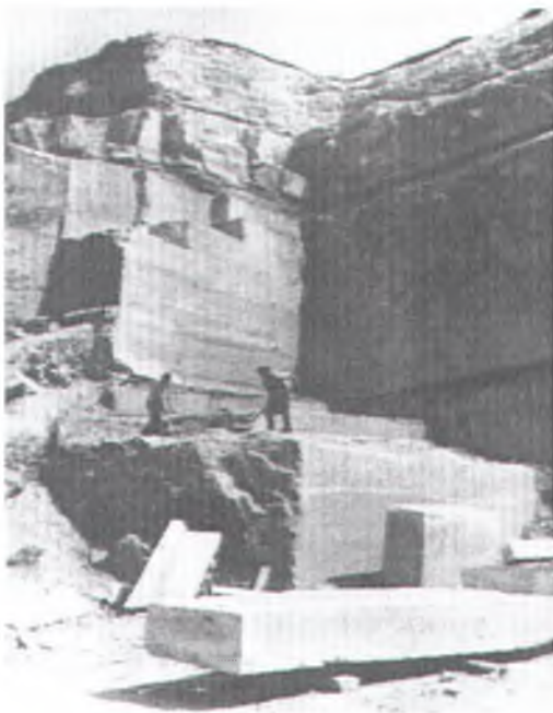
Abb. 6: Steinbruch St. Margarethen um 1930. Die beiden Arbeiter entfernen den Schrämschutt von der Oberfläche des „Kopfes“ (Bildarchiv Inst. f. Ingenieurgeologie, TU-Wien).
