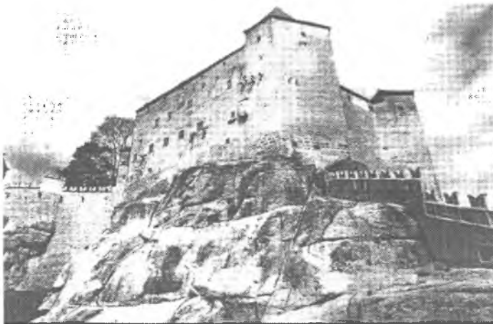
Abb. 21: Der Burgfelsen der Burg Rappottenstein besteht aus stark im Gefüge aufgelockertem Weinsberger Granit.
