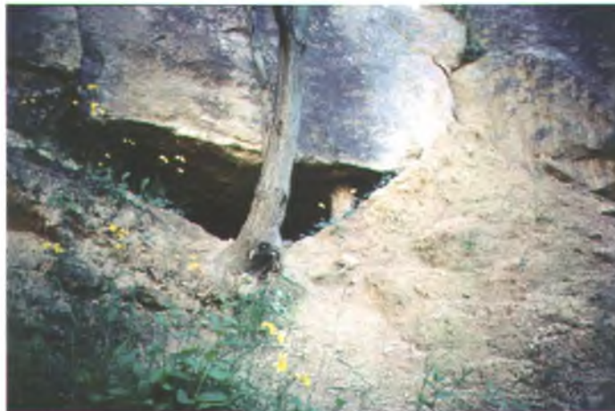
Abb. 15: Abbau von Kluftkörpern durch Unterhöhlen im oberen Konglomeratsteinbruch des Rauchstallbrunngrabens.
