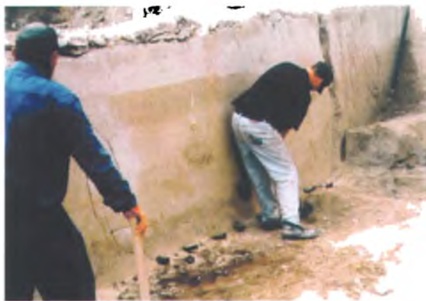
Abb. 11: Abkeilen der Rohblöcke vom Liegenden im Steinbruch St. Margarethen.
