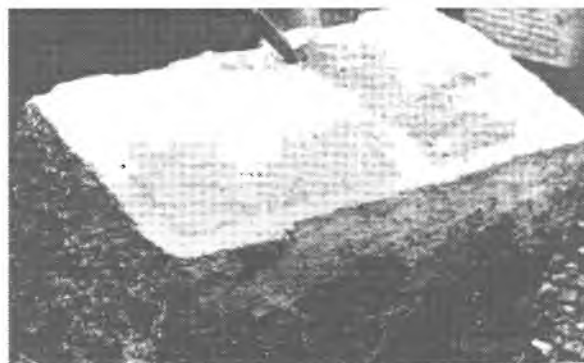
Abb. 25: Bearbeitung der Oberfläche mit dem Spitzeisen. Der innerhalb des Randschlages überstehende Stein wird Bosse genannt (um 1930).
