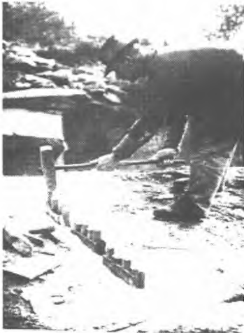
Abb. 17: Abkeilen eines Granitrohblockes: mehrere Keile werden zwischen Blechen in die Keilnut oder Keiltasche gesetzt und mit einem schweren Hammer gleichmäßig angezogen (um 1930, Archiv Inst. f. Ingenieurgeologie, TU-Wien).
